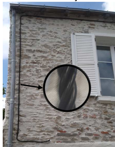
Réseau fils isolés façade BT
