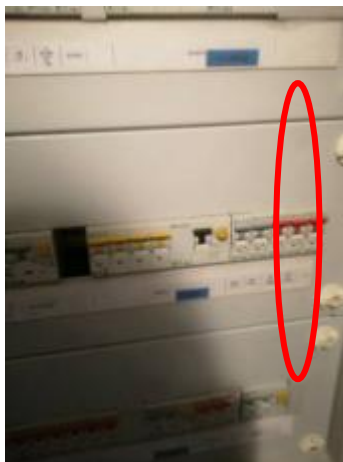
Contacteur VMC Bat B R+1 – 10 Amp
