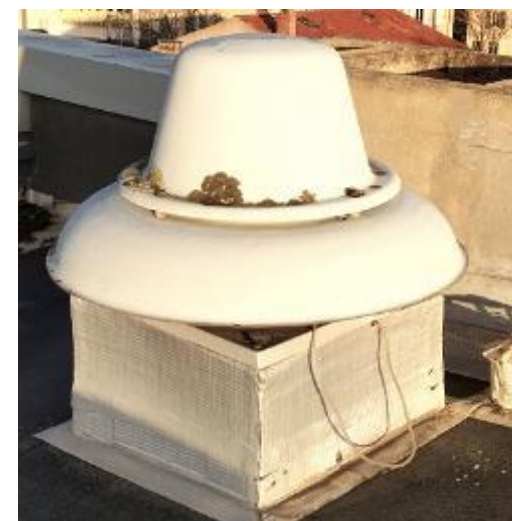
Normalement, Tourelle VMC Bureaux R+3, arrêtée
