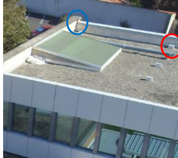
Gaines Toiture Bat B R+1 (Extraction en Rouge, Ancien Air Neuf en Bleu HS)
