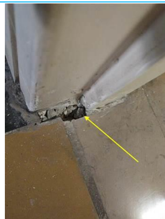
Matériaux : ZPSO-062 Prélèvement : P078 Description : Sol: Chape - Mortier colle Localisation : Entresol 0-1 - Couloir 2 Résultat : Absence d'amiante
