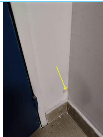
Matériaux : ZPSO-069 Prélèvement : P085 Description : Cloisons: Bandes calicot+enduits+Placoplatre Localisation : Rez de chaussée - Escalier 1 Résultat : Absence d'amiante
