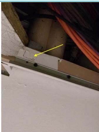
Matériaux : ZPSO-061 Prélèvement : P077 Description : Murs maîtres: Bandes calicot+enduits+Placoplatre Localisation : Entresol 0-1 - Couloir 2 Résultat : Absence d'amiante
