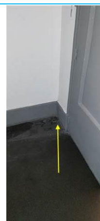
Matériaux : ZPSO-044 bis Prélèvement : P057 bis Description : Sol: Lino noir Localisation : 1er étage - Couloir 1 Résultat : Absence d'amiante
