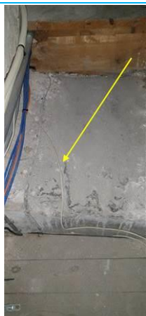
Matériaux : ZPSO-003 Prélèvement : P003 Description : Sol embrasure : Ragréage ciment + chape plâtre Localisation : COMBLES - Pavillon 3 Résultat : Absence d'amiante
