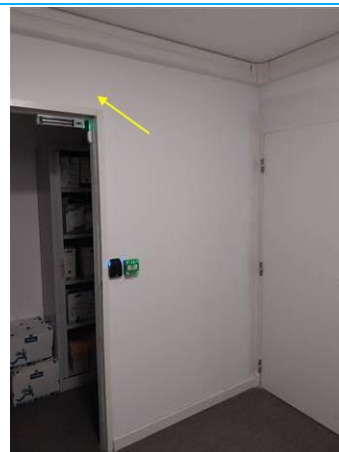
Matériaux : ZPSO-048 Prélèvement : P061 Description : Cloisons: Bandes calicot+enduits+Placoplatre Localisation : 1er étage - Couloir 4 Résultat : Absence d'amiante
