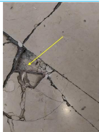
Matériaux : ZPSO-041 Prélèvement : P054 Description : Sol: Chape - Mortier colle Localisation : 1er étage - Escalier Rostand Résultat : Absence d'amiante
