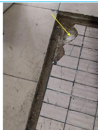
Matériaux : ZPSO-046 Prélèvement : P059 Description : Sol (Tapis): colle jaune+ chape Localisation : 1er étage - Escalier Rostand Résultat : Absence d'amiante
