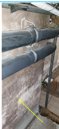
Matériaux : ZPSO-002 Prélèvement : P005 Description : Embrasures passages: Enduit plâtre + Enduit ciment Localisation : COMBLES - Pavillon 4 Résultat : Absence d'amiante
