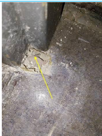
Matériaux : ZPSO-056 Prélèvement : P071 Description : Sol: Lino gris/mauve + Colle + ragréage gris Localisation : 1er étage - Couloir 5 Résultat : Absence d'amiante
