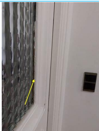
Matériaux : ZPSO-040 Prélèvement : P053 Description : Portes: Mastic de vitrage Localisation : 2ème étage - Couloir 4 Résultat : Présence d'amiante
