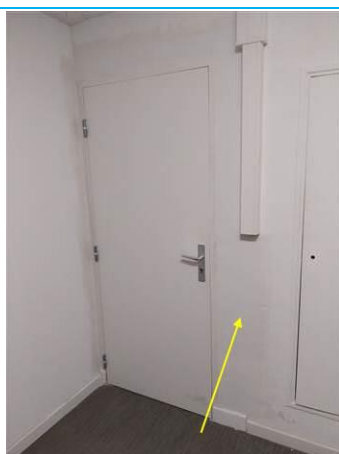
Matériaux : ZPSO-049 Prélèvement : P062 Description : Cloisons (dures): Enduits à base de plâtre + toile de verre +colle Localisation : 1er étage - Couloir 4 Résultat : Absence d'amiante
