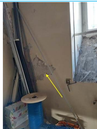
Matériaux : ZPSO-090 Prélèvement : P106 Description : Murs maîtres :Enduits à base de ciment Localisation : Sous-Sol - Local VMC Résultat : Absence d'amiante
