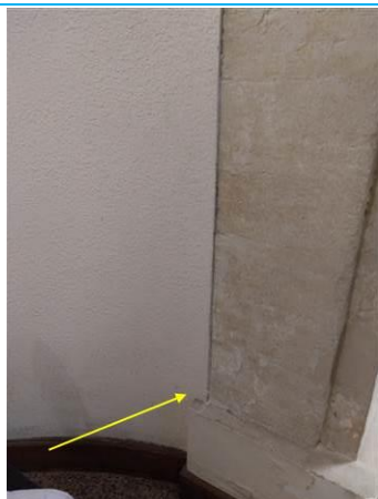
Matériaux : ZPSO-091 Prélèvement : P107 Description : Enduit à base de plâtre projeté Localisation : Entresol 0-1 - Couloir 1 Résultat : Absence d'amiante
