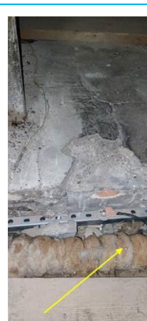
Matériaux : ZPSO-004 Prélèvement : P006 Description : Sol embrasure passages : Calorifuge Localisation : COMBLES - Combles 7 Résultat : Absence d'amiante
