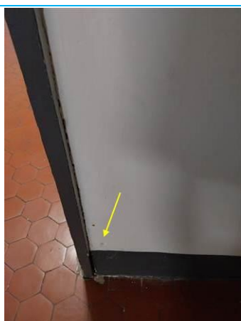
Matériaux : ZPSO-058 Prélèvement : P073 Description : Cloisons (dures): Enduits à base de plâtre + toile de verre +colle Localisation : 1er étage - Dgt 3 Résultat : Absence d'amiante
