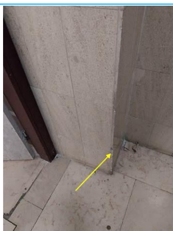
Matériaux : ZPSO-070 Prélèvement : P086 Description : Embrasure: Colle grise de faïence(marbre) Localisation : Rez de chaussée - Dgt a Résultat : Absence d'amiante
