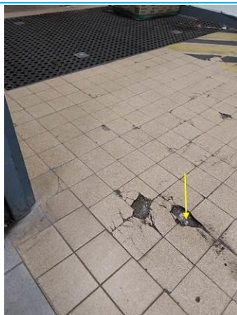
Matériaux : ZPSO-068 Prélèvement : P084 Description : Sol (Granito): Chape - Mortier colle Localisation : Rez de chaussée - Entrée Résultat : Absence d'amiante
