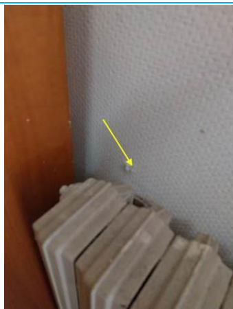
Matériaux : ZPSO-042 Prélèvement : P055 Description : Murs maîtres: Enduits à base de plâtre + peinture Localisation : 1er étage - Escalier Rostand Résultat : Absence d'amiante
