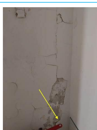
Matériaux : ZPSO-059 Prélèvement : P074 Description : Murs maîtres: Enduits à base de plâtre + peinture Localisation : 1er étage - Dgt 3 Résultat : Absence d'amiante
