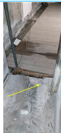
Matériaux : ZPSO-003 Prélèvement : P004 Description : Sol embrasure : Ragréage ciment + chape plâtre Localisation : COMBLES - Pavillon 4 Résultat : Absence d'amiante
