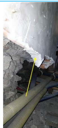
Matériaux : ZPSO-002 Prélèvement : P002 Description : Embrasures passages: Enduit plâtre Localisation : COMBLES - Pavillon 3 Résultat : Absence d'amiante
