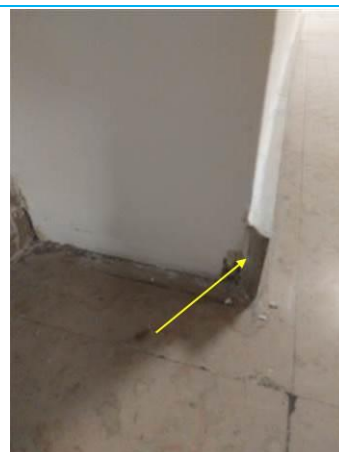
Matériaux : ZPSO-064 Prélèvement : P080 Description : Plinthes: Colle de carrelage Localisation : Entresol 0-1 - Couloir 2 Résultat : Absence d'amiante
