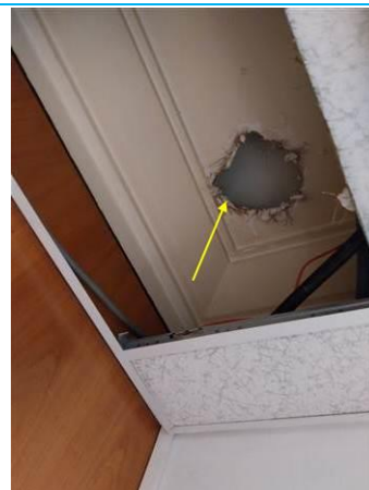
Matériaux : ZPSO-043 Prélèvement : P056 Description : Plafond: Enduit à base de plâtre Localisation : 1er étage - Escalier Rostand Résultat : Absence d'amiante
