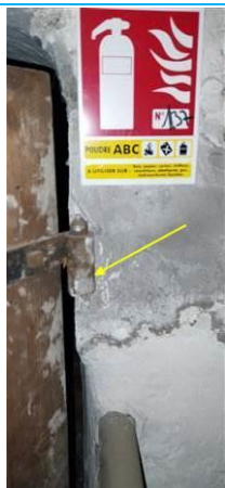
Matériaux : ZPSO-001 Prélèvement : P001 Description : Gonds: Scelllements ciment Localisation : COMBLES - Pavillon 3 Résultat : Absence d'amiante
