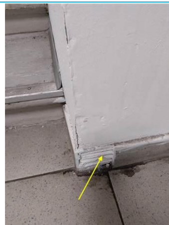
Matériaux : ZPSO-067 Prélèvement : P083 Description : Plinthes: Colle de carrelage Localisation : Rez de chaussée - Escalier 1 Résultat : Absence d'amiante
