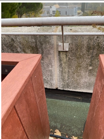
Prélèvement - 0503 : R+3 / Terrasse - Enduit- (Absence d'amiante)
