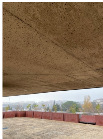
Prélèvement - 0500 : R+3 / Terrasse - Faux plafond- (Absence d'amiante)
