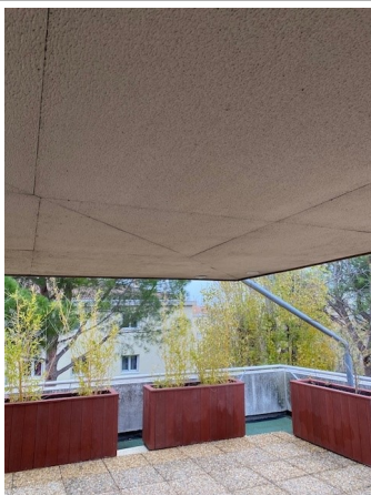
Prélèvement - 0499 : R+3 / Terrasse - Faux plafond- (Absence d'amiante)
