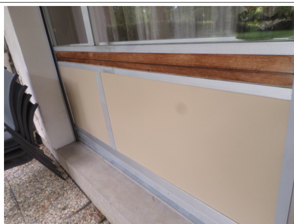
Déclaré - IV1 : RDC / Chambre 1 - Panneau - EP- (Présence d'amiante)
