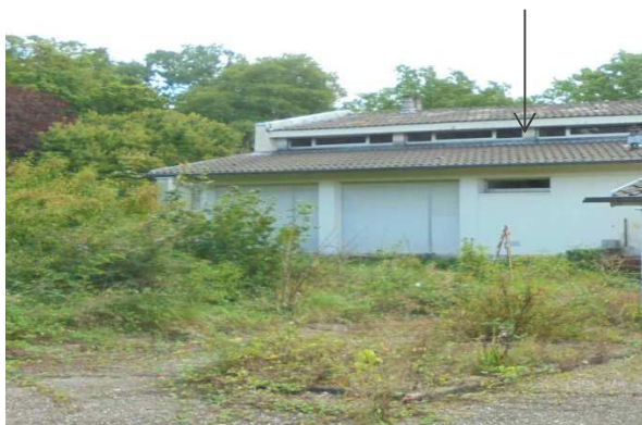
SD : R+1 / Facade Avant-Panneau fibrociment-Gris-EP- (Présence d'amiante)
