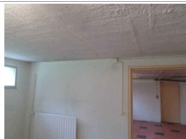
Prélèvement - P4 : SOUS-SOL / Pièce 3 - Enduit projeté- (Absence d'amiante)
