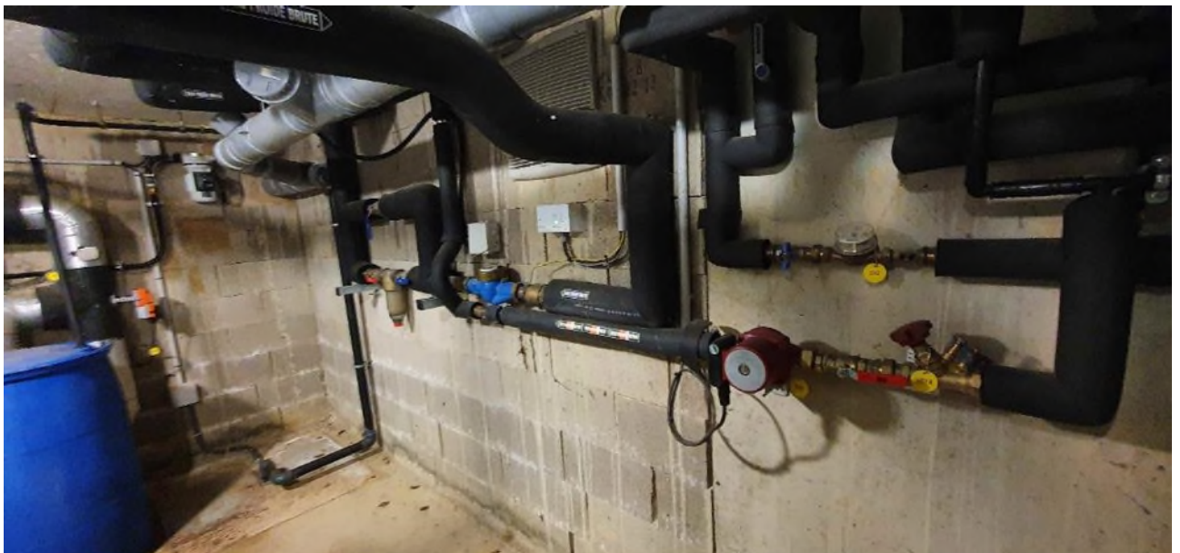
Circuit Plancher chauffant 1 échangeur 1 pompe double 1 vanne 3 voies motorisée
