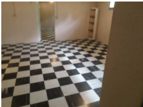
Prélèvement - P1 : Sous-Sol / Pièce 1-Dalle de Sol Gris - EP- (Présence d'amiante)
