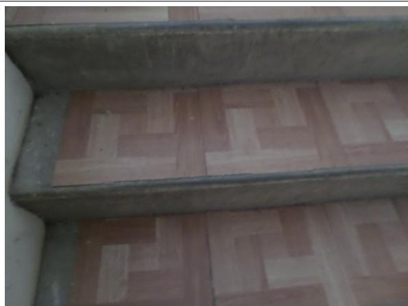
Prélèvement - P1 : SOUS-SOL / Escalier-Dégagement - Dalle de sol- (Absence d'amiante)
