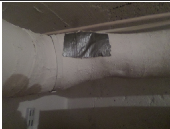
Prélèvement - P7 : SOUS-SOL / Pièce 3 - Enveloppe de calorifugeage- (Absence d'amiante)
