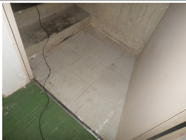
Prélèvement - P1 : SOUS-SOL / Dégagement - Dalle de sol - EP- (Présence d'amiante)
