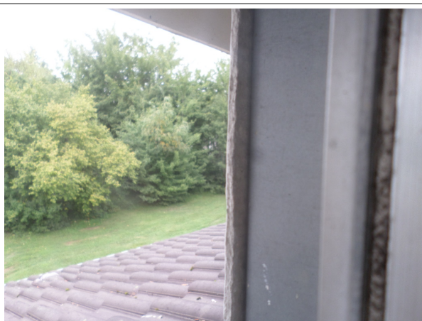
Prélèvement - P9 : R+1 / Facade / Entourage des fenêtres - Panneau - EP- (Présence d'amiante)
