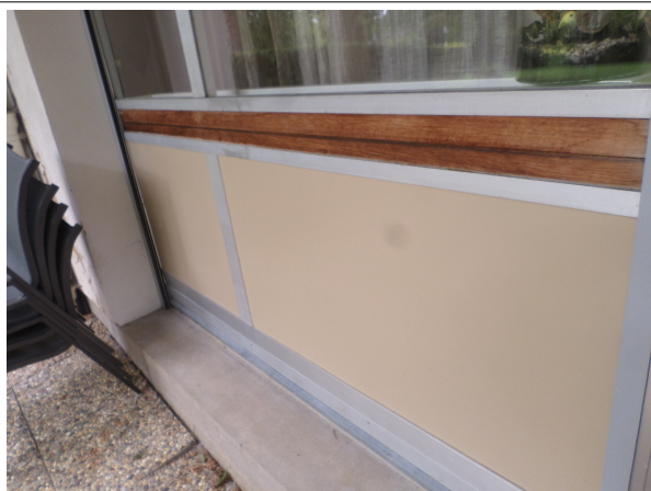
SD - IV1 : RDC / Chambre 2 - Panneau - EP- (Présence d'amiante)
