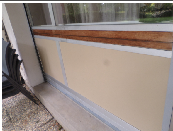
SD - IV1 : RDC / SDB 1 - Panneau - EP- (Présence d'amiante)
