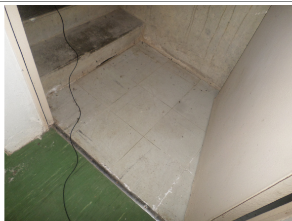
SP - P1 : SOUS-SOL / Pièce6 - Dalle de sol - EP- (Présence d'amiante)
