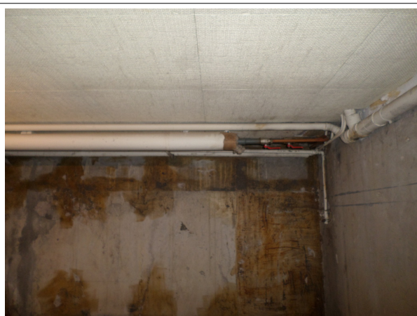
Prélèvement - P3 : SOUS-SOL / Pièce1 - Enveloppe de calorifuge- (Absence d'amiante)
