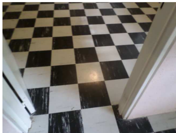
Prélèvement - P4 : SOUS-SOL / Pièce 1-Dalle de Sol Noir-EP- (Présence d'amiante)
