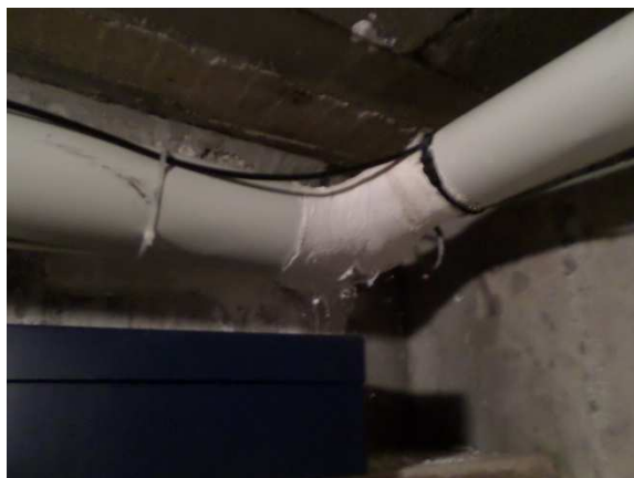
Prélèvement - P3 : Sous-Sol / Pièce 4- Calorifugeage- (Absence d'amiante)
