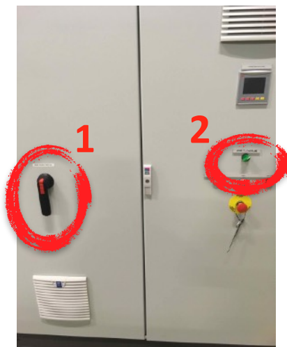
Armoire gradateur, mise en marche
