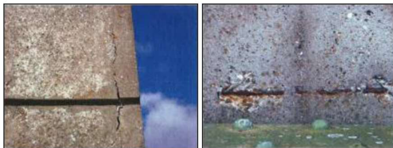
Figure 4 : des épaufrures du génie civil
