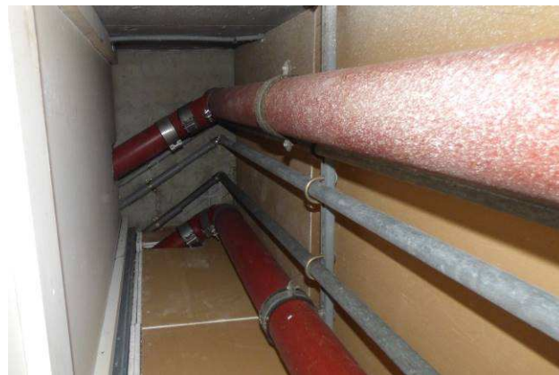
Photo 12 : Gaine technique du RDC, dévoiement vers gaine technique des étages
