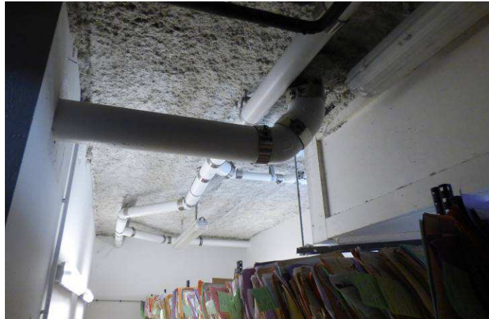
Photo 11 : Réseau d'évacuation au RDJ vers les appareils sanitaires du RDC Consultation, réseaux en bon état conservés
