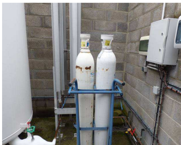
Photo 37 : Bouteilles secours oxygène
