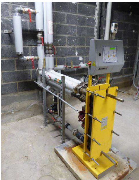
Photo 4 : échangeur à plaques
