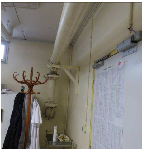
Photo 1 : pénétration de l'alimentation EF dans le local pharmacie
