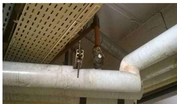
Photo 8 : Piquage pour alimentation d'un équipement de cuisine en PVC Pression
