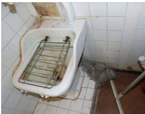
Photo 33 : Poste d'eau à remplacer sur 3 niveaux
