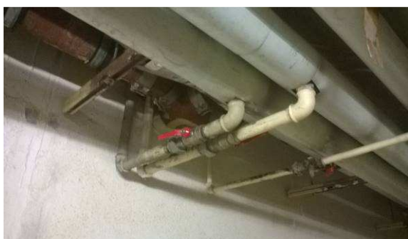
Photo 7 : Piquage pour alimentation EF, ECS et bouclage en gaine technique
