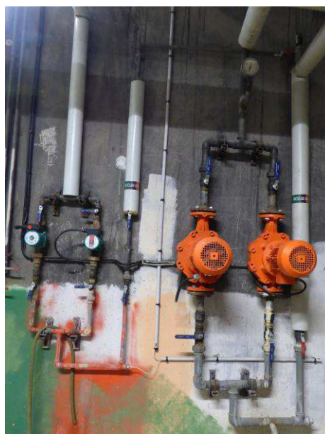
Photo 5 : pompes de bouclage ECS
