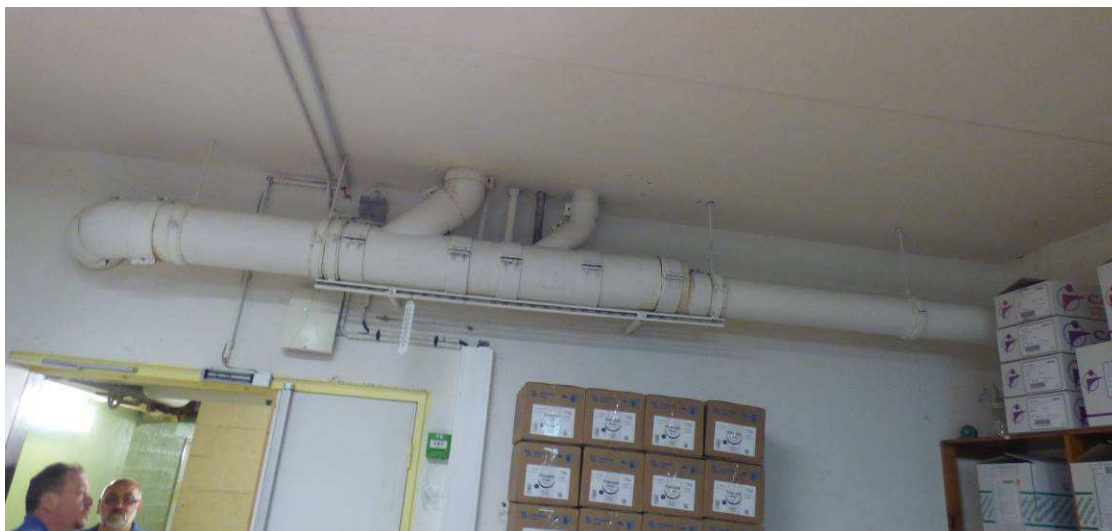
Photo 9 : Réseau d'évacuation au RDJ, piquages vers gaine technique
