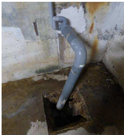
Photo 35 : Puisard à air libre en LT production ECS
