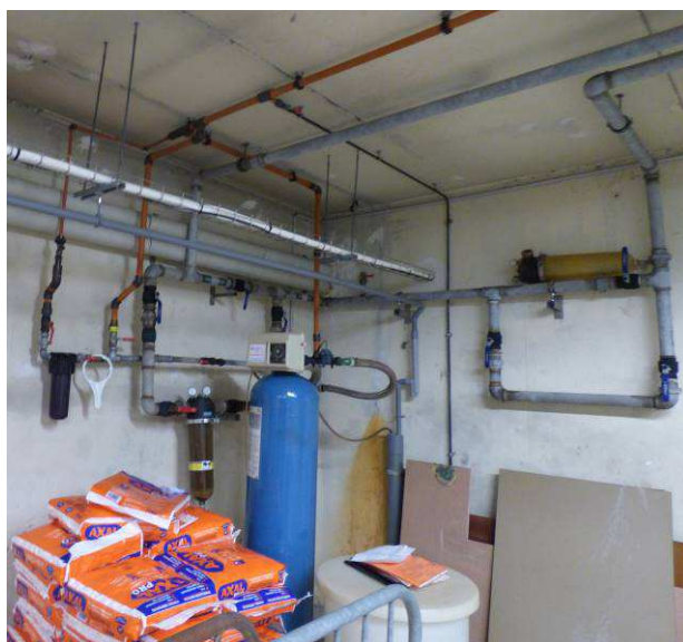
Photo 3 : poste adoucisseur en local technique
