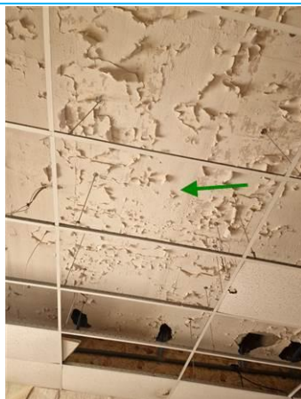
Matériaux : ZPSO-111 Prélèvement : P202 Description : Enduit de plafond lisse Localisation : RDC - BAR 1 Résultat : Absence d'amiante
