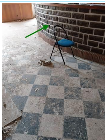
Matériaux : ZPSO-064 Prélèvement : P129 Description : Enduit sur comptoir Localisation : RDC - BAR 1 Résultat : Absence d'amiante
