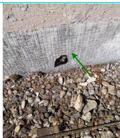
Matériaux : ZPSO-125 Prélèvement : P168 Description : Relevé : revêtement bitumineux Localisation : TOITURE - ENTREE 1 Résultat : Absence d'amiante
