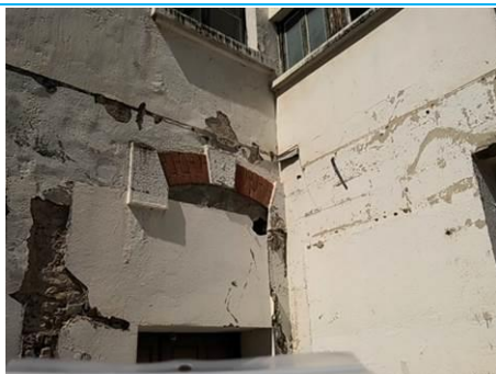
Matériaux : ZPSO-077 Prélèvement : P239 Description : Facade Droite - Grille D'aération sous vitrage - Mastic baguette Solin Localisation : Rez de chaussée - Facades Résultat : Absence d'amiante
