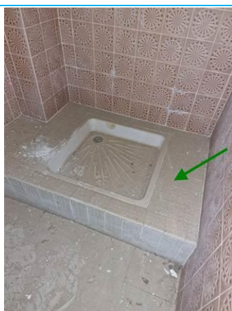
Matériaux : ZPSO-004 Prélèvement : P134 Description : Colle de carrelage beige antiderapant + rag Localisation : RDC - OFFICE Résultat : Absence d'amiante
