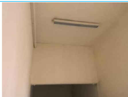
Matériaux : ZPSO-033 Prélèvement : P183 Description : crépi plafond Localisation : Rez-de-Chaussée - Dégagement 1 Résultat : Absence d'amiante
