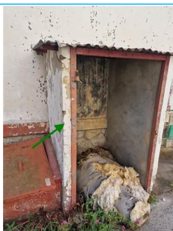
Matériaux : ZPSO-106 Prélèvement : P189 Description : Enduit extérieur Localisation : RDC - EXTERIEUR - ABRI Résultat : Absence d'amiante
