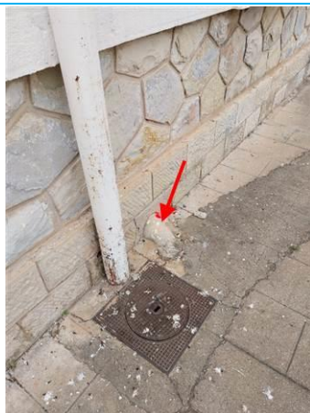
Matériaux : ZPSO-083 Prélèvement : P152 Description : Conduit en fibres-ciment Localisation : RDC - EXTERIEUR - EXTERIEUR Résultat : Présence d'amiante
