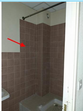
Matériaux : ZPSO-078 Prélèvement : P015 Description : Colle grise de faïence rose rosace Localisation : R+2 - SDB CH 40 Résultat : Présence d'amiante
