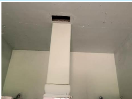
Matériaux : ZPSO-023 Prélèvement : P029 Description : Conduit en fibres-ciment rectangulaire Localisation : 4ème étage - Sanitaire hall D Résultat : Présence d'amiante
