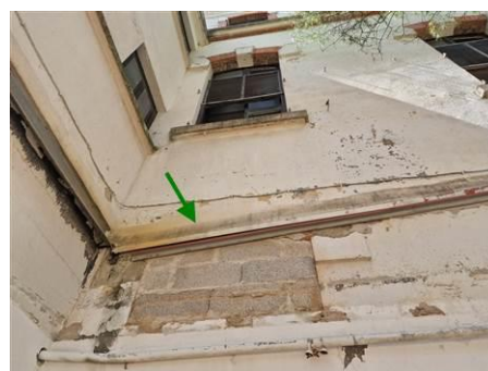
Matériaux : ZPSO-099 Prélèvement : P175 Description : Enduit extérieur sur solin Localisation : RDC - ENTREE 2 Résultat : Absence d'amiante
