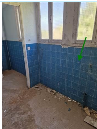
Matériaux : ZPSO-021 Prélèvement : P040 Description : Colle beige de faïence bleu Localisation : R+2 - SANITAIRES 4 Résultat : Présence d'amiante
