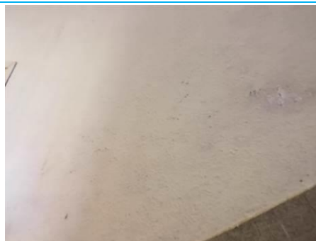
Matériaux : ZPSO-027 Prélèvement : P168 Description : Enduit à base de plâtre projeté gouttelettes Localisation : Rez-de-Chaussée - Escalier Central Gauche Résultat : Absence d'amiante
