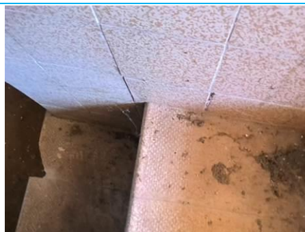
Matériaux : ZPSO-049 Prélèvement : P139 Description : Nez de marche moucheté beige Localisation : 1er étage - Sanitaire Palier G Résultat : Absence d'amiante
