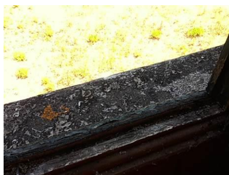
Matériaux : ZPSO-043 Prélèvement : P145 Description : Appui de fenêtre avec enduit gris Localisation : 1er étage - Sanitaire Palier G Résultat : Absence d'amiante
