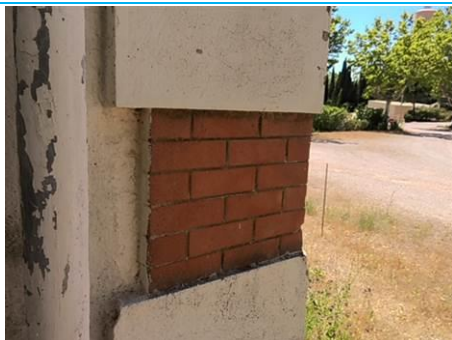
Matériaux : ZPSO-013 Prélèvement : P206 Description : Colle d'assemblage brique rouge Localisation : Rez-de-Chaussée - Pièce 18 + Placard Résultat : Absence d'amiante
