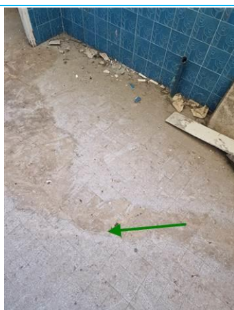
Matériaux : ZPSO-019 Prélèvement : P036 Description : Colle de carrelage gris moucheté Localisation : R+2 - SANITAIRES 4 Résultat : Absence d'amiante
