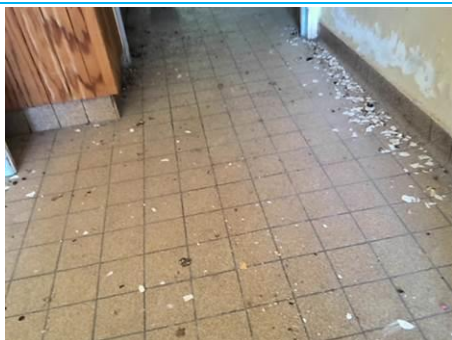
Matériaux : ZPSO-001 Prélèvement : P093 Description : Colle de carrelage Petit carreaux mouchetés Beige + Ragréage Localisation : 2ème étage - Pièce 1 + Placards Résultat : Absence d'amiante
