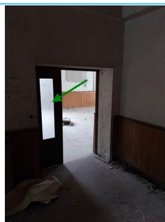
Matériaux : ZPSO-069 Prélèvement : P135 Description : Mastic de vitrage Localisation : RDC - SALLE 1 Résultat : Absence d'amiante
