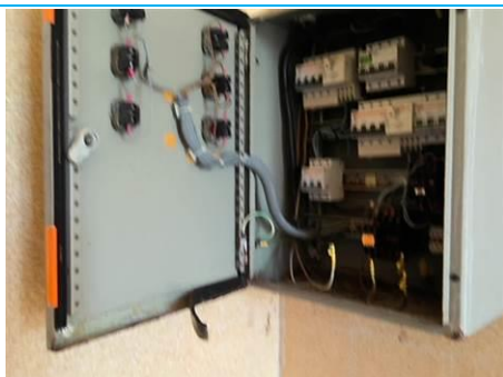
Matériaux : ZPSO-057 Prélèvement : P175 Description : joint noir dans placard électrique Localisation : Rez-de-Chaussée - Pièce 4 Résultat : Absence d'amiante
