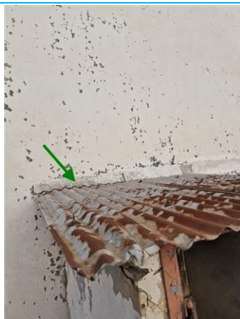
Matériaux : ZPSO-108 Prélèvement : P193 Description : Enduit extérieur Localisation : RDC - EXTERIEUR - FACADES Résultat : Absence d'amiante
