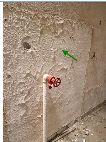
Matériaux : ZPSO-010 Prélèvement : P017 Description : Enduit mural ciment goutelé Localisation : R+2 - DEGAGEMENT 1 Résultat : Absence d'amiante
