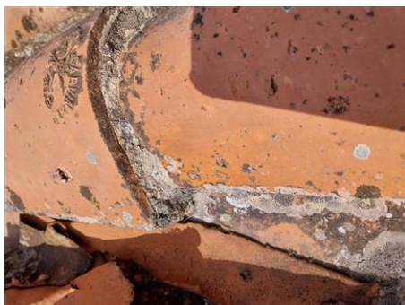
Matériaux : ZPSO-070 Prélèvement : P227 Description : mortier d'accrochage sous tuiles Localisation : 6ème étage - Toiture Résultat : Absence d'amiante
