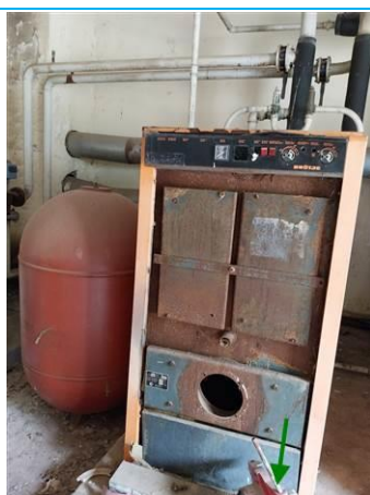
Matériaux : ZPSO-093 Prélèvement : P167 Description : Joint de brûleur Localisation : RDC - CHAUFFERIE Résultat : Absence d'amiante
