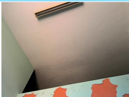
Matériaux : ZPSO-045 Prélèvement : P117 Description : Enduit à base de plâtre projeté blanc Localisation : 2ème étage - Pièce 13 Résultat : Absence d'amiante
