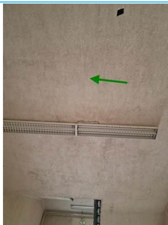
Matériaux : ZPSO-074 Prélèvement : P143 Description : Enduit de plafond Localisation : RDC - HALL 1 Résultat : Absence d'amiante
