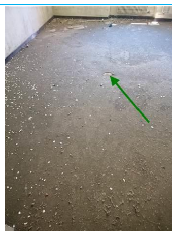
Matériaux : ZPSO-005 Prélèvement : P007 Description : Moquette + colle Localisation : R+2 - CH 40 Résultat : Absence d'amiante
