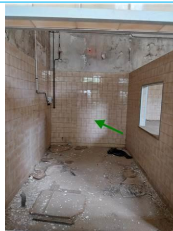
Matériaux : ZPSO-067 Prélèvement : P132 Description : Colle de faïence marron Localisation : RDC - OFFICE Résultat : Absence d'amiante
