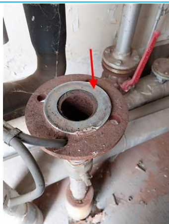
Matériaux : ZPSO-092 Prélèvement : P163 Description : Joints de brides Localisation : RDC - CHAUFFERIE Résultat : Présence d'amiante
