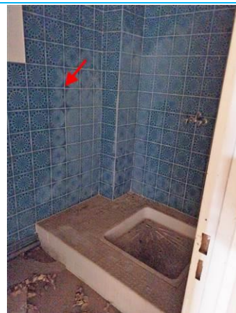
Matériaux : ZPSO-047 Prélèvement : P107 Description : Enduit mural ciment avec platre Localisation : R+1 - SDB CH 19 Résultat : Présence d'amiante
