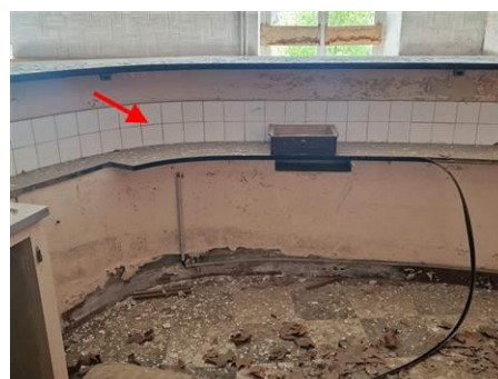
Matériaux : ZPSO-061 Prélèvement : P125 Description : Colle de faïence blanche Localisation : RDC - BAR 1 Résultat : Présence d'amiante
