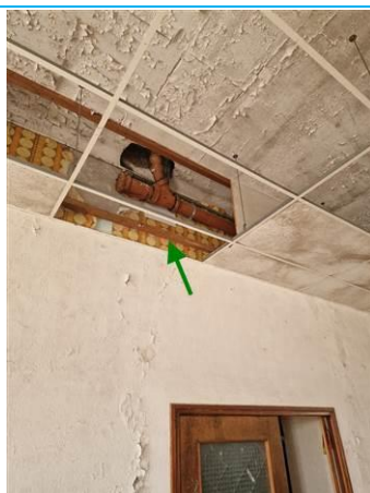
Matériaux : ZPSO-115 Prélèvement : P210 Description : tapisserie + colle Localisation : RDC - SALLE 2 Résultat : Absence d'amiante
