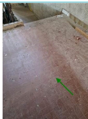
Matériaux : ZPSO-013 Prélèvement : P023 Description : Colle de carrelage rouge rectangulaire Localisation : R+2 - HALL 5 Résultat : Absence d'amiante
