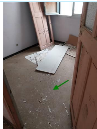
Matériaux : ZPSO-005 Prélèvement : P096 Description : Moquette + colle Localisation : R+1 - CH 02 Résultat : Absence d'amiante
