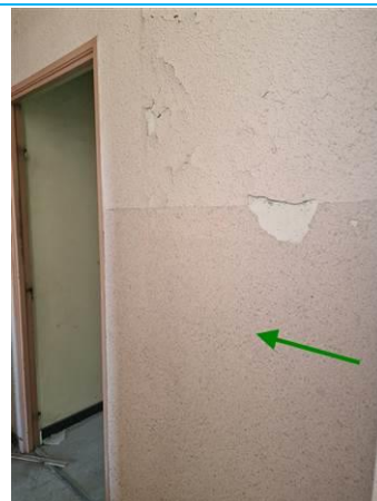
Matériaux : ZPSO-018 Prélèvement : P034 Description : Enduit mural crépis Localisation : R+2 - DEGAGEMENT 2 Résultat : Absence d'amiante
