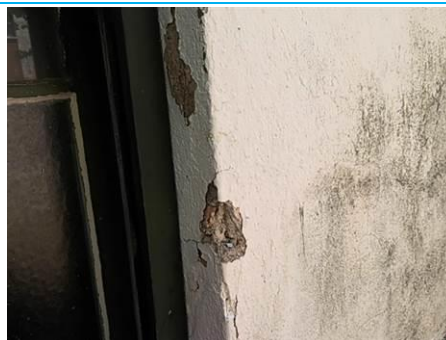
Matériaux : ZPSO-012 Prélèvement : P205 Description : Colle d'assemblage entre pierre de facade Localisation : Rez de chaussée - Facades Résultat : Absence d'amiante
