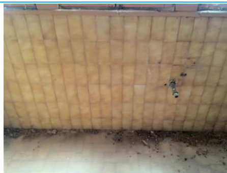
Matériaux : ZPSO-030 Prélèvement : P080 Description : Colle de faïence rectangulaire marron chevron Localisation : 3ème étage - Sanitaire Palier G Résultat : Absence d'amiante
