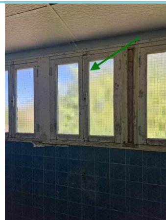
Matériaux : ZPSO-022 Prélèvement : P042 Description : Mastic de vitrage Localisation : R+2 - SANITAIRES 4 Résultat : Absence d'amiante
