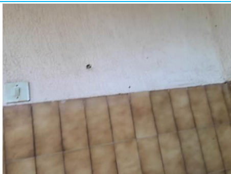
Matériaux : ZPSO-035 Prélèvement : P081 Description : Enduit à base de plâtre projeté crepi Localisation : 3ème étage - Sanitaire Palier G Résultat : Absence d'amiante
