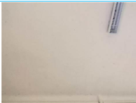
Matériaux : ZPSO-038 Prélèvement : P134 Description : Enduit à base de plâtre lissé Localisation : 2ème étage - Hall D Résultat : Absence d'amiante
