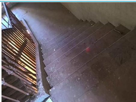
Matériaux : ZPSO-019 Prélèvement : P091 Description : Nez de marche carrelage rouge Localisation : 2ème étage - Escalier central G Résultat : Absence d'amiante
