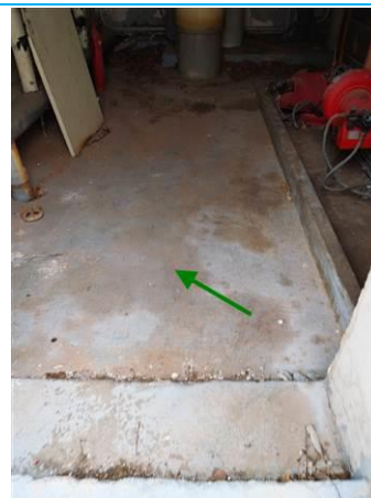
Matériaux : ZPSO-084 Prélèvement : P153 Description : Ragrage peint Localisation : RDC - CHAUFFERIE Résultat : Absence d'amiante
