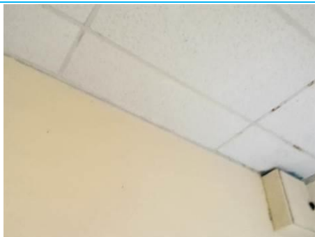
Matériaux : ZPSO-046 Prélèvement : P119 Description : dalle de faux plafond Localisation : 2ème étage - Dégagement central Résultat : Absence d'amiante
