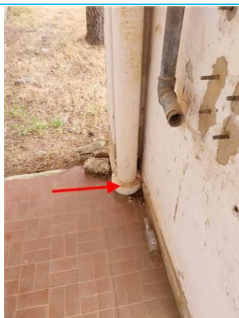
Matériaux : ZPSO-094 Prélèvement : Description : Conduit en fibres-ciment Localisation : RDC - ENTREE 2 Résultat : Présence d'amiante
