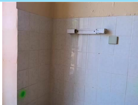
Matériaux : ZPSO-047 Prélèvement : P120 Description : Colle de faïence blanche effet marbre Localisation : 2ème étage - Pièce 18 Résultat : Absence d'amiante
