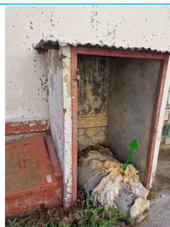
Matériaux : ZPSO-107 Prélèvement : P191 Description : Enduit mural ciment Localisation : RDC - EXTERIEUR - ABRI Résultat : Absence d'amiante
