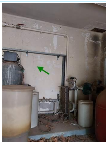
Matériaux : ZPSO-085 Prélèvement : P155 Description : Enduit mural lisse Localisation : RDC - CHAUFFERIE Résultat : Absence d'amiante
