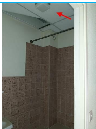
Matériaux : ZPSO-024 Prélèvement : P054 Description : Faux plafonds relief Localisation : R+2 - SANITAIRES 3 Résultat : Présence d'amiante
