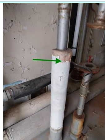
Matériaux : ZPSO-087 Prélèvement : P158 Description : Calorifugeage beige + enveloppe + carton bitumineux - laine jaune Localisation : RDC - CHAUFFERIE Résultat : Absence d'amiante
