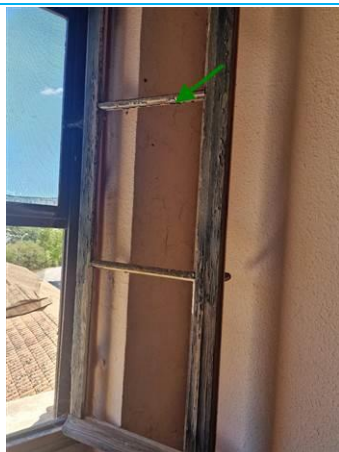
Matériaux : ZPSO-002 Prélèvement : P002 Description : Mastic de vitrage rustine Localisation : R+2 - DEGAGEMENT 1 Résultat : Absence d'amiante
