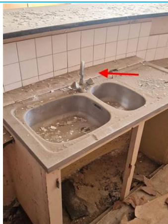
Matériaux : ZPSO-118 Prélèvement : P215 Description : Colle grise de carrelage - pailleasse Localisation : RDC - BAR 1 Résultat : Présence d'amiante
