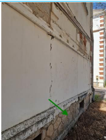
Matériaux : ZPSO-096 Prélèvement : P169 Description : Enduit extérieur sur pierre Localisation : RDC - EXTERIEUR - FACADES Résultat : Absence d'amiante
