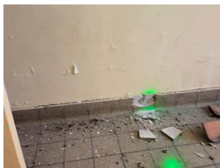
Matériaux : ZPSO-003 Prélèvement : P094 Description : Colle de plinthes petit carreaux moucheté beige Localisation : 2ème étage - Pièce 1 + Placards Résultat : Absence d'amiante
