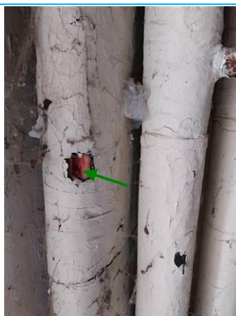
Matériaux : ZPSO-088 Prélèvement : P159 Description : Calorifugeage beige + enveloppe + carton bitumineux - laine rose Localisation : RDC - CHAUFFERIE Résultat : Absence d'amiante
