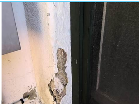
Matériaux : ZPSO-014 Prélèvement : P221 Description : Enduit extérieur lisse gris Localisation : Rez de chaussée - Facades Résultat : Absence d'amiante
