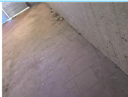
Matériaux : ZPSO-016 Prélèvement : P172 Description : Colle de carrelage rouge rectangle avec ragréage Localisation : Rez-de-Chaussée - Hall RDC Gauche Résultat : Absence d'amiante
