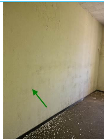
Matériaux : ZPSO-007 Prélèvement : P011 Description : Enduit mural crépis Localisation : R+2 - CH 40 Résultat : Absence d'amiante
