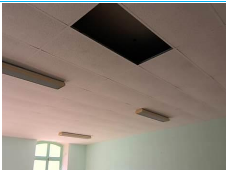
Matériaux : ZPSO-053 Prélèvement : P177 Description : dalle de faux plafond Localisation : Rez-de-Chaussée - Pièce 5 Résultat : Absence d'amiante
