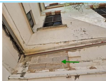
Matériaux : ZPSO-101 Prélèvement : P179 Description : Enduit extérieur - mortier Localisation : RDC - EXTERIEUR - FACADES Résultat : Absence d'amiante
