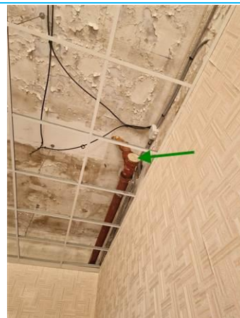
Matériaux : ZPSO-112 Prélèvement : P206 Description : Enduit de bouchage sur conduit métal rouge Localisation : RDC - BAR 1 Résultat : Absence d'amiante
