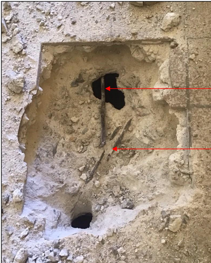
Photographie des armatures acier reconnues en surface de la poutre (partie supérieure)
