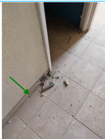
Matériaux : ZPSO-043 Prélèvement : P102 Description : Colle de plinthe beige Localisation : R+1 - ENTREE CH 17 Résultat : Absence d'amiante
