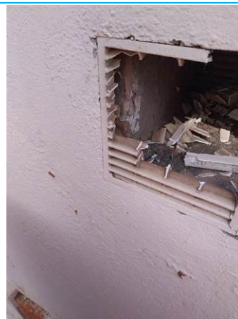
Matériaux : ZPSO-072 Prélèvement : P230 Description : Facade Gauche - Grille D'aération sous vitrage - Conduit fibres ciment rectangulaire Localisation : 2ème étage - Facades Résultat : Présence d'amiante
