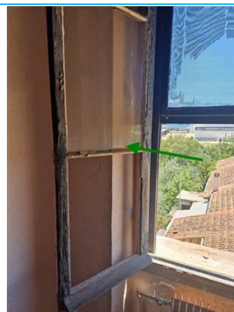
Matériaux : ZPSO-001 Prélèvement : P001 Description : Mastic de vitrage ancien Localisation : R+2 - DEGAGEMENT 1 Résultat : Absence d'amiante
