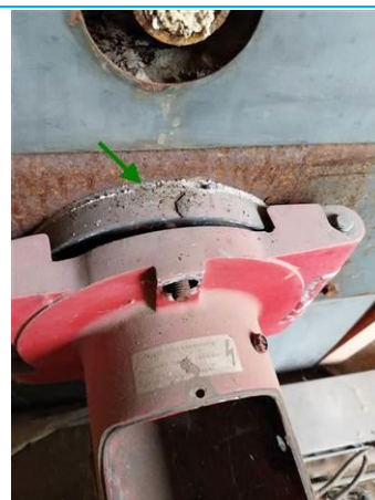
Matériaux : ZPSO-090 Prélèvement : P161 Description : Joint de brûleur Localisation : RDC - CHAUFFERIE Résultat : Absence d'amiante
