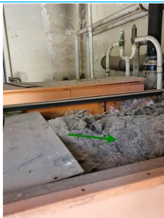
Matériaux : ZPSO-122 Prélèvement : P224 Description : Isolant fibreux Localisation : RDC - CHAUFFERIE Résultat : Absence d'amiante
