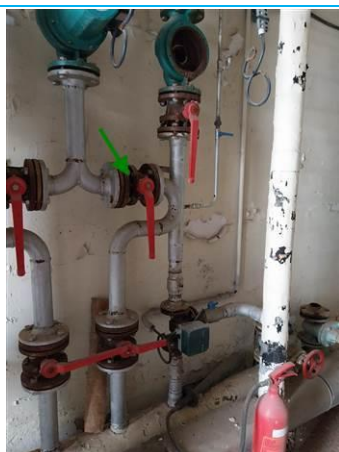
Matériaux : ZPSO-089 Prélèvement : P160 Description : fillasse sur conduit Localisation : RDC - CHAUFFERIE Résultat : Absence d'amiante
