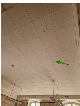
Matériaux : ZPSO-113 Prélèvement : P207 Description : Faux plafonds Localisation : RDC - SALLE 1 Résultat : Absence d'amiante
