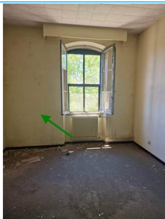
Matériaux : ZPSO-006 Prélèvement : P009 Description : Enduit mural crépis en façade Localisation : R+2 - CH 40 Résultat : Absence d'amiante
