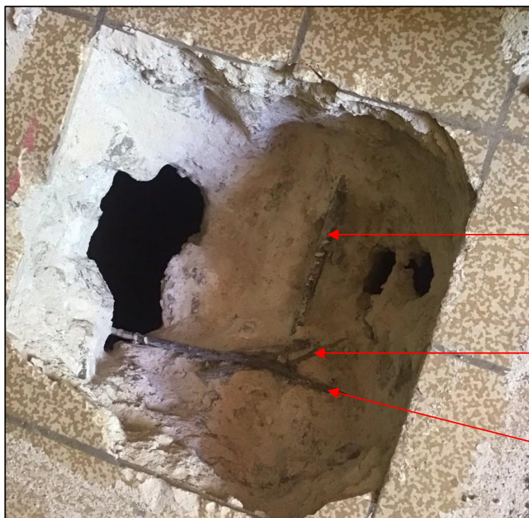
Photographie des armatures acier reconnues en surface de la poutre (partie supérieure)
