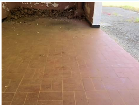
Matériaux : ZPSO-016 Prélèvement : P199 Description : Colle de carrelage rouge rectangle avec ragréage Localisation : Rez-de-Chaussée - Porche d'entrée Droit Résultat : Absence d'amiante
