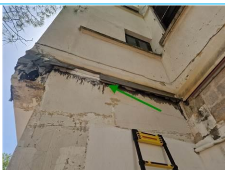
Matériaux : ZPSO-100 Prélèvement : P177 Description : colle bitumineuse Localisation : RDC - ENTREE 2 Résultat : Absence d'amiante
