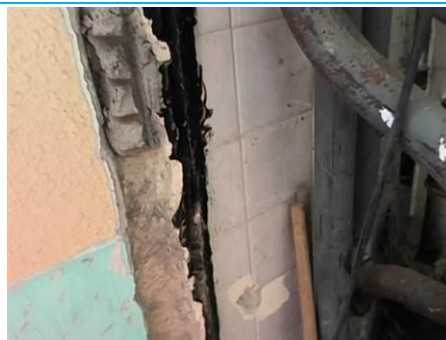
Matériaux : ZPSO-060 Prélèvement : P181 Description : Colle de faïence grise carrée Localisation : Rez-de-Chaussée - Pièce 1 Résultat : Absence d'amiante
