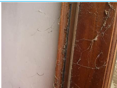
Matériaux : ZPSO-069 Prélèvement : P225 Description : Joint d'étanchéité noir porte battante bois Localisation : Rez-de-Chaussée - Pièce 5 Résultat : Absence d'amiante
