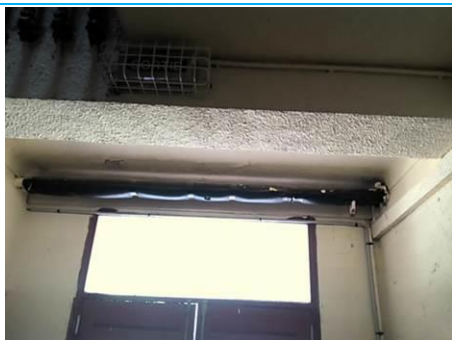
Matériaux : ZPSO-056 Prélèvement : P171 Description : Calorifuge mousse noire Localisation : Rez-de-Chaussée - Hall RDC Gauche Résultat : Absence d'amiante
