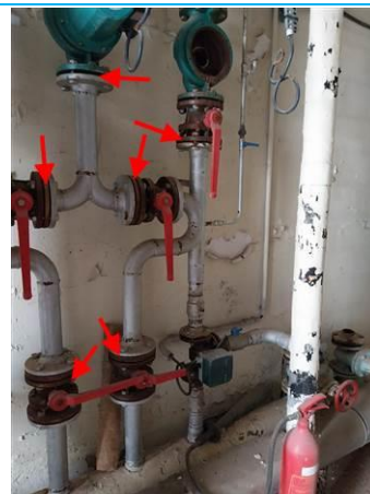
Matériaux : ZPSO-092 Prélèvement : P164 Description : Joints de brides Localisation : RDC - CHAUFFERIE Résultat : Présence d'amiante
