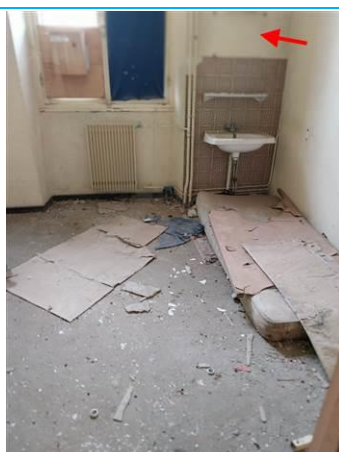
Matériaux : ZPSO-050 Prélèvement : P110 Description : Enduit mural ancien Localisation : R+1 - CH 24 Résultat : Absence d'amiante
