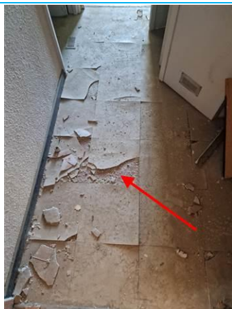
Matériaux : ZPSO-027 Prélèvement : P049 Description : Dalle de sol + colle Localisation : R+2 - ENTREE CH 25 Résultat : Présence d'amiante
