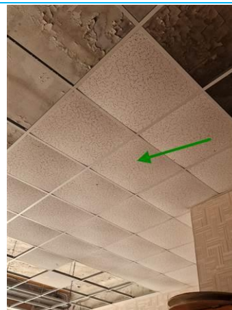
Matériaux : ZPSO-075 Prélèvement : P144 Description : Faux plafonds crevasse Localisation : R+2 - CH 41 Résultat : Absence d'amiante
