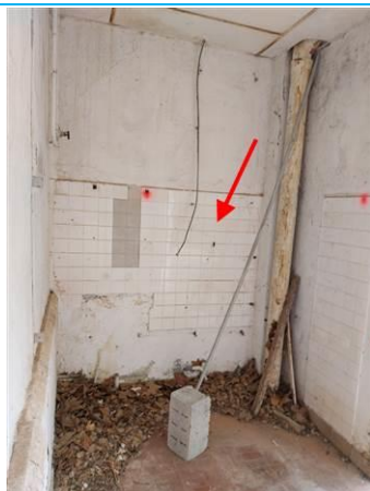
Matériaux : ZPSO-080 Prélèvement : P149 Description : Colle de faïence blanche Localisation : RDC - ENTREE 1 Résultat : Présence d'amiante
