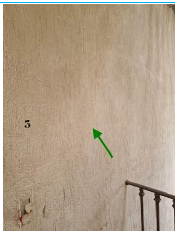
Matériaux : ZPSO-017 Prélèvement : P031 Description : Enduit mural crépis lissé Localisation : R+2 - HALL 5 Résultat : Absence d'amiante
