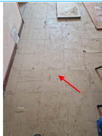
Matériaux : ZPSO-003 Prélèvement : P003 Description : Dalle de sol gris + colle jaune non séparables Localisation : R+2 - DEGAGEMENT 1 Résultat : Présence d'amiante
