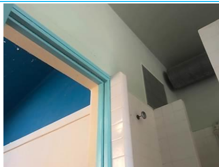
Matériaux : ZPSO-004 Prélèvement : P032 Description : Enduit à base de ciment lissé avec peinture bleue Localisation : 4ème étage - Sanitaire Hall D Résultat : Absence d'amiante
