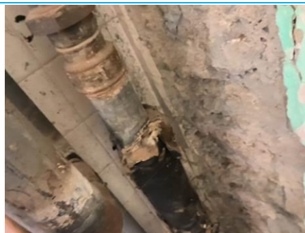
Matériaux : ZPSO-058 Prélèvement : P179 Description : Calorifuge avec isolation et carton Localisation : Rez-de-Chaussée - Pièce 1 Résultat : Absence d'amiante
