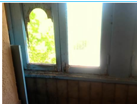
Matériaux : ZPSO-028 Prélèvement : P065 Description : Joint de mastic de vitrage fenêtre bois rectangulaire Localisation : 4ème étage - Sanitaire Palier G Résultat : Absence d'amiante
