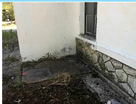
Matériaux : ZPSO-065 Prélèvement : P200 Description : Ragréage Localisation : Parties extérieures Résultat : Absence d'amiante
