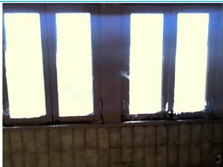
Matériaux : ZPSO-028 Prélèvement : P083 Description : Joint de mastic de vitrage fenêtre bois rectangulaire Localisation : 3ème étage - Sanitaire Palier G Résultat : Absence d'amiante
