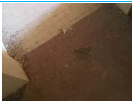
Matériaux : ZPSO-016 Prélèvement : P137 Description : Colle de carrelage rouge rectangle avec ragréage Localisation : 2ème étage - Hall D Résultat : Absence d'amiante
