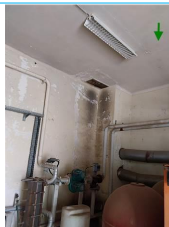
Matériaux : ZPSO-086 Prélèvement : P157 Description : Enduit de plafond Localisation : RDC - CHAUFFERIE Résultat : Absence d'amiante
