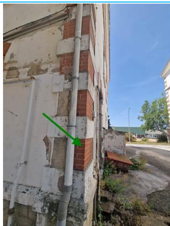
Matériaux : ZPSO-104 Prélèvement : P185 Description : Enduit extérieur sur briques rouge Localisation : RDC - EXTERIEUR - FACADES Résultat : Absence d'amiante
