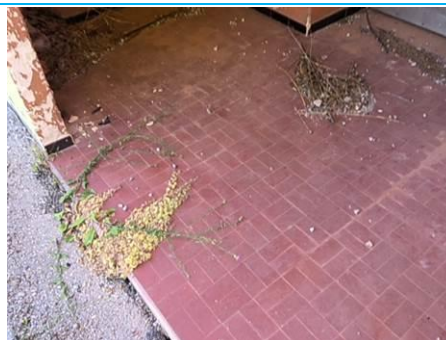
Matériaux : ZPSO-016 Prélèvement : P204 Description : Colle de carrelage rouge rectangle avec ragréage Localisation : Rez-de-Chaussée - Porche d'entrée Gauche Résultat : Absence d'amiante
