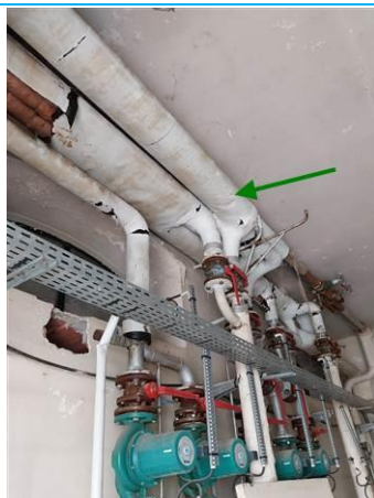
Matériaux : ZPSO-091 Prélèvement : P162 Description : Enveloppe blanche de calorifuge plâtre Localisation : RDC - CHAUFFERIE Résultat : Absence d'amiante
