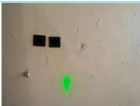
Matériaux : ZPSO-022 Prélèvement : P095 Description : Enduit à base de ciment lissé peinture jaune Localisation : 2ème étage - Pièce 1 + Placards Résultat : Absence d'amiante
