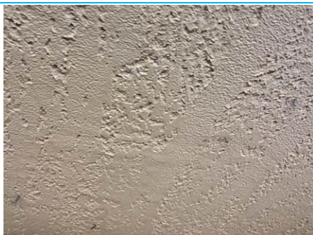
Matériaux : ZPSO-033 Prélèvement : P062 Description : crépi plafond Localisation : 4ème étage - Sanitaire Palier G Résultat : Absence d'amiante
