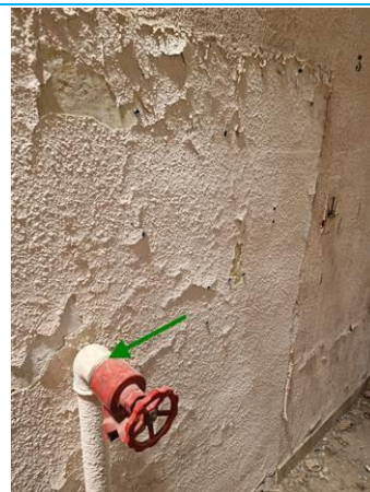
Matériaux : ZPSO-016 Prélèvement : P029 Description : fillasse Localisation : R+2 - HALL 5 Résultat : Absence d'amiante
