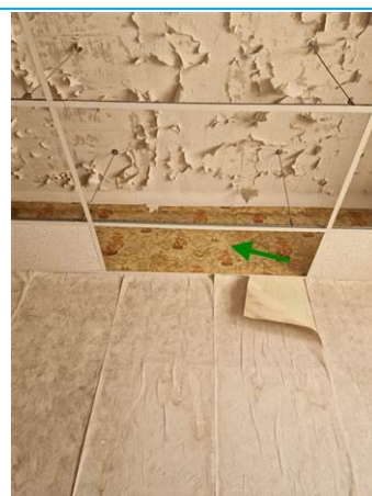
Matériaux : ZPSO-114 Prélèvement : P208 Description : tapisserie + colle Localisation : RDC - LOCAL 1 Résultat : Absence d'amiante
