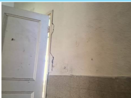
Matériaux : ZPSO-026 Prélèvement : P167 Description : Enduit à base de ciment lissé gris derrière plâtre Localisation : Rez-de-Chaussée - Escalier Central Gauche Résultat : Absence d'amiante
