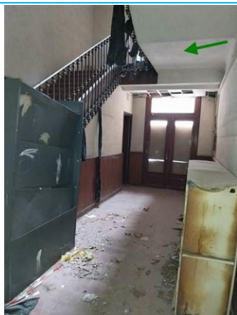
Matériaux : ZPSO-102 Prélèvement : P180 Description : Enduit de plafond - ciment lissé Localisation : RDC - ENTREE 2 Résultat : Absence d'amiante
