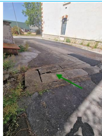
Matériaux : ZPSO-105 Prélèvement : P187 Description : Ragréege Localisation : RDC - EXTERIEUR - EXTERIEUR Résultat : Absence d'amiante
