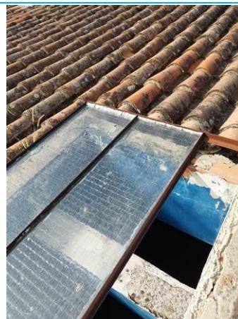
Matériaux : ZPSO-071 Prélèvement : P228 Description : Mastic vitrage velux gauche Localisation : 6ème étage - Toiture Résultat : Absence d'amiante
