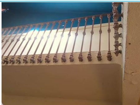
Matériaux : ZPSO-040 Prélèvement : P079 Description : crépi tour intérieur escalier Localisation : 4ème étage - Escalier central D Résultat : Absence d'amiante
