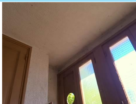
Matériaux : ZPSO-033 Prélèvement : P082 Description : crépi plafond Localisation : 3ème étage - Palier Gauche Résultat : Absence d'amiante
