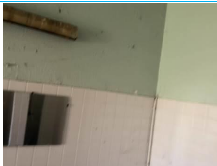
Matériaux : ZPSO-002 Prélèvement : P208 Description : Enduit à base de plâtre lissé avec peinture bleue Localisation : 4ème étage - Sanitaire hall G Résultat : Absence d'amiante
