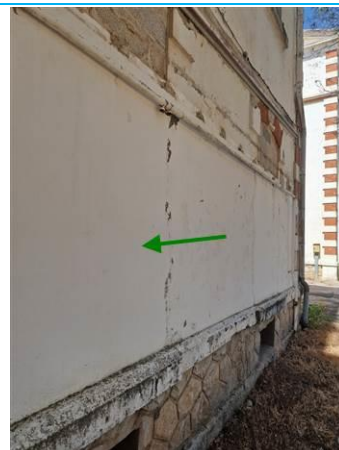
Matériaux : ZPSO-103 Prélèvement : P183 Description : Enduit extérieur blanc Localisation : RDC - EXTERIEUR - FACADES Résultat : Absence d'amiante
