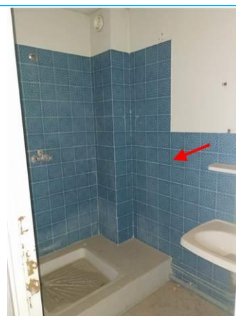
Matériaux : ZPSO-025 Prélèvement : P056 Description : Colle beige de faïence bleu rosace Localisation : R+2 - SDB CH 28 Résultat : Présence d'amiante
