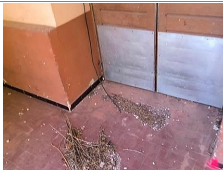
Matériaux : ZPSO-066 Prélèvement : P202 Description : Colle de plinthes rouge carrelage Localisation : Rez-de-Chaussée - Porche d'entrée Gauche Résultat : Présence d'amiante
