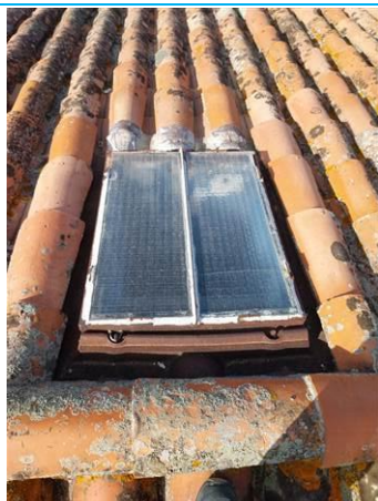
Matériaux : ZPSO-076 Prélèvement : P237 Description : Mastic vitrage petit velux Localisation : 6ème étage - Toiture Résultat : Absence d'amiante
