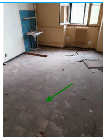
Matériaux : ZPSO-052 Prélèvement : P112 Description : Colle jaune de lino Localisation : R+1 - CH 24 Résultat : Absence d'amiante
