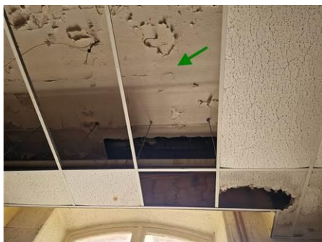
Matériaux : ZPSO-070 Prélèvement : P136 Description : Enduit de plafond crépis Localisation : RDC - BAR 2 Résultat : Absence d'amiante
