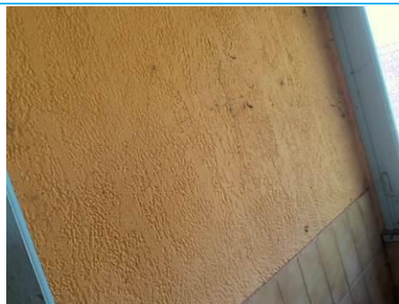
Matériaux : ZPSO-035 Prélèvement : P063 Description : Enduit à base de plâtre projeté crepi Localisation : 4ème étage - Sanitaire Palier G Résultat : Absence d'amiante
