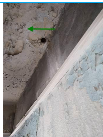
Matériaux : ZPSO-077 Prélèvement : P146 Description : Enduit de plafond Localisation : R+1 - SANITAIRES 1 Résultat : Absence d'amiante
