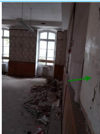
Matériaux : ZPSO-066 Prélèvement : P131 Description : Enduit mural Localisation : RDC - SALLE 1 Résultat : Absence d'amiante
