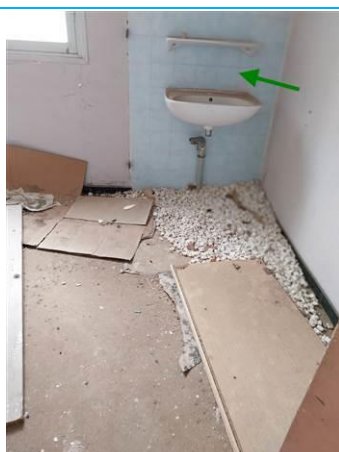
Matériaux : ZPSO-026 Prélèvement : P099 Description : Colle de faïence bleu pastel Localisation : R+1 - CH 03 Résultat : Absence d'amiante
