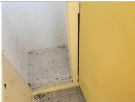
Matériaux : ZPSO-009 Prélèvement : P112 Description : Ragréage Localisation : 2ème étage - Pièce 5 + Placard Résultat : Absence d'amiante
