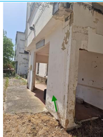
Matériaux : ZPSO-097 Prélèvement : P171 Description : Enduit extérieur Localisation : RDC - ENTREE 2 Résultat : Absence d'amiante
