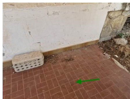
Matériaux : ZPSO-081 Prélèvement : P150 Description : Colle de carrelage rouge rectangulaire Localisation : RDC - ENTREE 2 Résultat : Absence d'amiante
