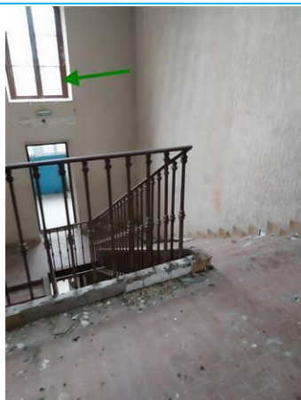
Matériaux : ZPSO-053 Prélèvement : P114 Description : Mastic de vitrage ancien Localisation : R+1 - CH 24 Résultat : Absence d'amiante
