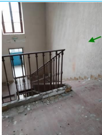
Matériaux : ZPSO-046 Prélèvement : P124 Description : Enduit mural crépis lissé Localisation : RDC - HALL 1 Résultat : Absence d'amiante
