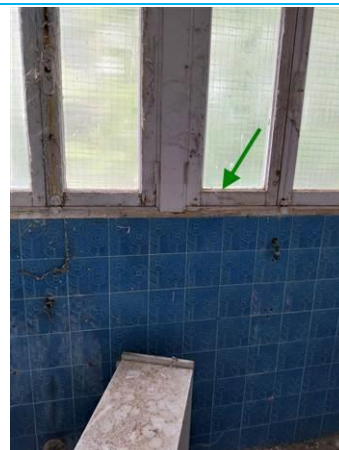
Matériaux : ZPSO-054 Prélèvement : P118 Description : Mastic de vitrage Localisation : R+1 - SANITAIRES 1 Résultat : Absence d'amiante
