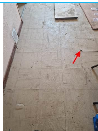
Matériaux : ZPSO-042 Prélèvement : P101 Description : colle de Dalle de sol gris blanc Localisation : R+1 - CH 11 Résultat : Présence d'amiante
