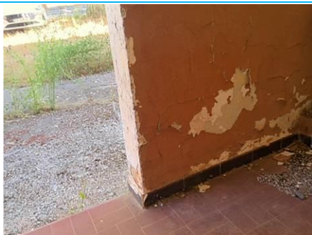
Matériaux : ZPSO-066 Prélèvement : P201 Description : Colle de plinthes rouge carrelage Localisation : Rez-de-Chaussée - Porche d'entrée Droit Résultat : Présence d'amiante
