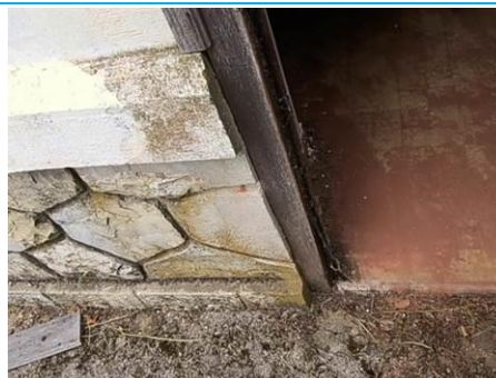
Matériaux : ZPSO-069 Prélèvement : P224 Description : Joint d'étanchéité noir porte battante bois Localisation : Rez-de-Chaussée - Pièce 5 Résultat : Absence d'amiante
