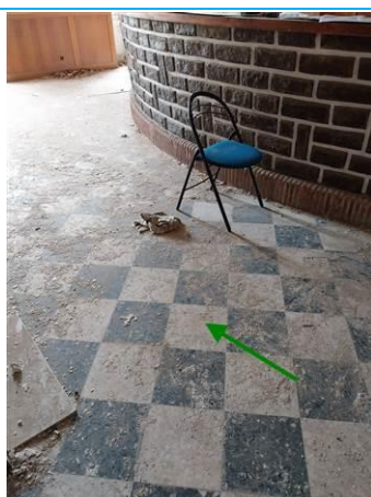
Matériaux : ZPSO-062 Prélèvement : P126 Description : Colle de carrelage blanc noir + rag Localisation : RDC - BAR 1 Résultat : Absence d'amiante
