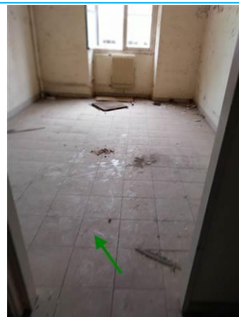
Matériaux : ZPSO-044 Prélèvement : P103 Description : Colle de carrelage grand crx beige Localisation : R+1 - CH 17 Résultat : Absence d'amiante
