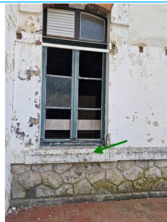
Matériaux : ZPSO-109 Prélèvement : P195 Description : Enduit extérieur Localisation : RDC - EXTERIEUR - EXTERIEUR Résultat : Absence d'amiante
