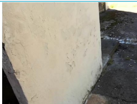
Matériaux : ZPSO-068 Prélèvement : P222 Description : Enduit extérieur (projeté, lissé ou taloché) Localisation : Rez-de-Chaussée - Porche d'entrée Droit Résultat : Absence d'amiante
