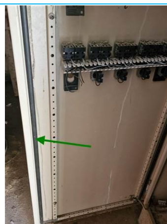
Matériaux : ZPSO-121 Prélèvement : P223 Description : Joint d'étanchéité sur placard Localisation : RDC - CHAUFFERIE Résultat : Absence d'amiante
