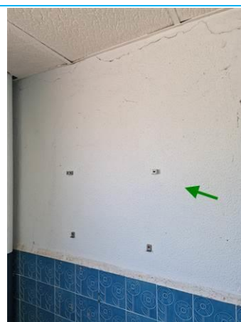
Matériaux : ZPSO-020 Prélèvement : P038 Description : Enduit mural goutelé Localisation : R+2 - SANITAIRES 4 Résultat : Absence d'amiante
