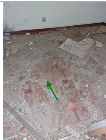
Matériaux : ZPSO-038 Prélèvement : P094 Description : Colle de carrelage rouge Localisation : R+1 - LOCAL 3 Résultat : Absence d'amiante
