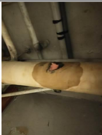
Photo n° PhA006 Localisation : Pièce 1; Pièce 2 Ouvrage : Flocages, Calorifugeages, Faux plafonds Partie d'ouvrage : Calorifugeages Description : Calorifugeages
