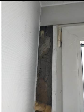
Photo n° PhA007 Localisation : Pièce 1 Ouvrage : 2 - Parois verticales extérieures et Façades - Menuiseries extérieures Partie d'ouvrage : Joint d'étanchéité entre menuiserie et structure Description : Joint d'étanchéité entre menuiserie et structure
