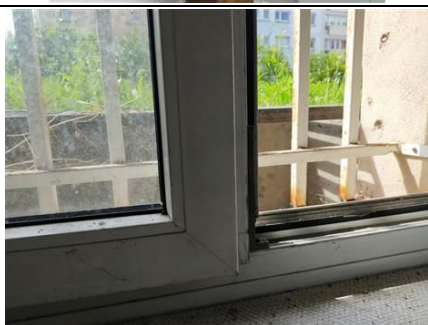
Photo n° PhA008 Localisation : Pièce 1 Ouvrage : 2 - Parois verticales extérieures et Façades - Menuiseries extérieures Partie d'ouvrage : Joint de vitrage Description : Joint de mastic de vitrage Ouvrant+dormant
