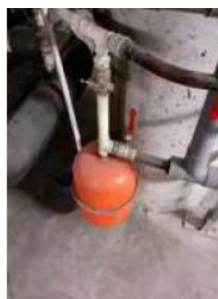
Accessoires hydraulique (circulateur / vase d'expansion)
