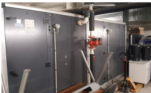
CTA de reprise avec circulateur pour échangeurs
