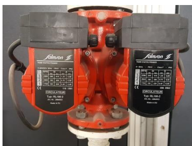
Accessoires hydraulique (circulateur / vase d'expansion)
