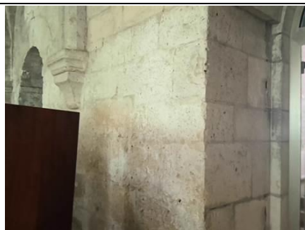
Photo n° PhA006 Localisation : Rez de chaussée - Chapelle Basse Ouvrage : 3 - Parois verticales intérieures - Murs et cloisons maçonnés Partie d'ouvrage : Enduit à base de plâtre lissé ou taloché Description : Enduit à base de plâtre lissé ou taloché
