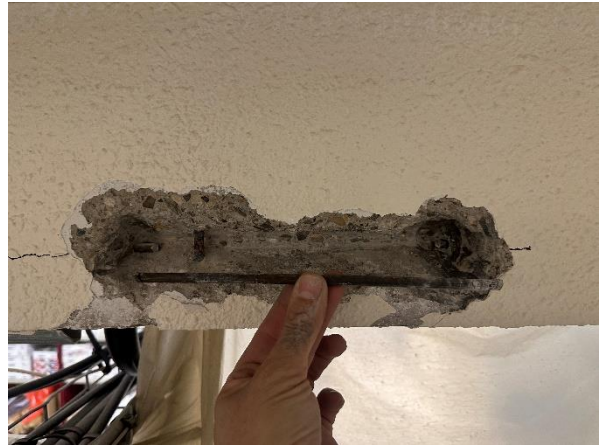
Photographie du prélèvement d'acier sur la poutre précontrainte
