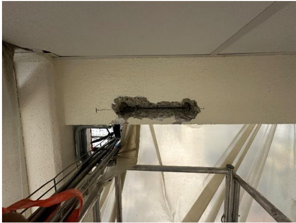
Photographie du prélèvement d'acier sur la poutre précontrainte
