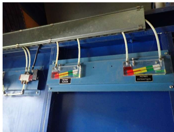
Niveaux encrassement des filtres
