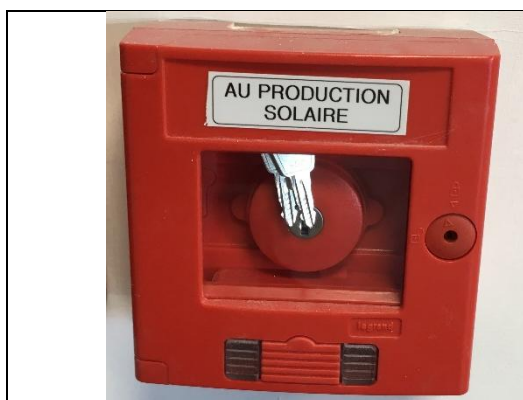
Figure 7a : Exemple d'AU sous verre
