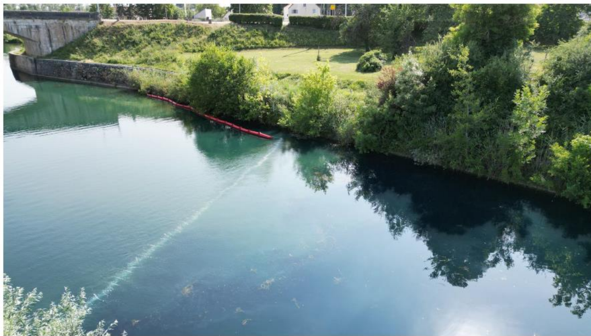
RIDEAU DE BULLE INSTALLE EN 2023. ON OBSERVE UN BARRAGE FLOTTANT A SON EXTREMITÉ AFIN DE TESTER UN RAMASSAGE DEPUIS LA BERGE.
