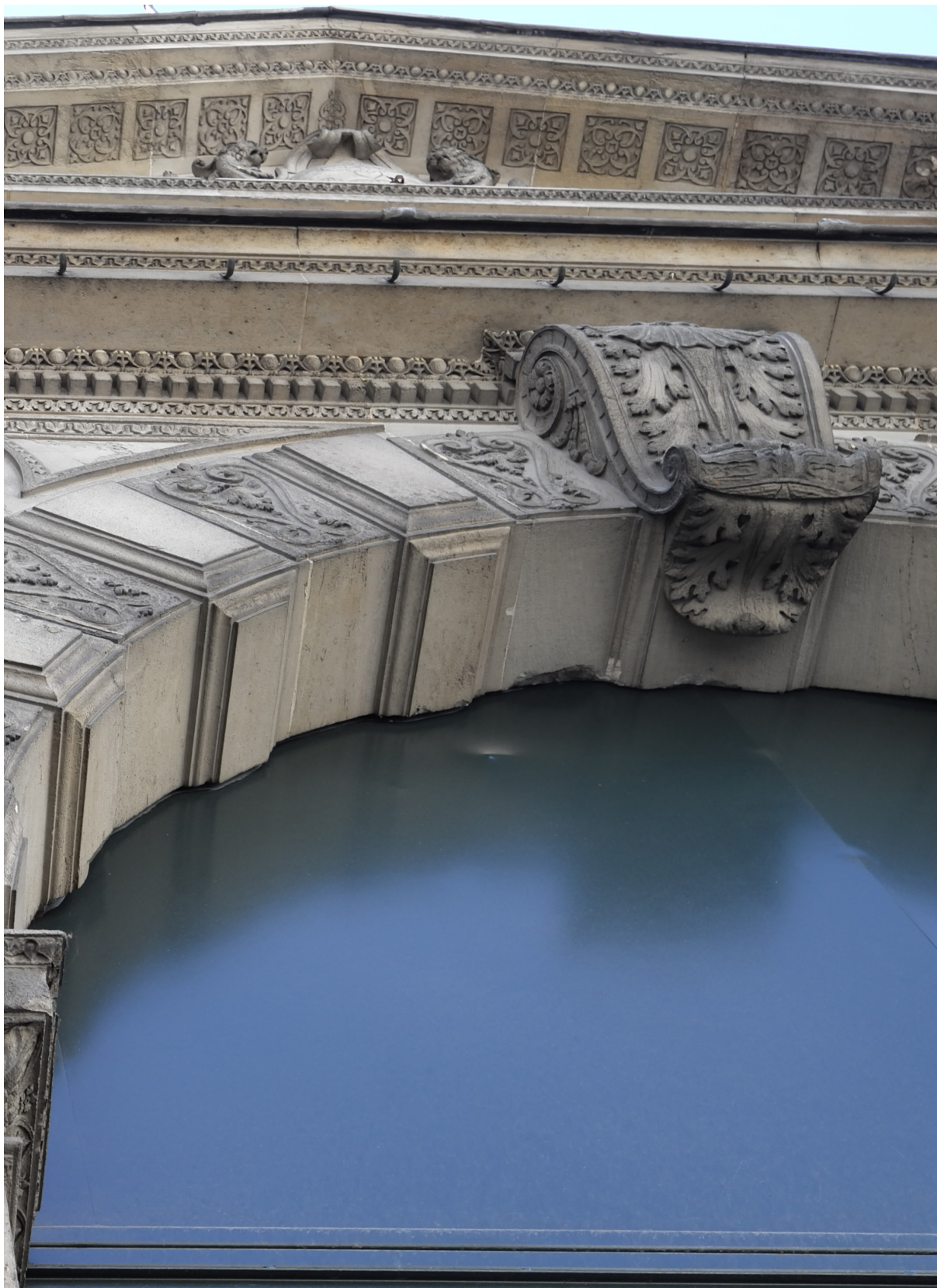
Corniche ornée de frise à oves et dards et de denticules surmontée par le fronton triangulaire orné de caisson
