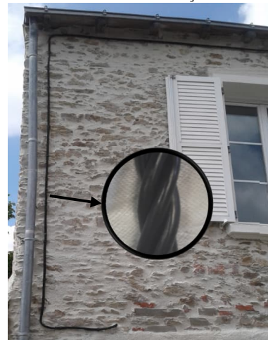
Réseau fils isolés façade BT
