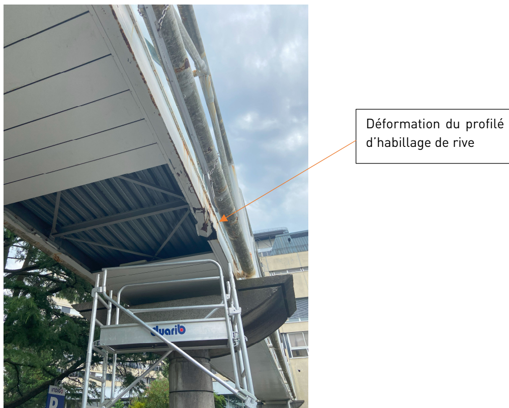
Figure 9 : Déformation du profilé d'habillage de rive
