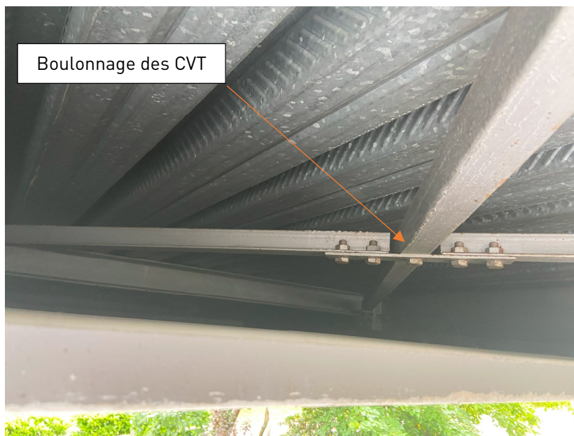
Figure 7 : Assemblage des cornières de contreventement (croisement)
