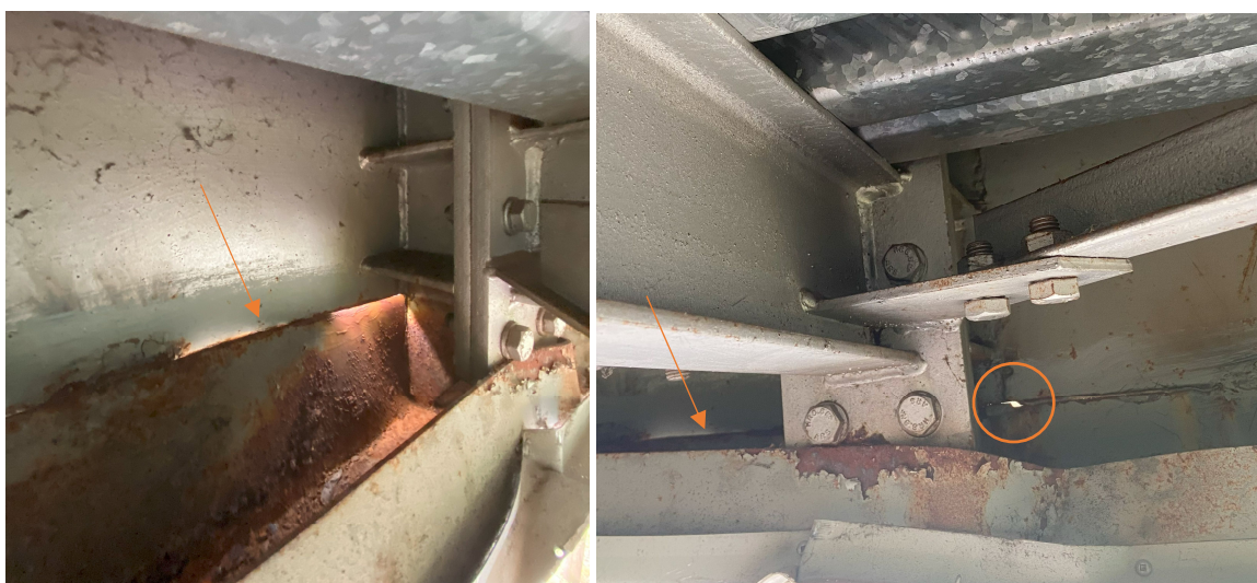
Figures 11 et 12 : Soudures ajourées après la collision, depuis intérieur
