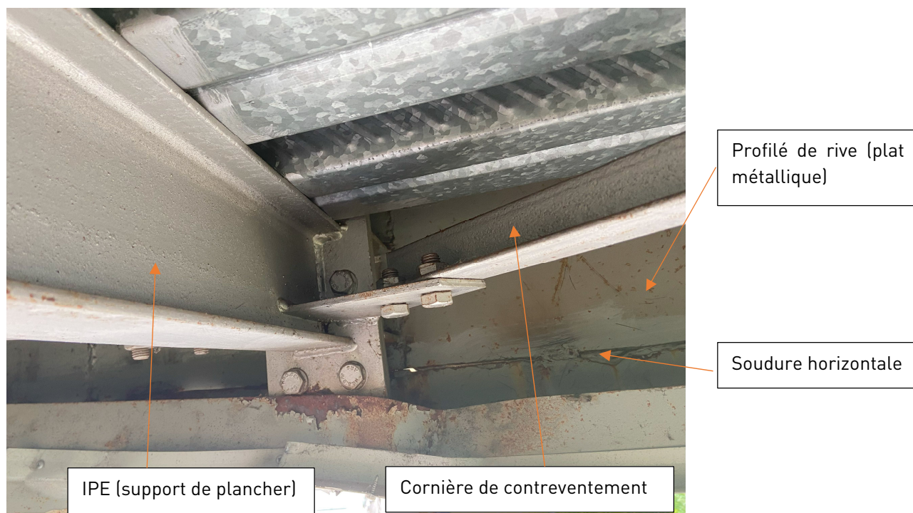
Figure 4 : Appui du profilé supportant le plancher + fixation cornière de contreventement
