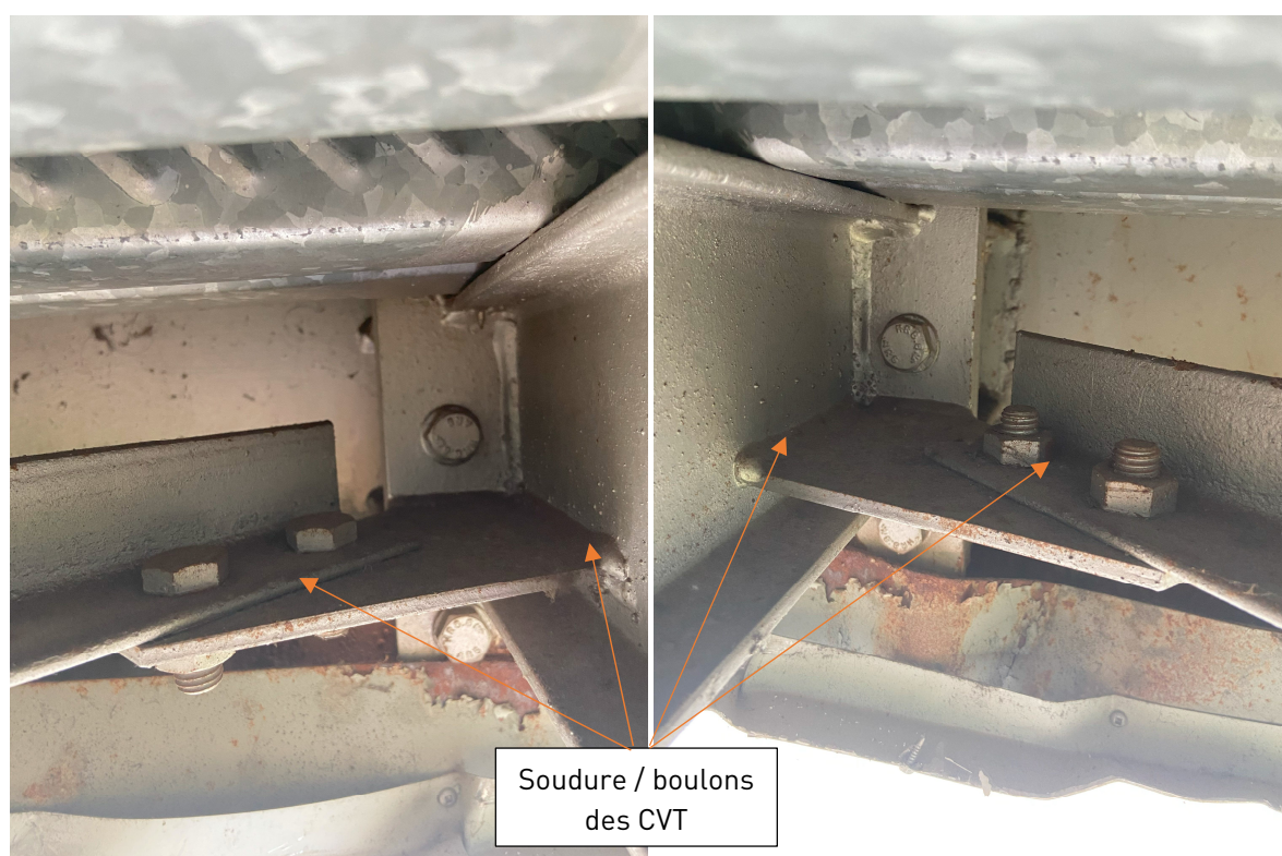
Figures 5 et 6 : Assemblage des cornières de contreventement
