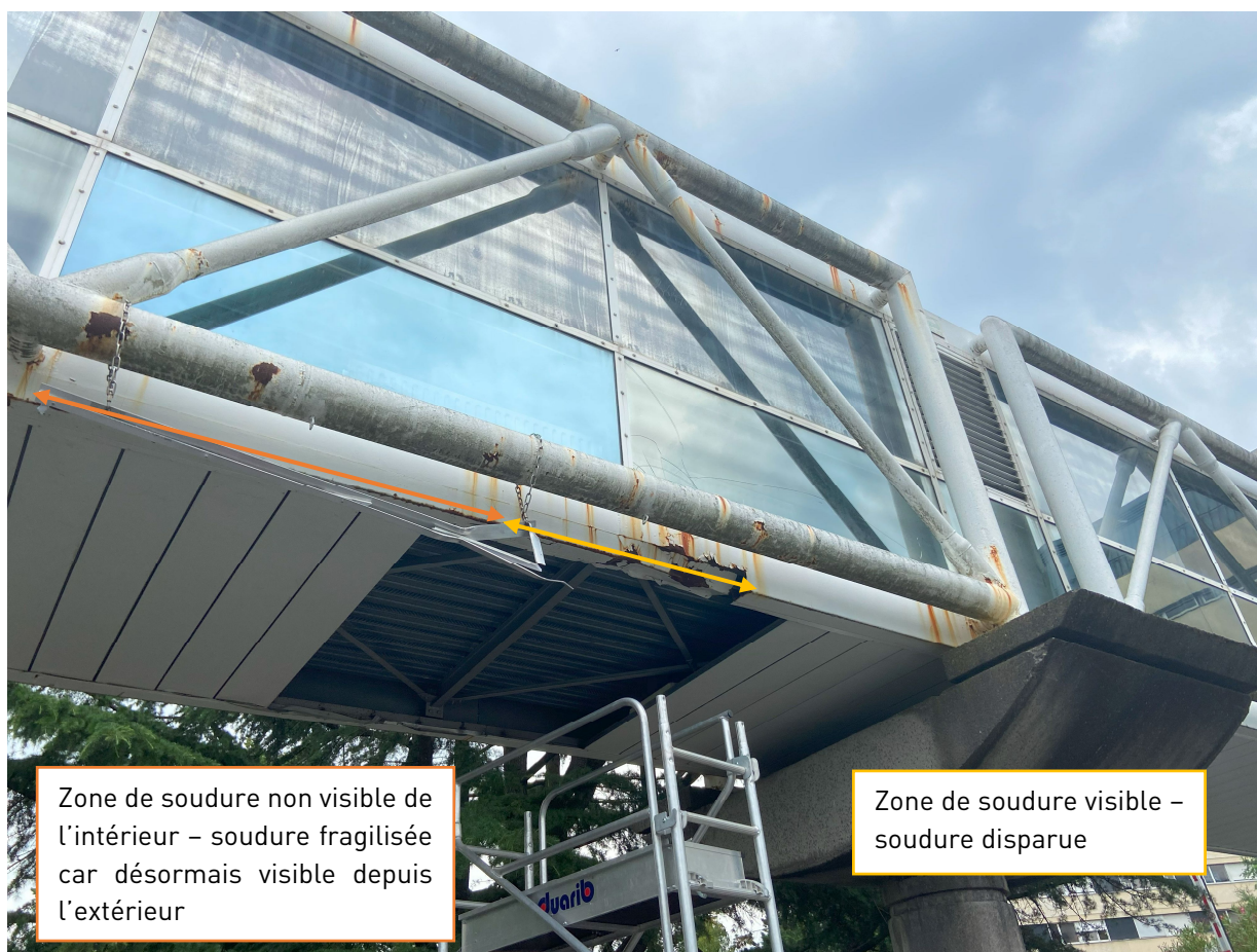
Figure 10 : Localisation de la soudure visible après collision
