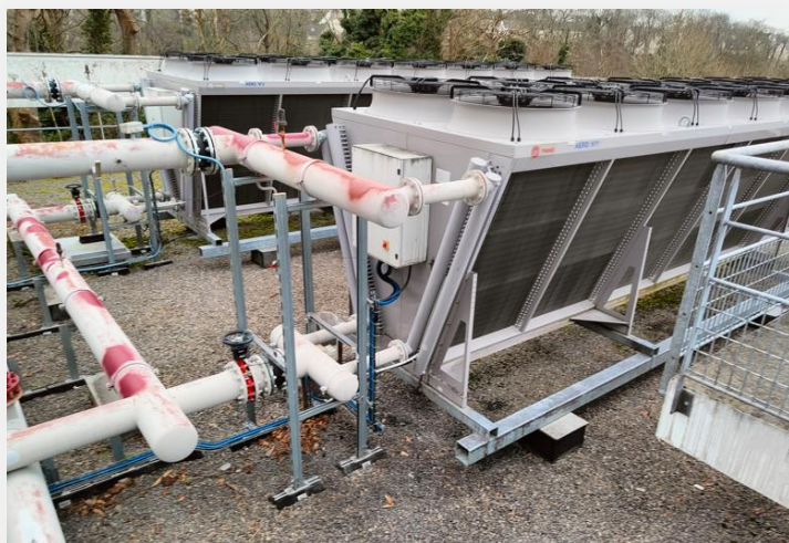
Figure 13 : Photo de la plateforme aérocondenseurs
