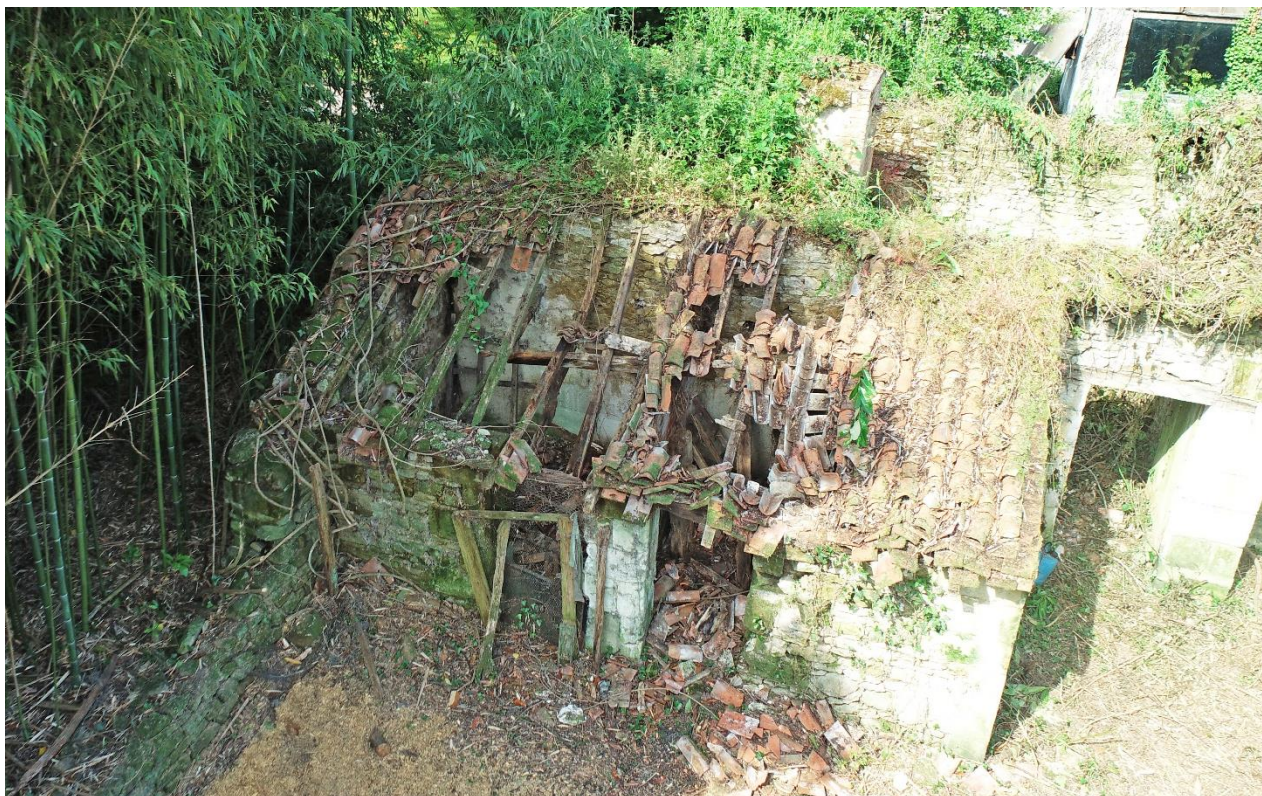
Bâtiment 1 : la toiture est partiellement ruinée et les murs de maçonnerie, exposés aux intempéries, se désorganisent progressivement. La stabilité de l'ouvrage n'est pas assurée
