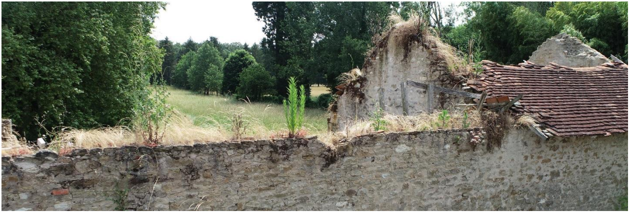
Portion nord du mur : arase lacunaire, sans couronnement de protection, développement de végétaux désorganisant la tête de mur et entraînant des infiltrations en partie supérieure des maçonneries
