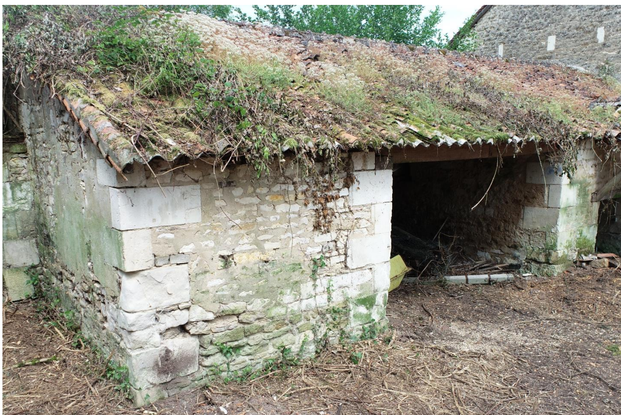
Bâtiment 2 : la maçonnerie est déjointoyée et lacunaire. La couverture en tuile canal est hors d'usage
