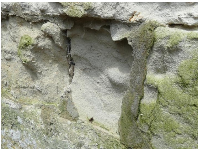
Désagrégation sableuse accentuée par la présence de ciment dans les joints
