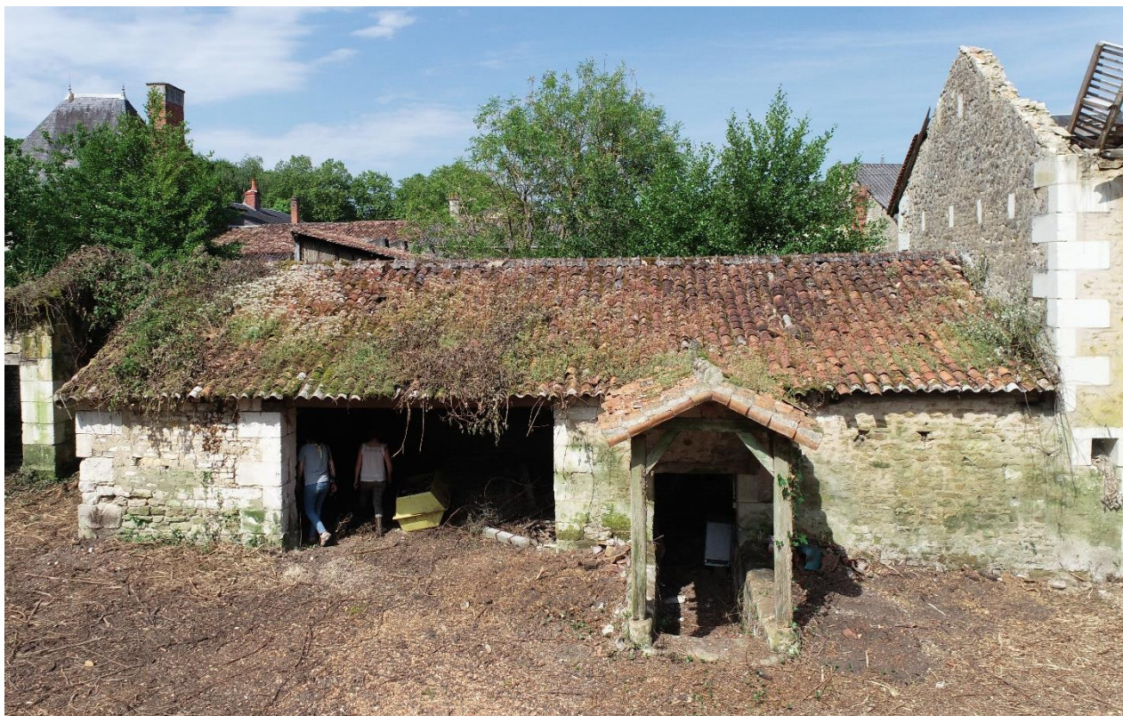
Bâtiment 2 : la couverture de tuile canal est posée sur des tôles ondulées en fibro-ciment (à base d'amiante). Les tuiles sont envahies par la végétation et les organismes microbiologiques (mousses) et glissent
