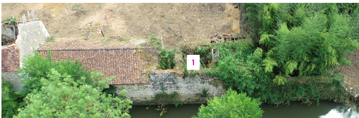
Portion de mur déjointoyé et recouvert de végétation
