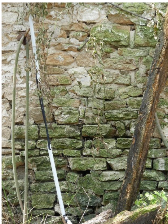
Elévation est (à gauche) et ouest (à droite) : parement déjointoyé, développement d'algues vertes
