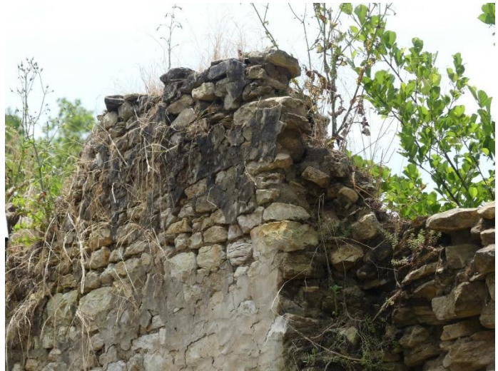
Arase complètement déjointoyée en équilibre précaire
