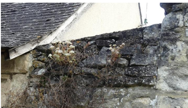
Couronnement rejointoyé et noirci par des algues noires (cyanobactéries)
