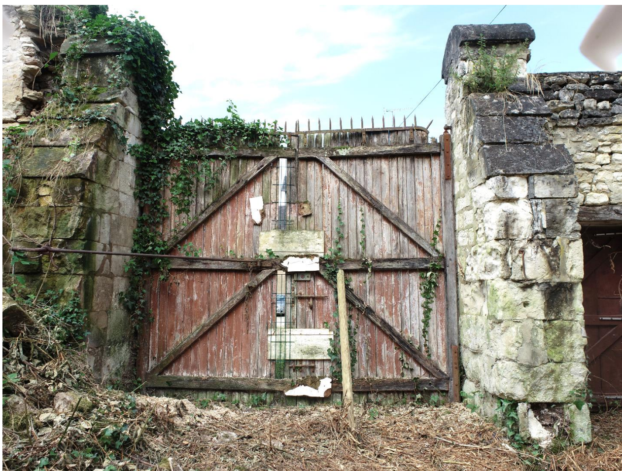
Elévation ouest du portail d'accès au parc du château : piles en pierre de taille en très mauvais état (pierres desquamées, parement déjointoyé et développement de végétation) et portail bois hors d'usage
