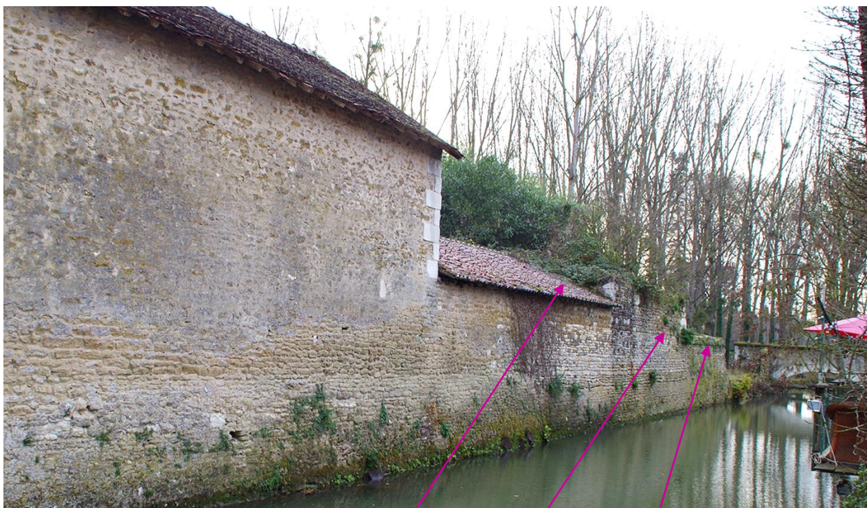
Le mur d'enceinte en 2016. A droite du cliché, on observe nettement une portion de mur avec son chaperon dont la hauteur correspond à celle du parapet du pont dans l'angle sud. Entre cette portion de mur et le pont le mur est effondré en totalité
