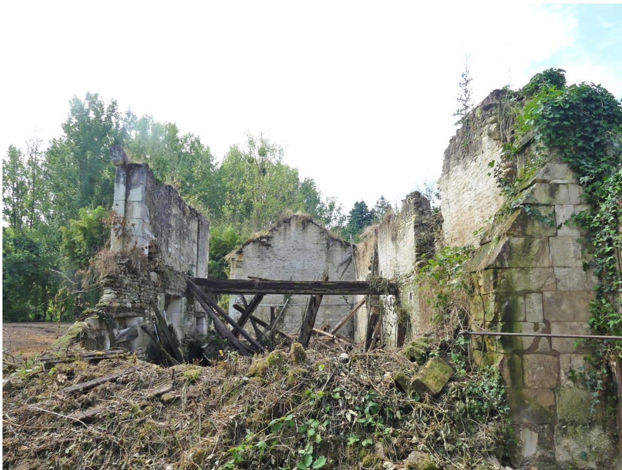
Bâtiment 4 depuis le nord dont il ne reste que quelques murs et les vestiges de la poutre d'un ancien plancher
