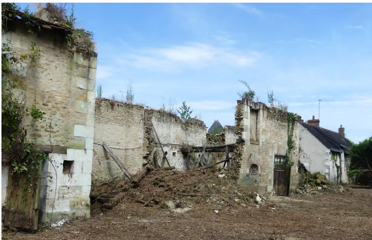
Bâtiment 4 depuis le sud-est : mur gouttereau est en équilibre précaire
