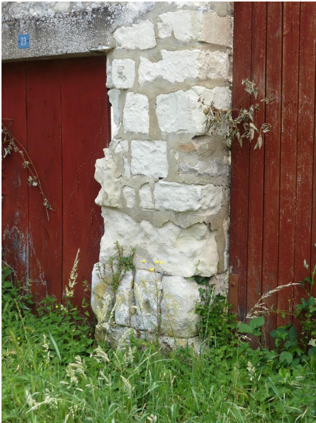
Elévation ouest : pile rejointoyée au ciment et pierre desquamée en profondeur
