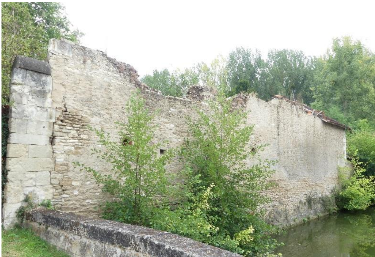
Portion de mur nord : développement d'arbre en pied de mur et arase irrégulière
