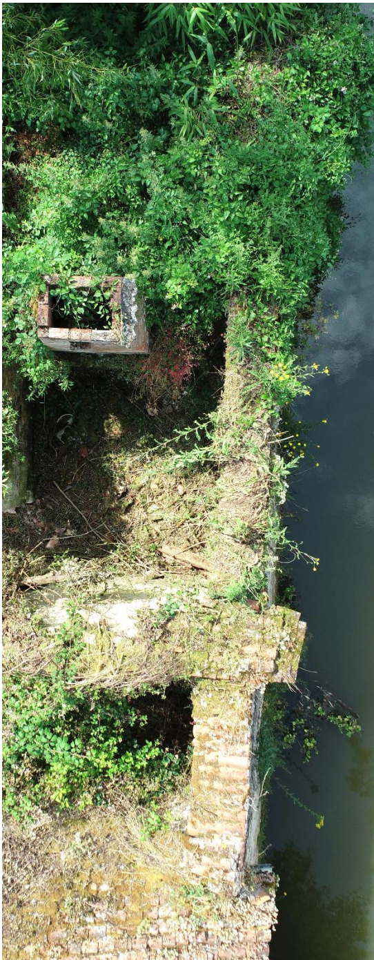
Portion nord du mur : arase lacunaire, sans couronnement de protection, développement de végétaux désorganisant la tête de mur et entraînant des infiltrations en partie supérieure des maçonneries
