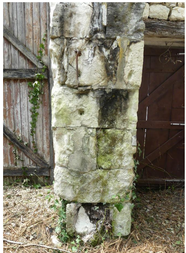
Elévation est, pile en très mauvais état : désagrégation sableuse de la pierre et dislocation en partie inférieure. Des ragréages et joints au ciment ont été effectués
