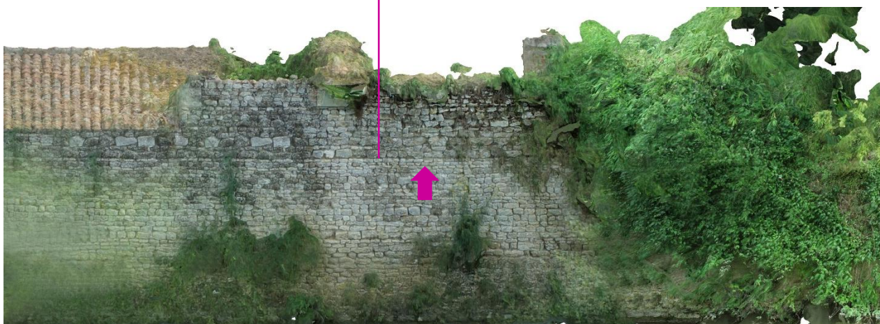
Détail de l'ortho-image. La maçonnerie rapportée sur le mur est très lisible
