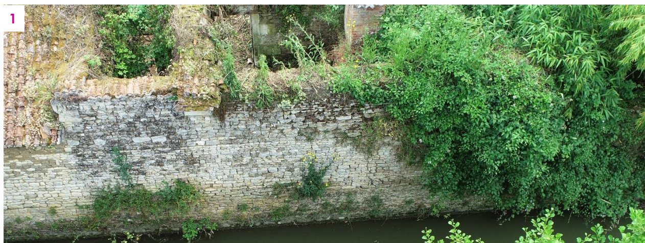
Développement de végétation sur les arases non protégées et parement déjointoyé
