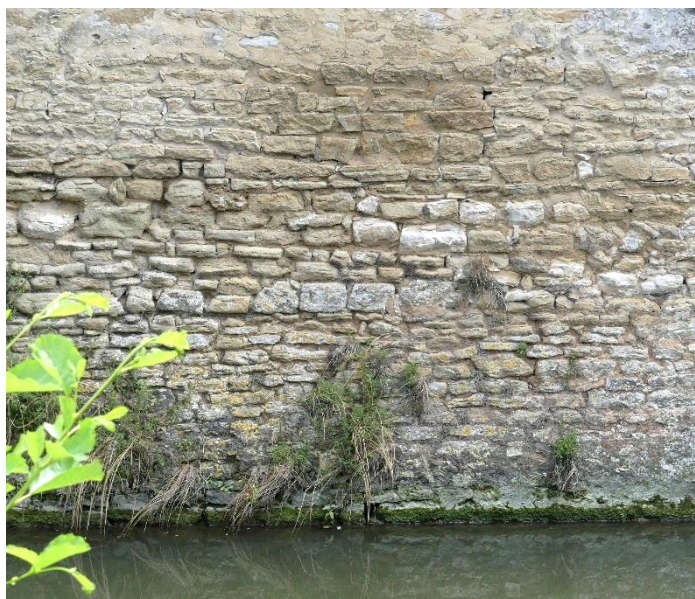
Elévation est (à gauche) et ouest (à droite) : parement déjointoyé, développement d'algues vertes
