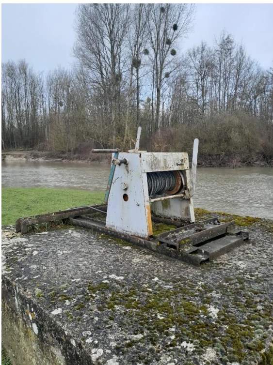
Treuil manuel installé actuellement au barrage d'Asfeld
