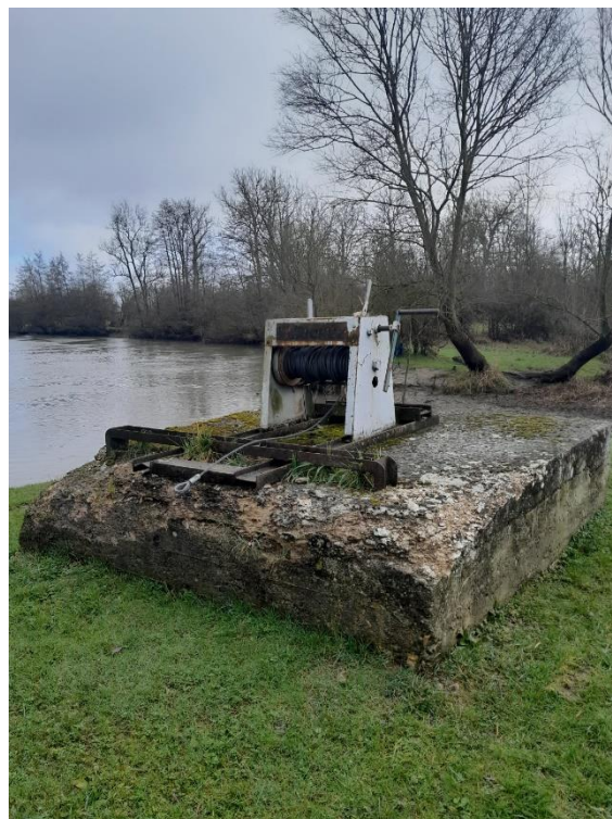
Treuil manuel installé actuellement au barrage d'Asfeld
