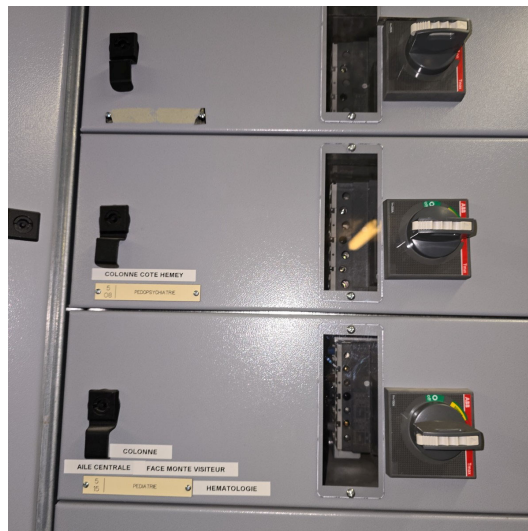
Colonne aile centrale Hémato ABB 4x100A
