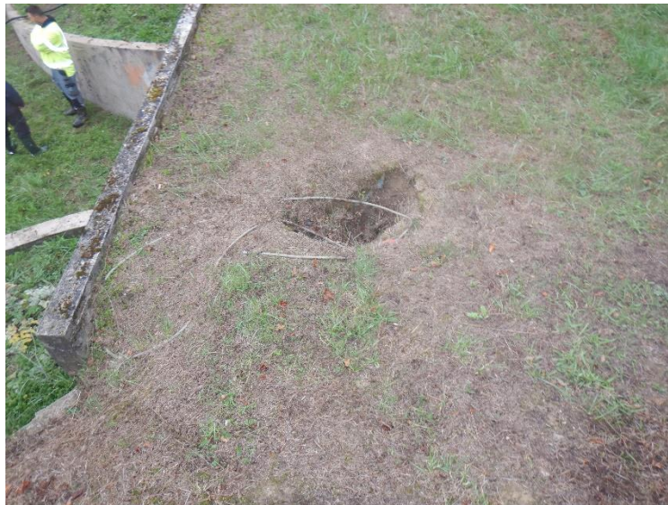
Fig. 16. Photographie du trou sur le toit de la chambre de vanne
