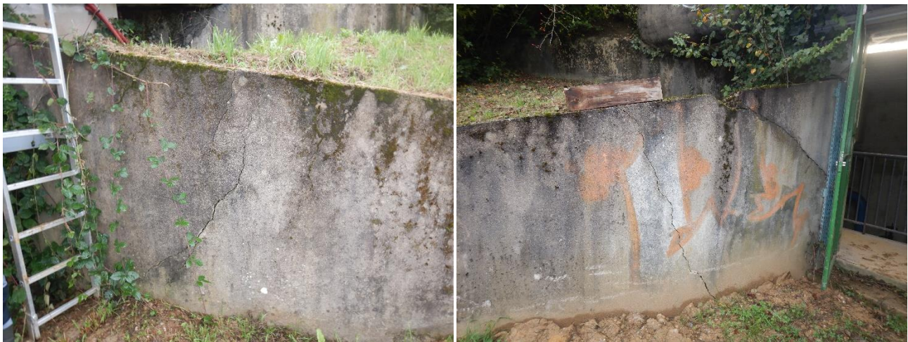
Fig. 17. Photographies des fissures présentes sur le mur de soutènement
