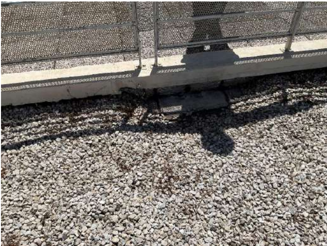
Pas de platine et défaut étanchéité sur traversées Joint de dilatation non étanche
