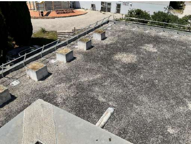
Présence de jardinières bétons posés sur isolant
