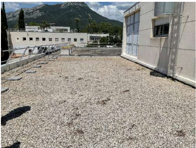
Hauteur relevés contre bâtiment inférieur à 7 cm
