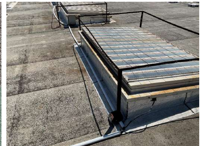
Traversée de câble directement sur relevé
