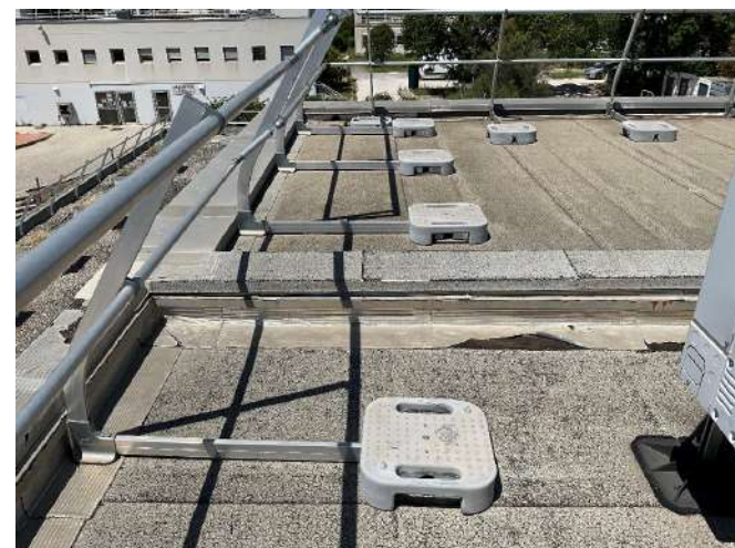
Traversé de fourreaux/câbles directement en traversées d'acrotères
