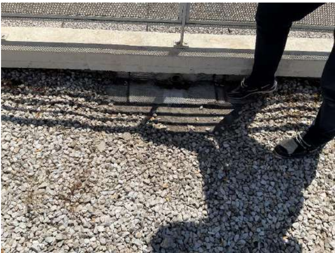
Réservation pour écoulement EP avec terrasse B
