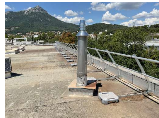
Etanchéité non conforme souche cheminée
