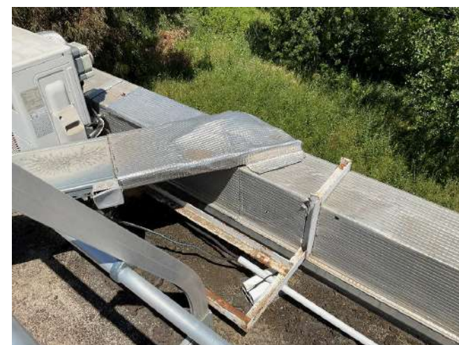
Traversé de fourreaux/câbles directement en traversées d'acrotères
