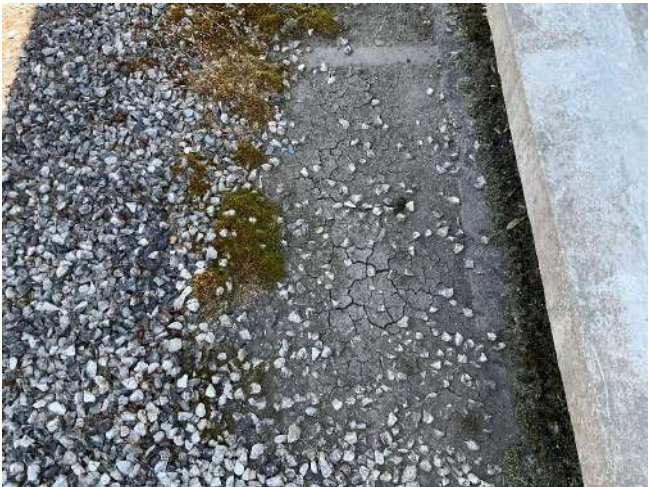
Présence de terres et fines avec les gravillons
