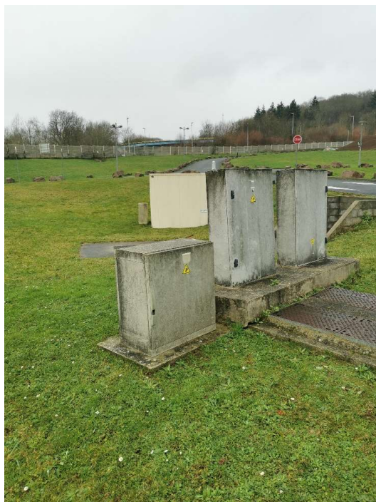
Armoire de commande des pompes
