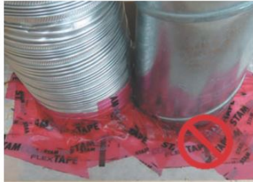
Espace de réservation insuffisant pour permettre une bonne mise en œuvre du calfeutrement
