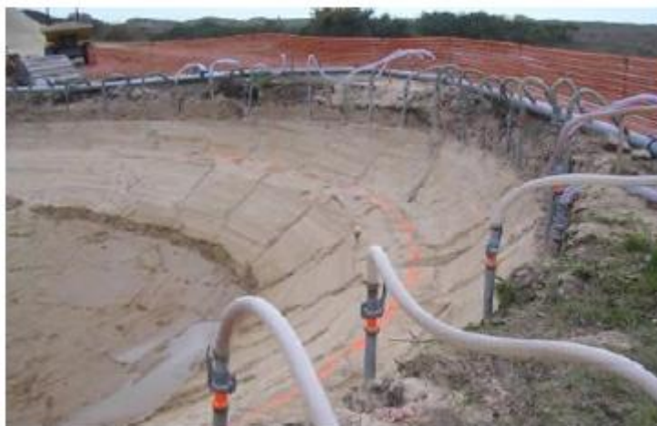
Figure 22 : Vue aérienne d'une installation de pointes filtrantes
