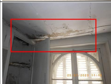
Photo n° PhTer018 Localisation : 1er étage - Pièce 1009 Ouvrage : Plafond - Plâtre Parasite : Champignon de pourriture fibreuse (ou pourriture blanche) du type Polypore des caves ( Donkioporia expansa ) Indices : Présence de pourriture fibreuse, solives visibles localement coté fenêtre fortement dégradées, présence étendue. Informations complémentaires : Plafond en cours d'effondrement, prévoir la dépose total du plafond, prévoir la mise en sécurité totale et sans délais.
