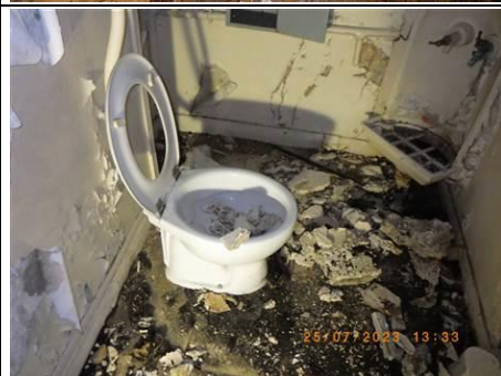
Photo n° PhTer028 Localisation : 1er étage - WC Ouvrage : Plafond - Plâtre Parasite : Champignon de pourriture fibreuse Indices : Présence de pourriture fibreuse, dégradations importantes, solives visibles localement fortement dégradées. Informations complémentaires : Infiltrations en cours, plafond en cours d'effondrement, prévoir mise en sécurité sans délai.
