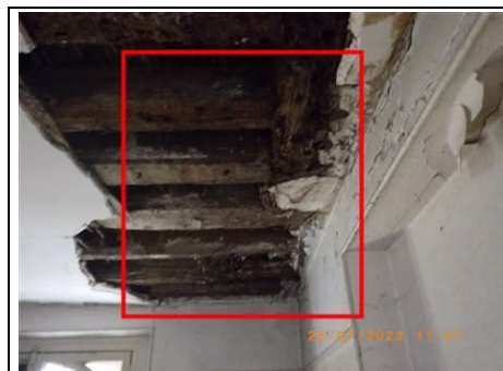
Photo n° PhTer016 Localisation : 1er étage - Pièce 1007 Ouvrage : Plafond - Plâtre Parasite : Champignon de pourriture fibreuse Indices : Présence de pourriture fibreuse, dégradations importantes. Informations complémentaires : Plafond en cours d'effondrement à l'angle, infiltrations en cours, prévoir la mise en sécurité sans délai.
