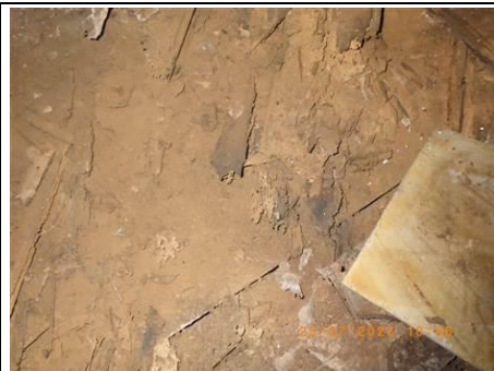
Photo n° PhTer012 Localisation : 1er étage - Pièce 1006 Ouvrage : Sol - Dalles pvc sur parquet bois Parasite : Grosses vrillettes ( Xestobium rufovillosum ), Champignon de pourriture fibreuse (ou pourriture blanche) du type Polypore des caves ( Donkioporia expansa ) Indices : Dégradation du bois, présence de trous de sortie, présence de vermoulure, dégradations importantes, présence étendue, Présence de mycélium, présence de pourriture fibreuse, parquet bois fortement dégradé, présence étendue.
