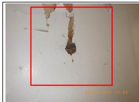
Photo n° PhTer025 Localisation : 1er étage - Pièce 1034 Ouvrage : Mur - Plâtre mur NORD Parasite : Champignon de pourriture fibreuse (ou pourriture blanche) du type Polypore des caves ( Donkioporia expansa ) Indices : Présence de fructification, infestations faibles, présence faible sur le mur NORD. Informations complémentaires : Prévoir des sondages complémentaires sur la zone.
