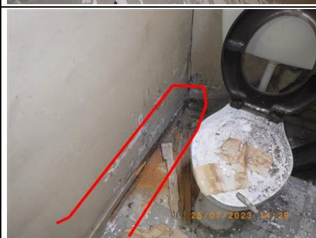
Photo n° PhTer042 Localisation : 2ème étage comble Nord - Sanitaires Ouvrage : Plinthes en bois Parasite : Champignon de pourriture cubique du type conioaphore des caves ( Coniophora puteana ) (Humidité importante) Indices : Présence de pourriture cubique, dégradations importantes, infestations importantes.
