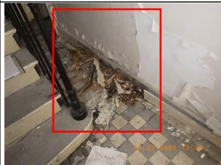
Photo n° PhTer027 Localisation : 1er étage - Pièce 1022 Bas d'escalier Ouvrage : Plinthes en bois Parasite : Champignon de pourriture cubique du type conioaphore des caves ( Coniophora puteana ) (Humidité importante) Indices : Présence de mycélium, présence de pourriture cubique, dégradations importantes, présence étendue sur le mur N/EST et sur le mur S/Ouest.
