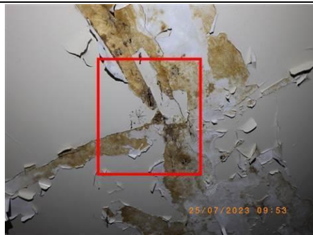
Photo n° PhTer002 Localisation : Rez de chaussée - Pièce 107A Ouvrage : Mur - Faïence, peinture écaillée, plâtre Parasite : Champignon de pourriture fibreuse de type Coprinus Domesticus Indices : présence de fructification, présence de mycélium (présence étendue)
