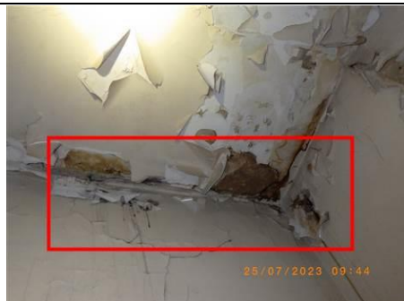
Photo n° PhTer003 Localisation : Rez de chaussée - Pièce 104A Ouvrage : Plafond - Peinture écaillée, plâtre Informations complémentaires : Plafond en cours d'effondrement à l'angle SUD
