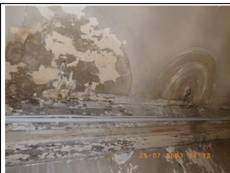
Photo n° PhTer041 Localisation : 2ème étage comble Sud - Couloir Ouvrage : Plafond - Plâtre Informations complémentaires : Infiltrations en cours, prévoir des sondages complémentaires sur la zone.
