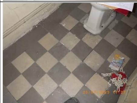
Photo n° PhTer026 Localisation : 1er étage - Pièce 1036/1021 Ouvrage : Sol - Carrelage Informations complémentaires : Le sol des WC est instables, prévoir des sondages.
