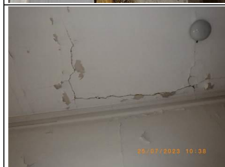
Photo n° PhTer011 Localisation : 1er étage - Pièce 1025 couloir Ouvrage : Plafond - Plâtre Informations complémentaires : Plusieurs fissures visibles au plafond, prévoir des sondages pour analyses de l'état du solivage.
