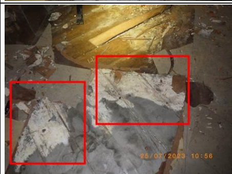
Photo n° PhTer013 Localisation : 1er étage - Pièce 1006 Ouvrage : Sol - Dalles pvc sur parquet bois Parasite : Grosses vrillettes ( Xestobium rufovillosum ), Champignon de pourriture fibreuse (ou pourriture blanche) du type Polypore des caves ( Donkioporia expansa ) Indices : Dégradation du bois, présence de trous de sortie, présence de vermoulure, dégradations importantes, présence étendue, Présence de mycélium, présence de pourriture fibreuse, parquet bois fortement dégradé, présence étendue.
