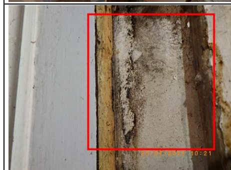
Photo n° PhTer010 Localisation : Rez de chaussée - Pièce 126A Ouvrage : Mur - Parement bois (toute hauteur) Parasite : Champignon de pourriture fibreuse Indices : Présence de pourriture fibreuse, présence étendue sur les tasseaux visibles à l'angle Sud/Ouest.
