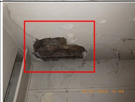
Photo n° PhTer014 Localisation : 1er étage - Pièce 1006 Ouvrage : Plafond - Plâtre Parasite : Champignon de pourriture fibreuse de type Coprinus Domesticus Indices : Présence de fructification, présence de mycélium, présence étendue au plafond.
