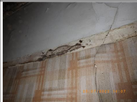
Photo n° PhTer039 Localisation : 1er étage - Pièce 1001 Ouvrage : Plafond - Plâtre Parasite : Champignon de pourriture cubique du type coniophore des caves ( Coniophora puteana ) (Humidité importante), Champignon de pourriture fibreuse Indices : Présence de mycélium, présence de pourriture cubique, présence de pourriture fibreuse, solives fortement dégradées, infestation importante. Informations complémentaires : Infiltrations en cours avec effondrement du plafond, prévoir des sondages sur la totalité du plafond pour l'analyse des solives.
