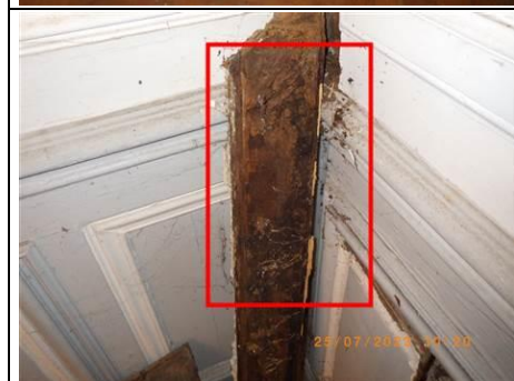
Photo n° PhTer009 Localisation : Rez de chaussée - Pièce 126A Ouvrage : Mur - Parement bois (toute hauteur) Parasite : Grosses vrillettes ( Xestobium rufovillosum ) Indices : Présence de trous de sortie, présence de vermoulure, dégradations importantes, présence étendue en zones internes des parement bois.
