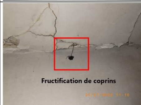
Photo n° PhTer017 Localisation : 1er étage - Pièce 1008 Ouvrage : Plafond - Plâtre Parasite : Champignon de pourriture fibreuse de type Coprinus Domesticus Indices : Présence de fructification, présence de mycélium. Informations complémentaires : Plafond fissuré, prévoir des sondages complémentaires.
