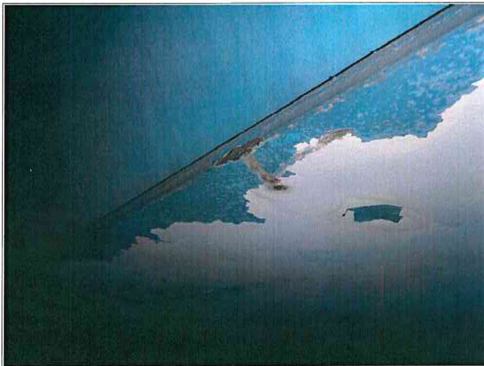
Photo 3: Caisson n°2: Rayures et traces de choc en angle de caisson avec oxydation de la zone affectée + décollement de peinture.
