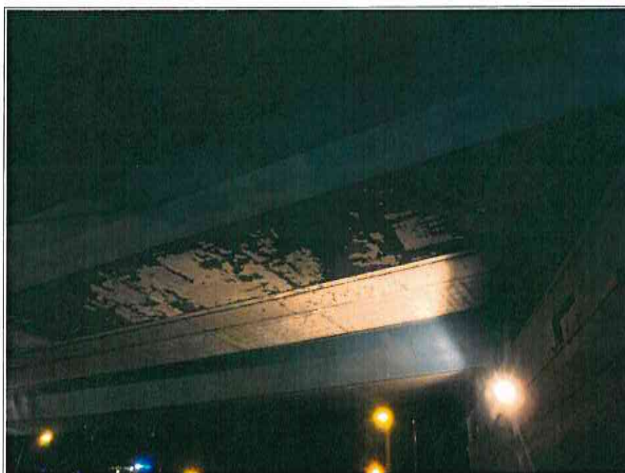
Photo 4: Caisson n°2 : Écaillage et absence de la peinture de protection en about côté Nord.
