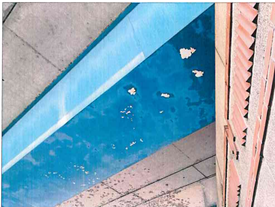
Photo 5: Caisson n°3 – Manque de peinture ponctuellement.
