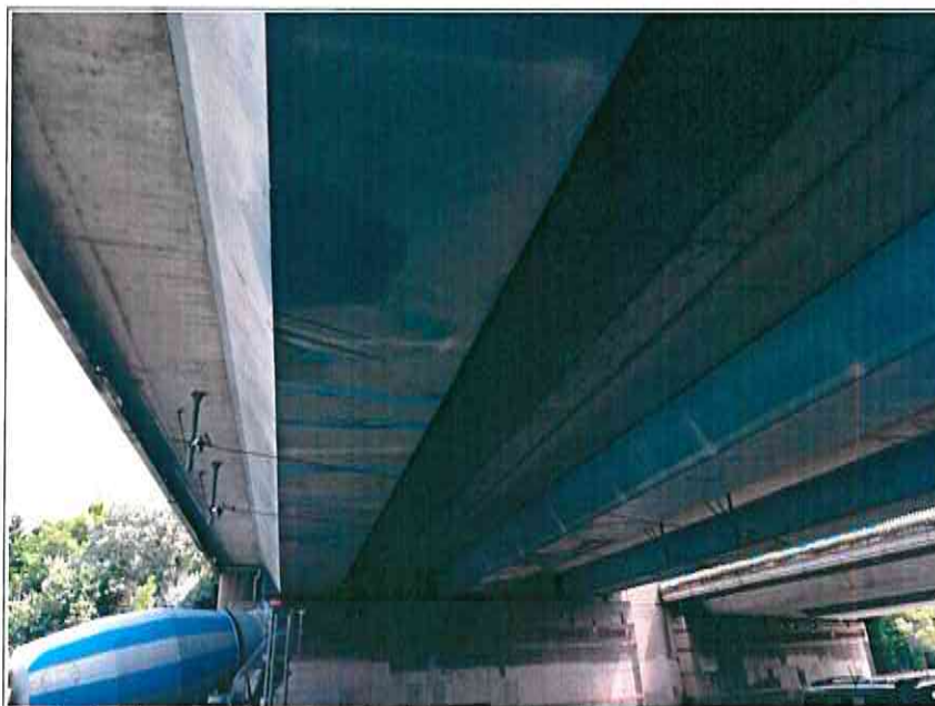
Photo 1: Rayures et éclats de peinture sur le caisson.
