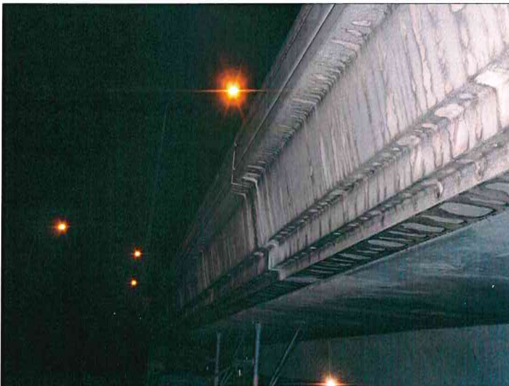
Photo 10: Coulures sèches le long des corniches côté Toulouse.
