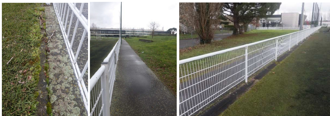
Bordure béton – Circulation en enrobé – Lice et caniveau CC1
