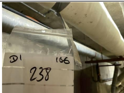
Photo n° PhA239 Localisation : Sous-Sol Ouvrage : Calorifugeage Description : Enduit blanc + tissu + isolant Localisation sur croquis : 238 Amiante : Non détecté
