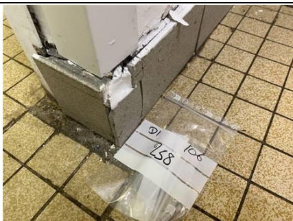
Photo n° PhA259 Localisation : Sous-Sol - Dégagement Ouvrage : Mur Description : Colle de plinthe Localisation sur croquis : 258 Amiante : Non détecté
