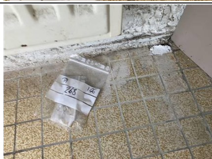
Photo n° PhA269 Localisation : Sous-Sol - 010 Ouvrage : Sol Description : Colle de carrelage + ragréage Localisation sur croquis : 268 Amiante : Non détecté
