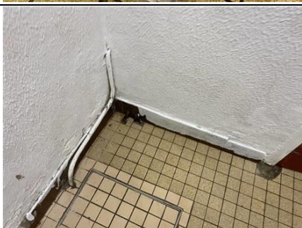
Photo n° PhA260 Localisation : Sous-Sol - 006 Ouvrage : Mur de cloison Description : Peinture + plâtre Localisation sur croquis : 259 Amiante : Non détecté
