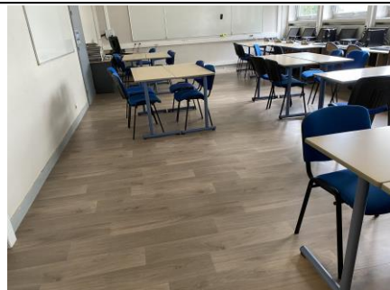
Description : Revêtement de sol non collé Localisation sur croquis : V11
