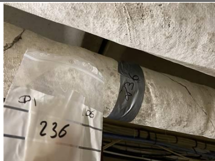
Photo n° PhA237 Localisation : Sous-Sol Ouvrage : Calorifugeage Description : Enduit blanc + tissu + isolant Localisation sur croquis : 236 Amiante : Non détecté
