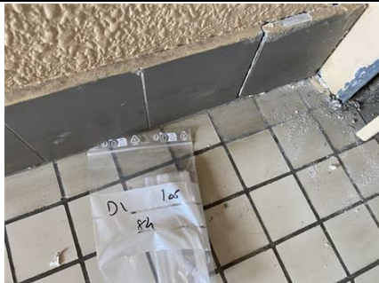
Photo n° PhA084 Localisation : Bâtiment 27 - 1er étage - 112 Ouvrage : Mur Description : Colle de plinthe Localisation sur croquis : 84 Amiante : Non détecté
