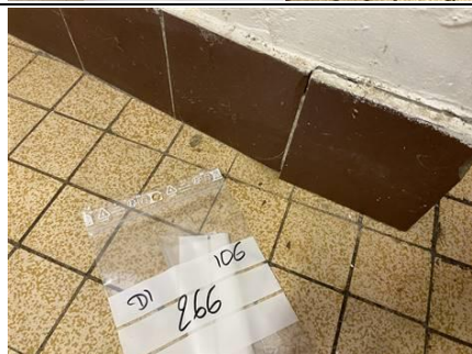
Photo n° PhA267 Localisation : Sous-Sol - 006 Ouvrage : Mur Description : Colle de plinthe Localisation sur croquis : 266 Amiante : Chrysotile
