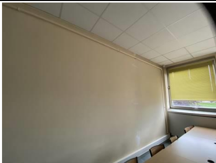
Photo n° PhA088 Localisation : Bâtiment 27 - 1er étage - 113 Ouvrage : Mur de doublage Description : Peinture + enduit blanc + béton gris Localisation sur croquis : 88 Amiante : Non détecté
