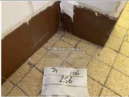
Photo n° PhA257 Localisation : Sous-Sol - 007 Ouvrage : Mur Description : Colle de plinthe Localisation sur croquis : 256 Amiante : Non détecté
