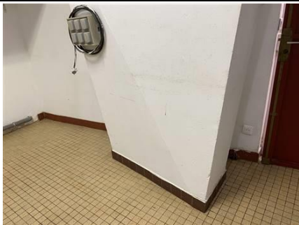
Photo n° PhA258 Localisation : Sous-Sol - 006 Ouvrage : Sol Description : Colle de carrelage + ragréage Localisation sur croquis : 257 Amiante : Non détecté
