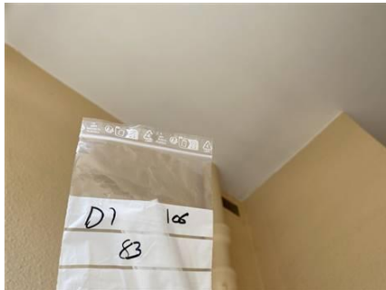
Photo n° PhA083 Localisation : Bâtiment 27 - 1er étage - 111 Ouvrage : Plafond Description : Peinture + enduit blanc + béton gris Localisation sur croquis : 83 Amiante : Non détecté
