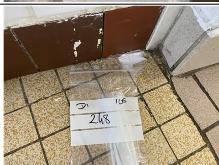
Photo n° PhA249 Localisation : Sous-Sol - 007 Ouvrage : Sol Description : Colle de carrelage + ragréage Localisation sur croquis : 248 Amiante : Non détecté
