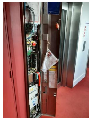
Baie palière avec armoire de commande
