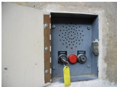
Commande palière du niveau principal
