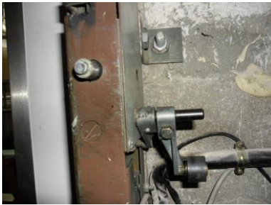
Serrure de porte palière du niveau principal
