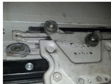
Serrure de porte palière du niveau principal
