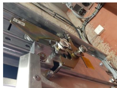
Serrure de porte palière du niveau principal
