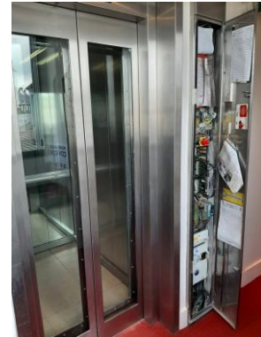
Baie palière avec armoire de commande
