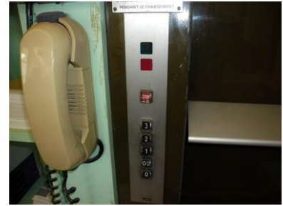
Commande palière du niveau principal
