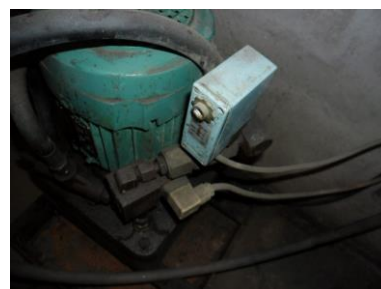
Centrale Hydraulique
