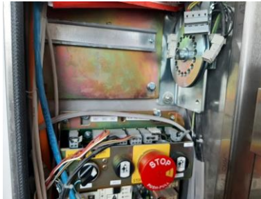
Dispositif de manoeuvre de secours au palier
