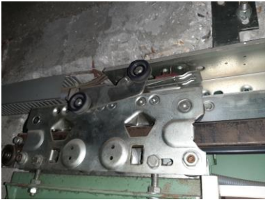
Serrure de porte palière du niveau principal
