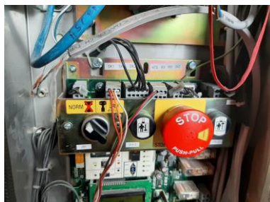
Dispositif de manoeuvre de secours au palier
