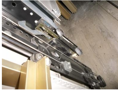
Serrure de porte palière du niveau principal
