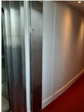
Trappe de commande au palier
