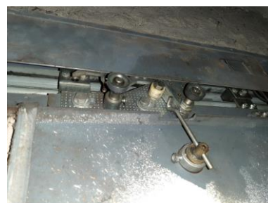
Serrure de porte palière du niveau principal
