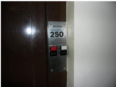
Commande palière du niveau principal
