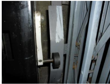
Serrure de porte palière du niveau principal
