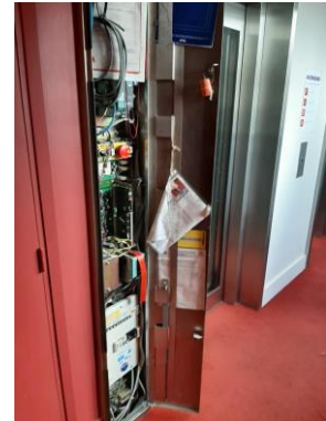
Baie palière avec armoire de commande
