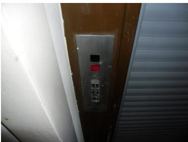
Signalisation palière du niveau principal
