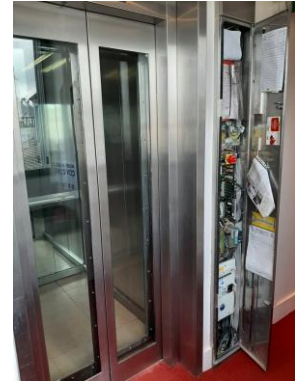
Baie palière avec armoire de commande
