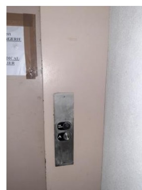
Commande palière du niveau principal
