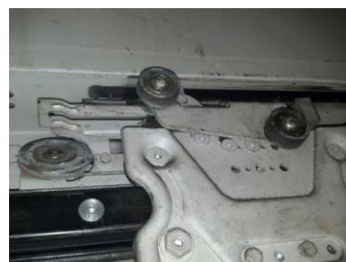
Serrure de porte palière du niveau principal
