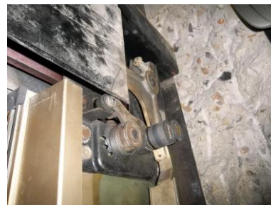
Serrure de porte palière du niveau principal
