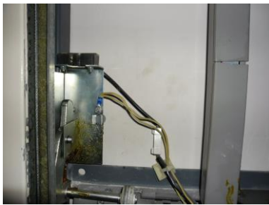
Serrure de porte palière du niveau principal
