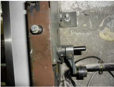
Serrure de porte palière du niveau principal
