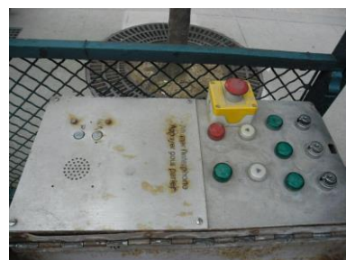
Commande palière du niveau principal
