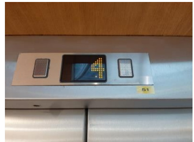
Signalisation palière du niveau principal
