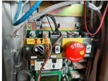
Dispositif de manoeuvre de secours au palier
