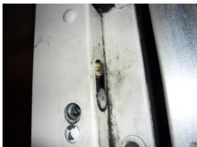
Serrure de porte palière du niveau principal
