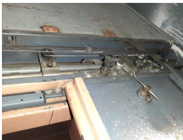
Serrure de porte palière du niveau principal
