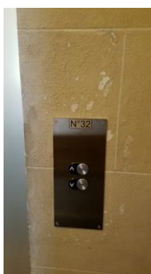
Commande palière du niveau principal
