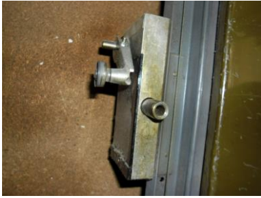
Serrure de porte palière du niveau principal
