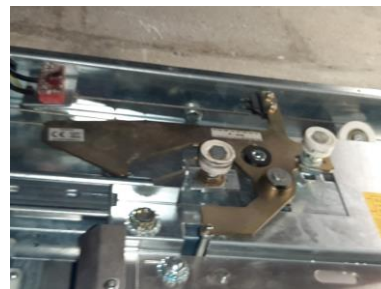
Serrure de porte palière du niveau principal
