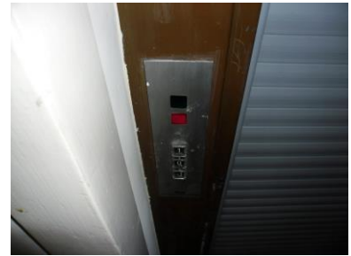
Commande palière du niveau principal
