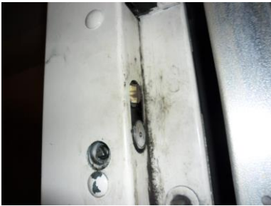
Serrure de porte palière du niveau principal
