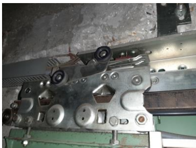
Serrure de porte palière du niveau principal
