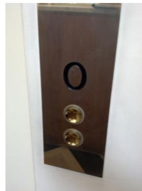
Commande palière du niveau principal
