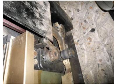
Serrure de porte palière du niveau principal
