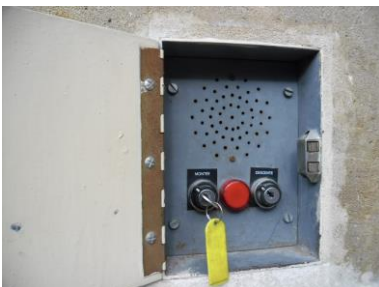
Commande palière du niveau principal
