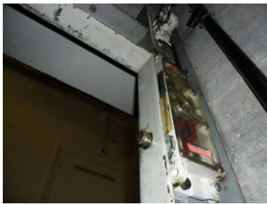
Serrure de porte palière du niveau principal
