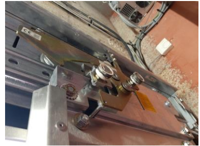
Serrure de porte palière du niveau principal
