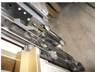
Serrure de porte palière du niveau principal
