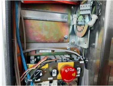
Dispositif de manoeuvre de secours au palier
