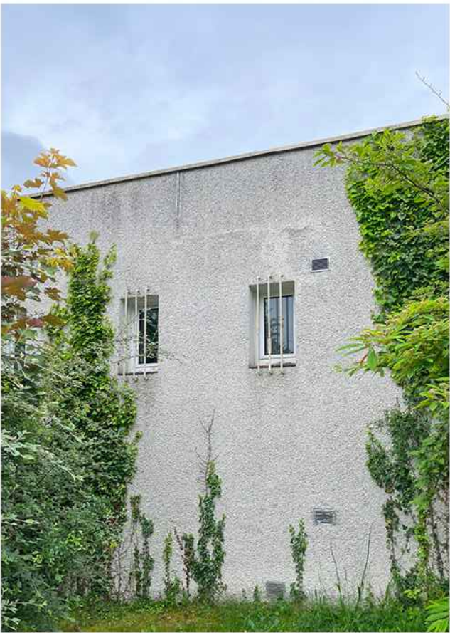
façade enduit (amianté)
