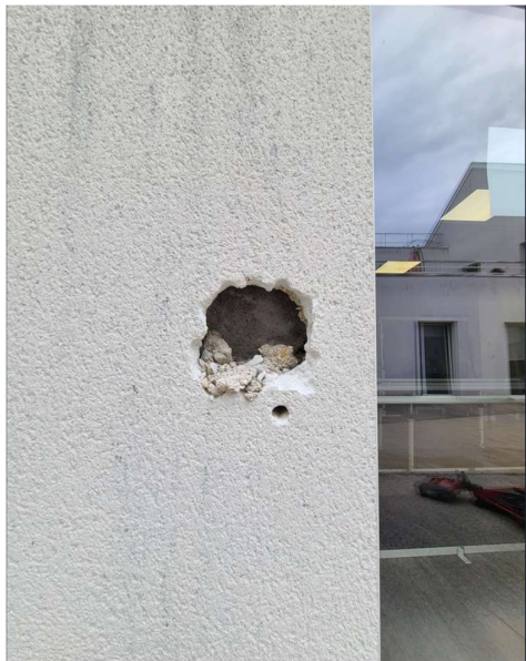
Sondage sur maçonnerie creuse
