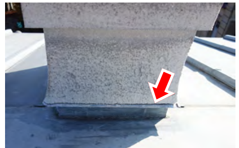
Clichés ci-contre et ci-dessus : exutoire de couverture et altération de feuilles en zinc ; décollement des enduits au droit des relevés
