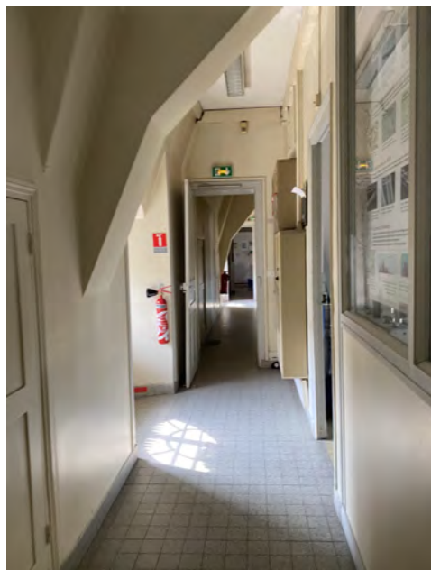
Vue des pieds de fermes encoffrés à l'étage du bâtiment A
