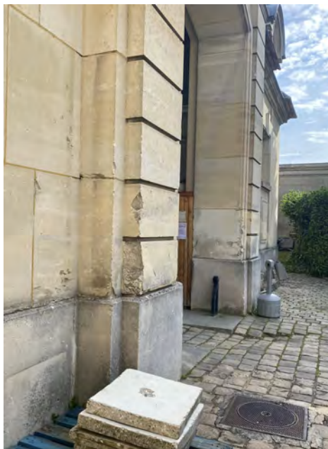
Epaufure des piédroits à l'entrée de la cour couverte
