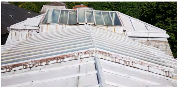
Déformation et soulèvement du faîtage de la verrière sud (bâtiment B). On note également un défaut de mise en œuvre : recouvrement hasardeux, plis, etc.)
