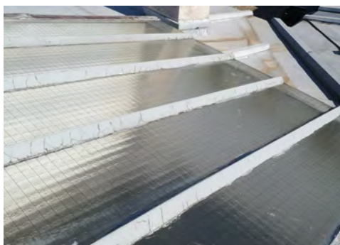
Fissuration des mastics des verrières. Nota : clichés montrant les mastics dégradés récemment repris au droit du bâtiment C'
