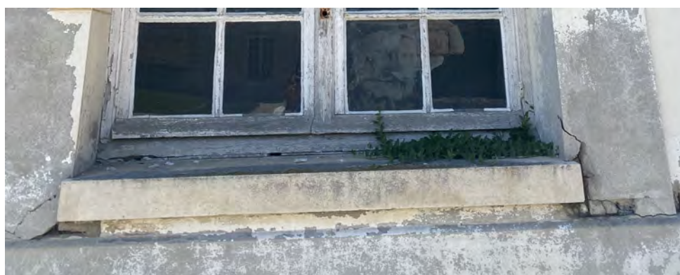
Vue de l'appui de fenêtre de la F012e - Eclatement des ouvrages en béton ou ciment, développement de végétation parasite
