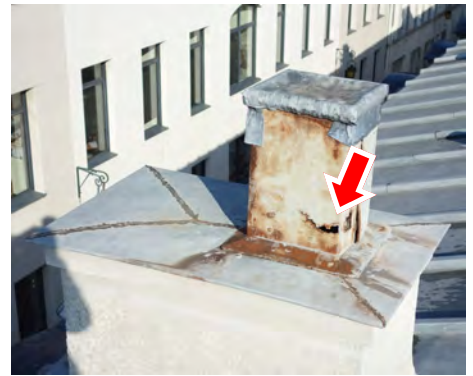
Corrosion de la souche métallique
