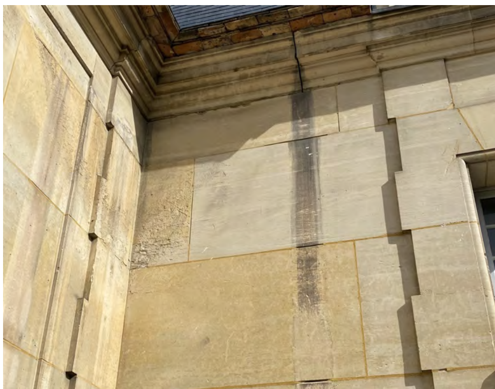
Trace d'infiltration, dues à la défaillance des couvertures, sur les parements en pierre et dégarnissage des joints
