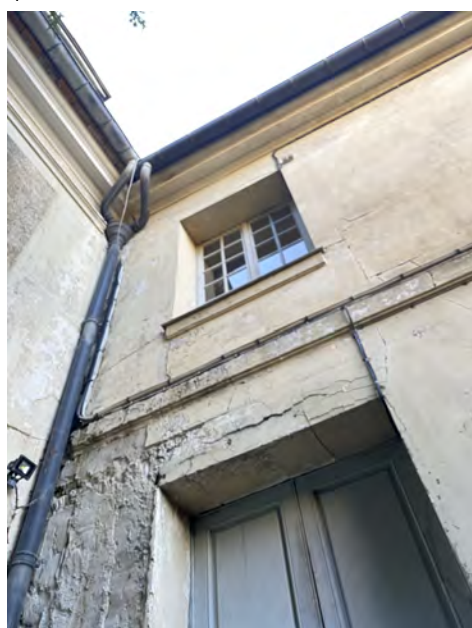
Disparition partielle des enduits en plâtre et fissuration au droit du linteau
