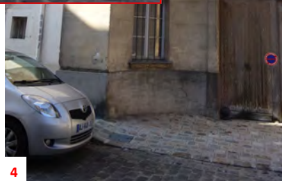
4. Revêtement en pavé avec faux joint tiré au fer et jointoiment en ciment couvrant
