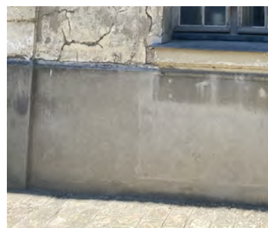
Remplacement des soubassement par des éléments en ciment
