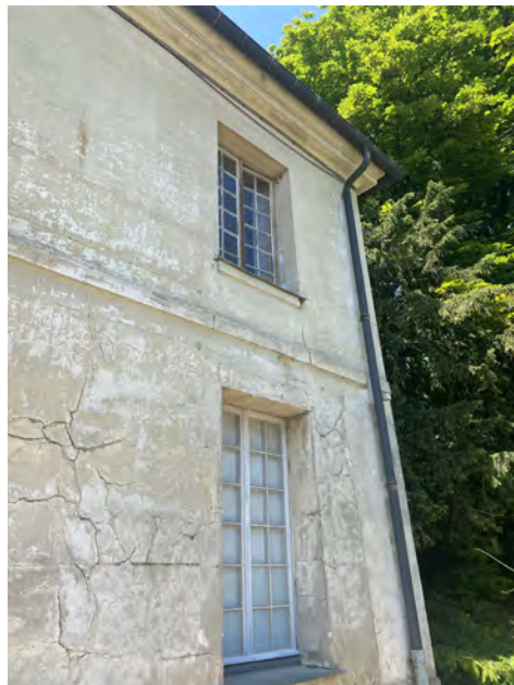
Altération des enduits plâtre de la façade est du bâtiment D - Fissuration, décollement et reprises ponctuelles
