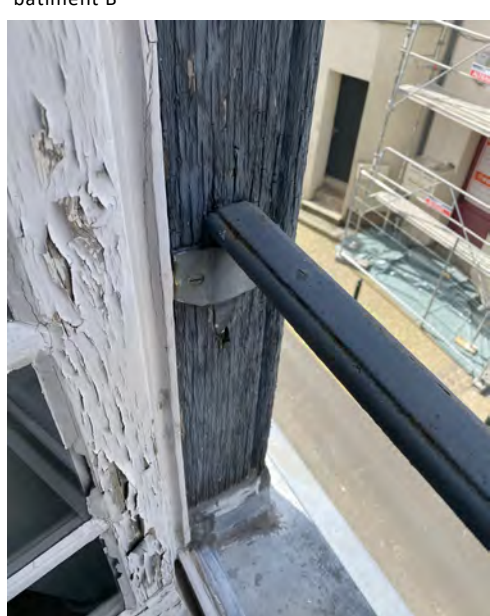
Détail de fixation du fer plat et du fer carré formant la barre d'appui par vissage
