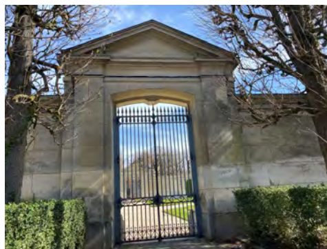
Encrassement et développement de mousses et lichens sur les maçonneries du portail oriental de la cour
