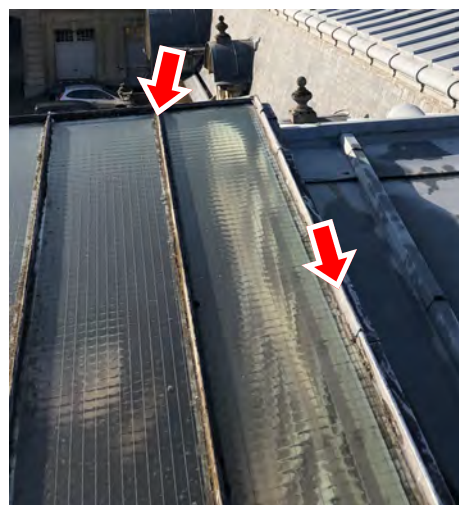
Défaut d'étanchéité de la verrière couvrant la cour couverte
