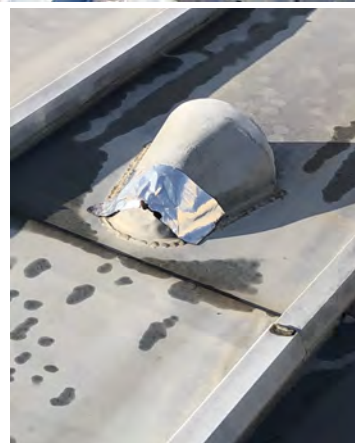
Réparation non pérenne au droit d'une chatière de ventilation
