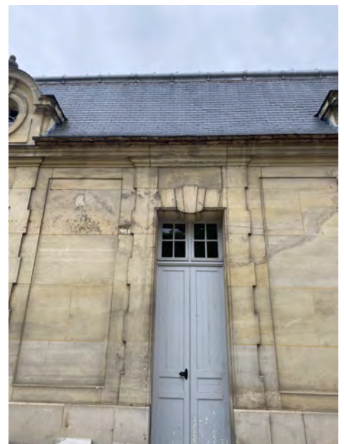
Encrassement des pierres de façade
