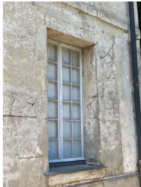
Altération des enduits plâtre de la façade est du bâtiment D - Fissuration, décollement et reprises ponctuelles
