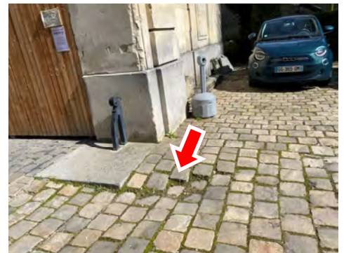
Déformation et affaissement ponctuel du sol pavé de l'allée principale
