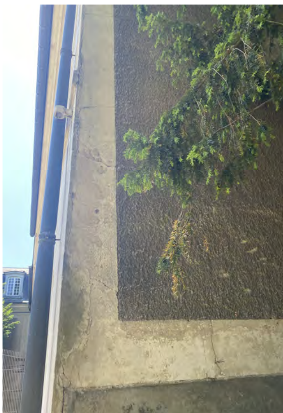
Altération des enduits plâtre : fissuration, décollement du support, encrassement
