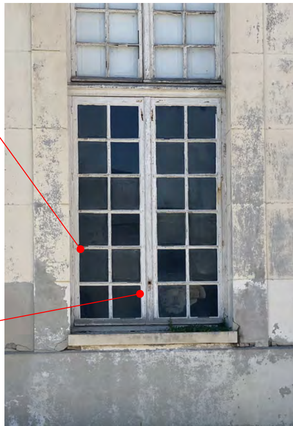
Modification de la fenêtre F011e avec la création d'un châssis dormant et d'un « carré pompier »
