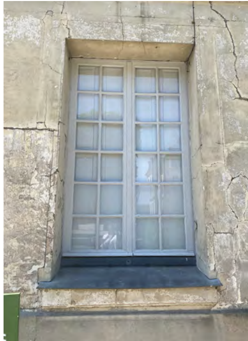
Vue d'une menuiserie à vantaux droit à petit carreau - baie F016e
