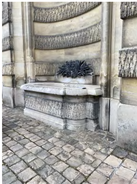
Encrassement des bossages à congélation et des pierres de la niche concave de la fontaine
