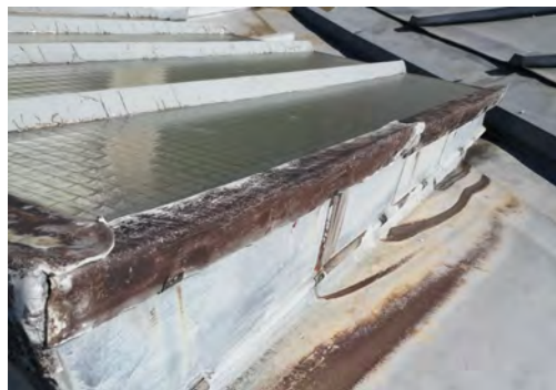
Défaut d'étanchéité de la verrière couvrant la cour couverte
