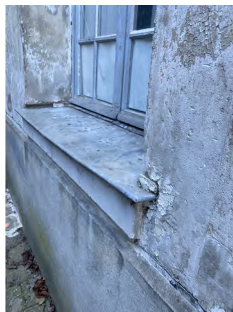
Ecaillage des badigeon de finition, altération des enduits
