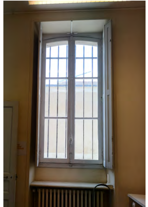
Vue d'une menuiserie à vantaux cintré à grand carreau - baie F018o
