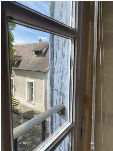
Détail de fixation de la main courante et des barreaux par vissage
