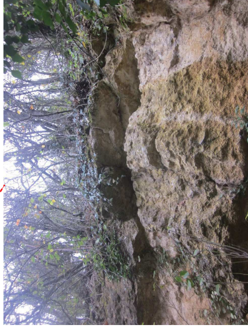
Exemples d'aléas repérés, purges localement possibles, mais résiduel à traiter par grillage plaqué
