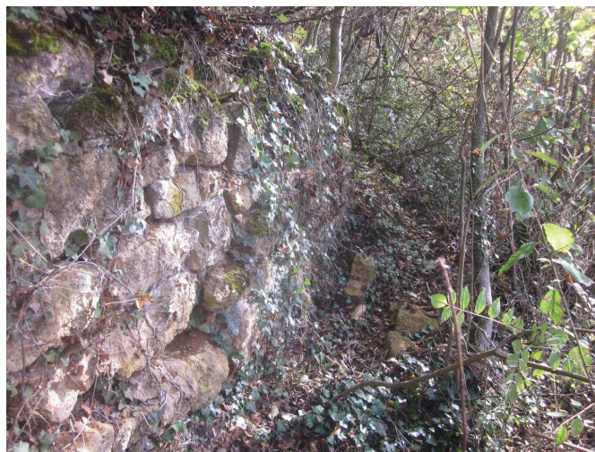
Muret en cours de déstabilisation. Replat en contrebas
