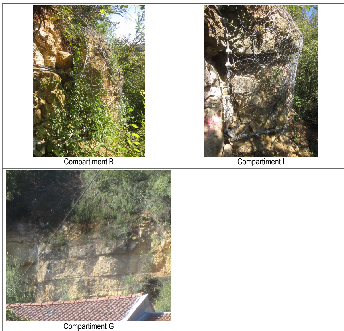
Figure 9 : filets plaqués-ancrés des compartiments B, G et I (Cerema, 23/09/2021).
