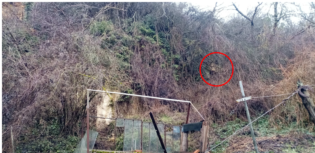
Vue de la falaise inférieure à l'arrière de l'habitation (éléments à purger entourés en rouge)
