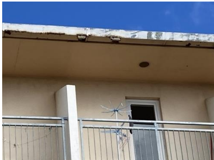
Chéneaux de collecte des EP : état de corrosion avancée.
