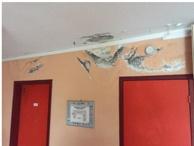
Infiltrations d'eau : clos et couvert mais aussi fuites gaines techniques verticales AEP.
