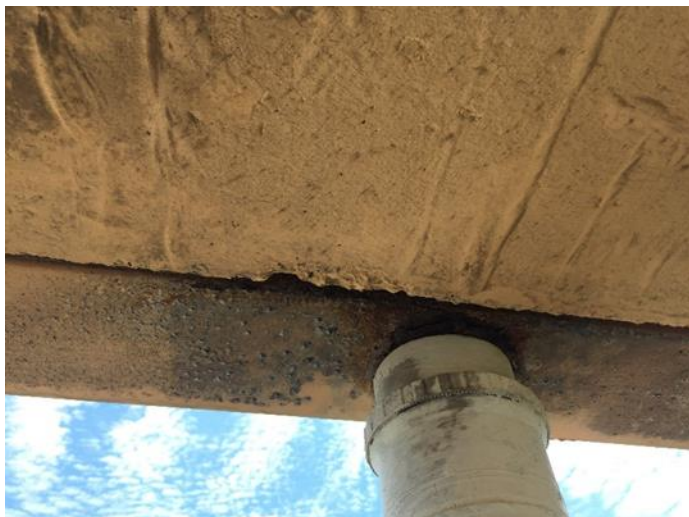
Chéneaux de collecte des EP : état de corrosion avancée.
