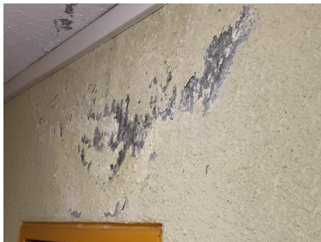
Infiltrations d'eau : clos et couvert mais aussi fuites gaines techniques verticales AEP.
