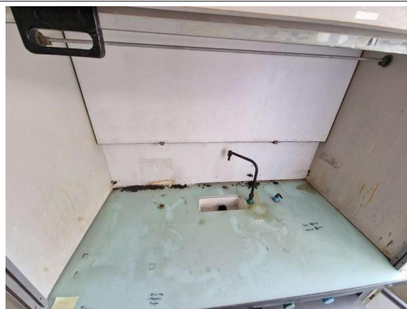
Prélèvement - P9 : ZONE NORD ROTULE / R+1 / LOCAL ETUDE - Plaque- (Présence d'amiante)
