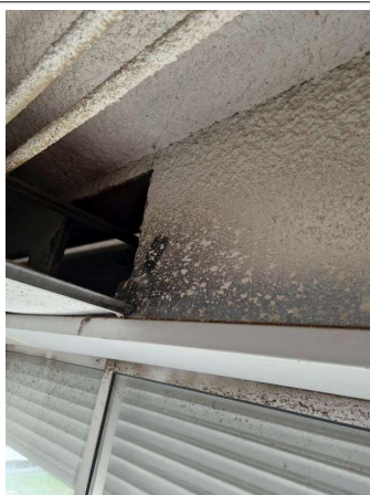
Prélèvement - P8 : ZONE NORD ROTULE / R+1 / LOCAL ETUDE - Panneau- (Présence d'amiante)
