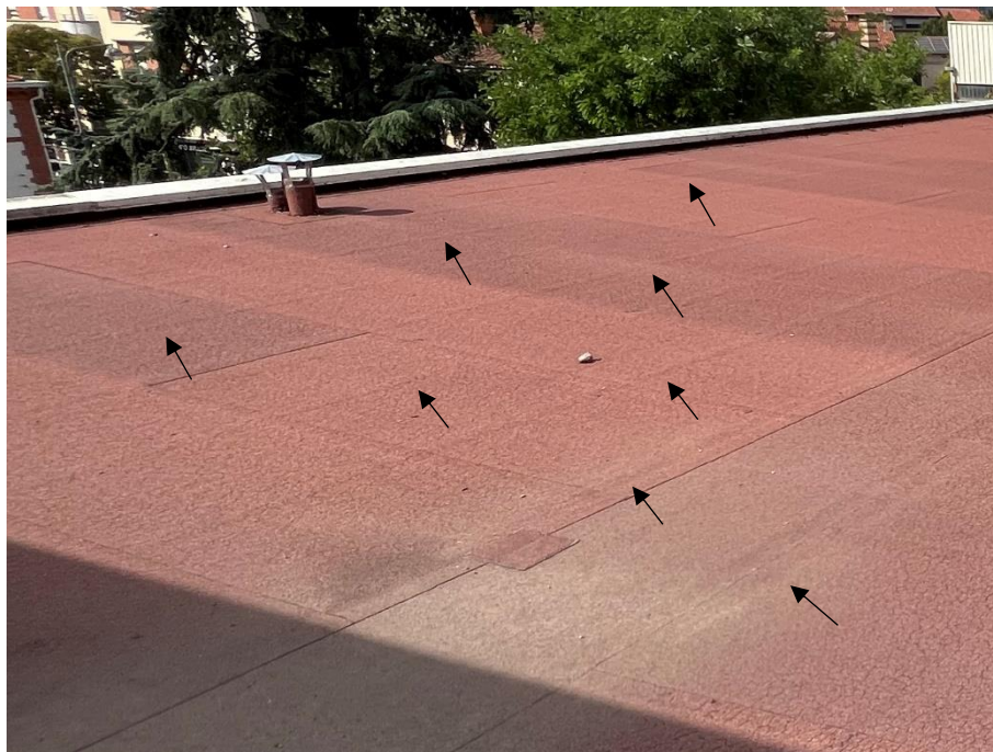
Photographie des plissements des feuilles d'étanchéité
