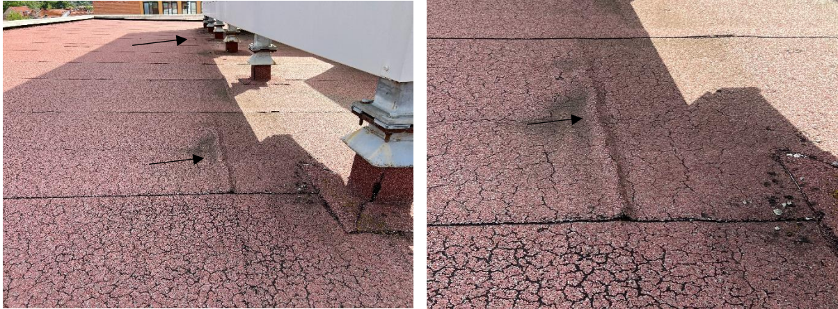
Photographie des plissements les plus importants des feuilles d'étanchéité
