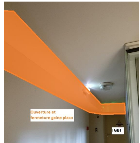
Cheminement dans le SAS ascenseur – Ouverture gaine placo existante
