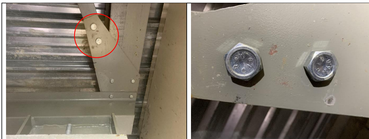
Visualisation de l'assemblage entre IPE, HEA, Croix de Saint-André et un poteau. Boulon M16 6/8 au niveau des croix de Saint-André.
