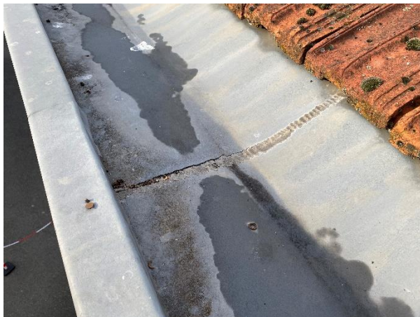
Soudure zinc du chéneau à reprendre
