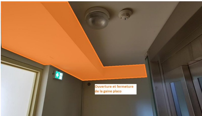
Cheminement dans le SAS ascenseur – Ouverture gaine placo existante
