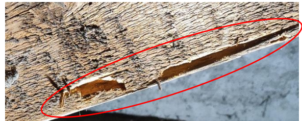
Découverte des galeries au droit d'un trou d'insecte
