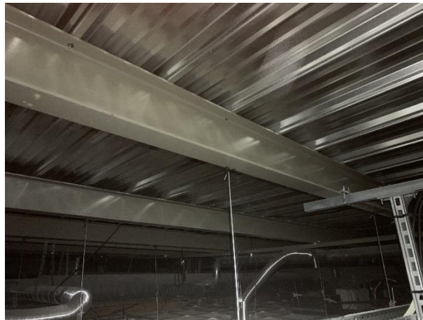
Visualisation du bac acier de la toiture
