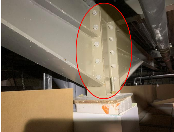
Visualisation de l'assemblage des poutres sur les poteaux au niveau de deux poteaux différents, assemblage par boulon M16 - 8/8 galvanisé
