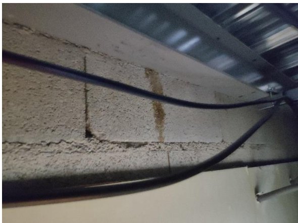
Trace de coulure le long du mur de l'édicule
