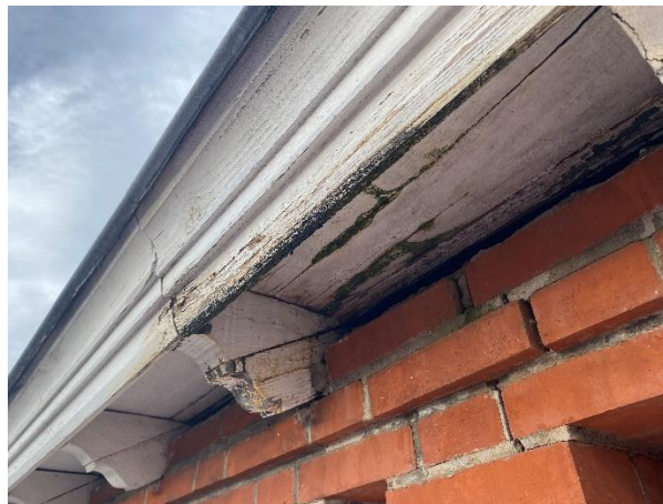
Bois détérioré au droit de la soudure du chéneau à reprendre
