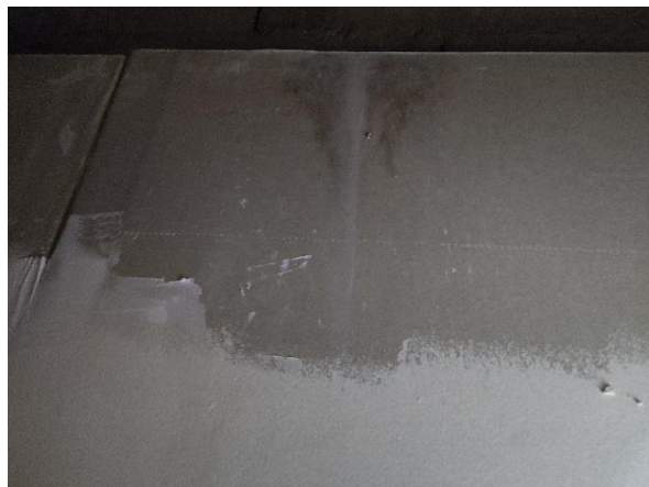
Trace de coulure le long du mur de l'édicule
