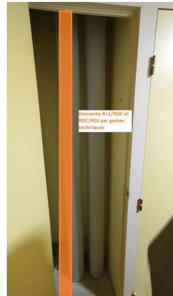
Descente R+1/RDC et RDC/RDJ par gaines techniques
