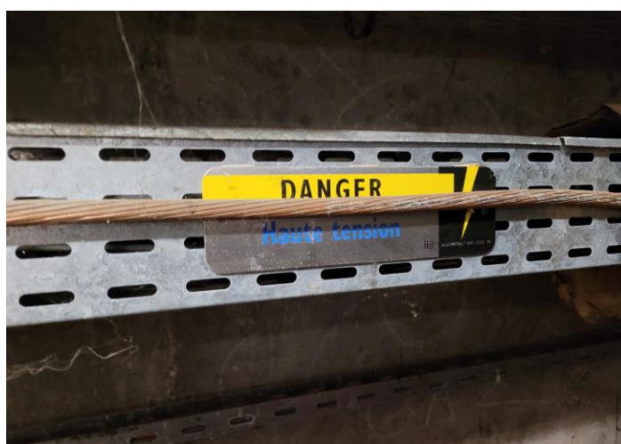
Vue du couloir technique et du chemin de câbles capoté dédié HTA existant
