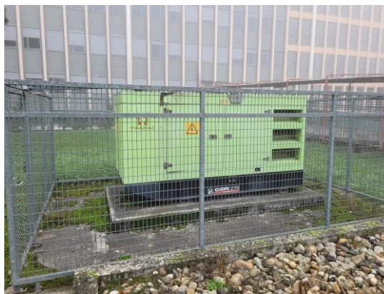
Vue du groupe électrogène extérieur Pramac GSW275 de 275 kVA pour le secours
