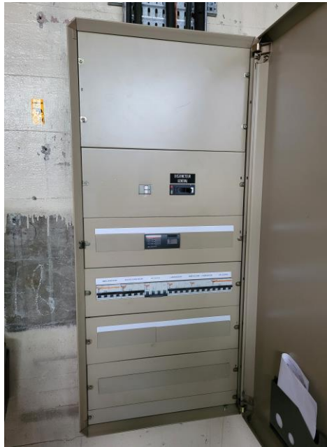
Vue de l'armoire électrique secourue de 160A par le groupe électrogène extérieur de la zone (pour mémoire), mais pas ondulée
