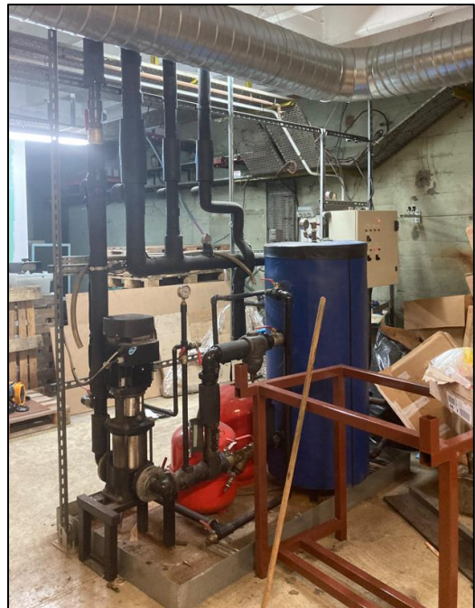
Groupe froid et panoplie hydraulique existante en sous-station à déposer
