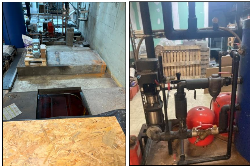
Zone pour les nouvelles panoplies d'eau glacée IP2I et socles existants / Panoplie existante à déposer
