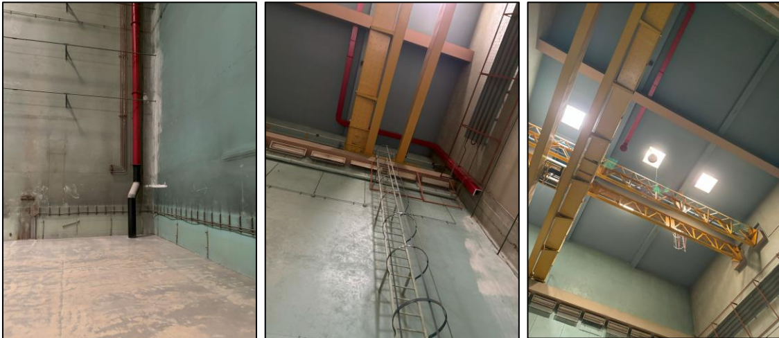
Conduits d'évacuation d'air, panneaux rayonnants et luminaires en partie haute zone diamant
