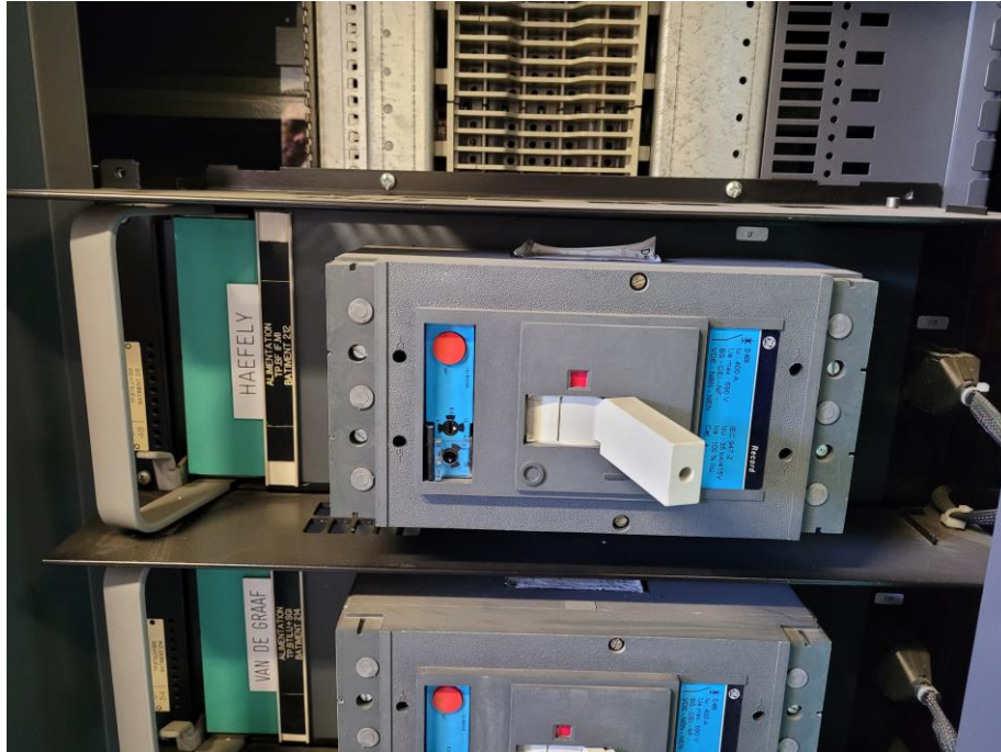
Vue du départ de marque GE, série « Record D400 », réglage à 1, de calibre 400 A alimentant le bâtiment Haefely
