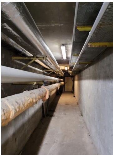
Vue du couloir technique et du chemin de câbles capoté dédié HTA existant
