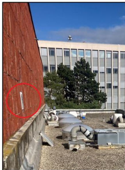
Pénétration des nouveaux réseaux vers la zone implanteur (four)
