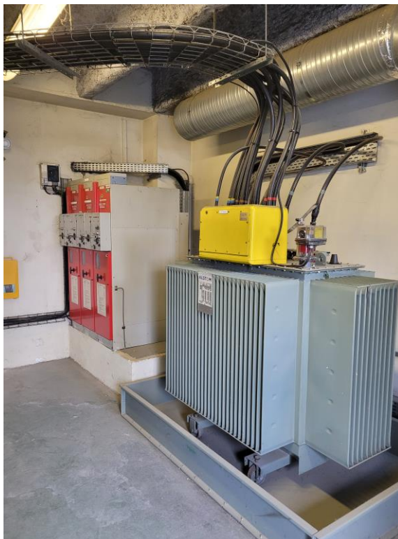
Vue du transformateur HT/BT T07 Nord du bâtiment Dirac de 800 kVA, avec son TGBT de répartition Basse Tension associé
