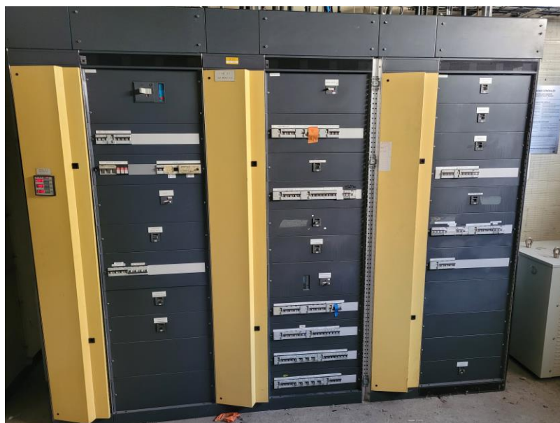
Vue du TPBT du bâtiment Haefely existant de 400A triphasé
