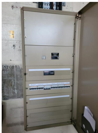
Vue de l'armoire électrique secourue de 160A par le groupe électrogène extérieur de la zone pour le bâtiment Haefely (dans le local TPBT existant)
