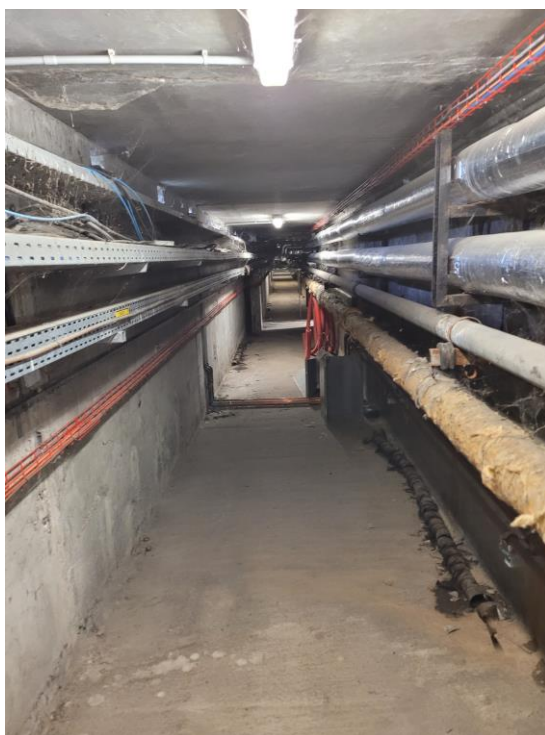
Vue de la galerie technique, et de la pénétration du HTA vers le bâtiment Dirac
