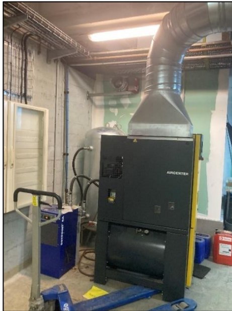
Compresseur d'air en local technique au sous-sol
