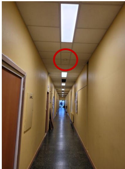
Vue de détecteurs automatiques d'incendie en circulation du bâtiment Haefely (exemple)
