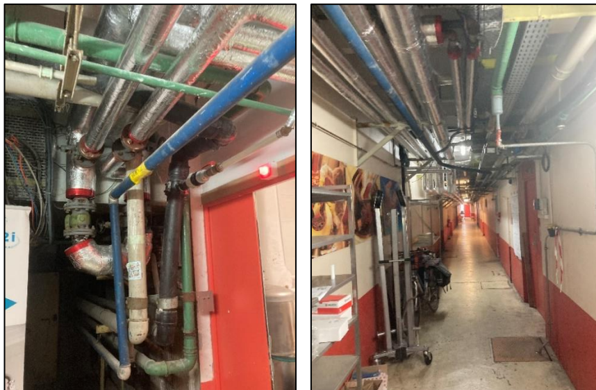
Arrivée d'eau froide (en bleu) et alimentation d'air comprimé (en vert)
