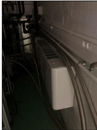
Ventilo-convecteur du local technique dans la zone cryogénie
