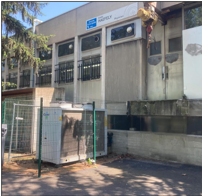
Groupe froid et panoplie hydraulique existante en sous-station à déposer
