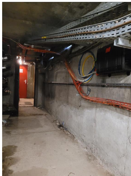
Vue de la galerie technique, et de la pénétration du HTA vers le bâtiment Dirac
