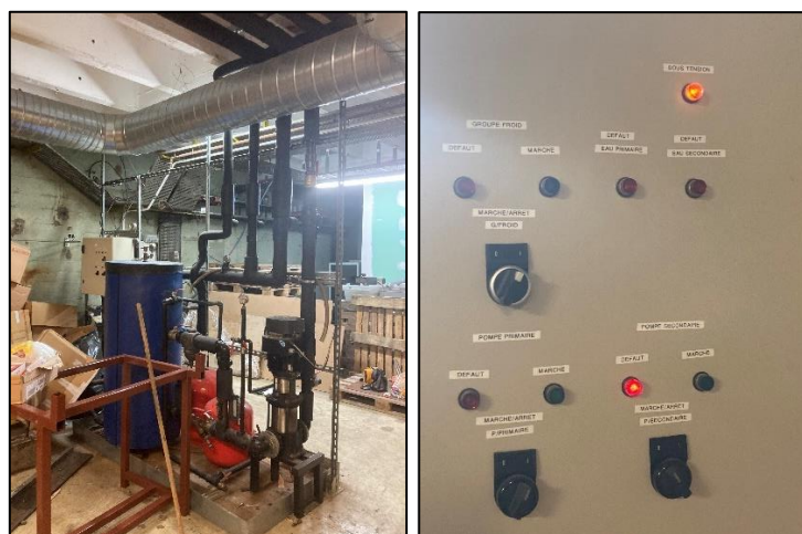
Panoplie de distribution d'eau glacée dans le local 09-019 / Armoire électrique
