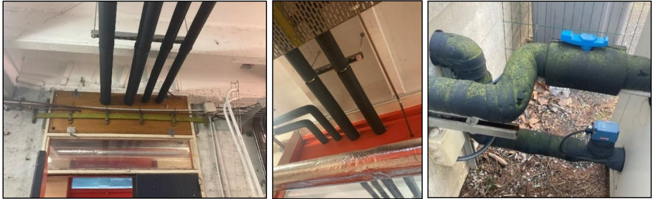
Pénétration des réseaux existants d'eau glacée dans le bâtiment / dans le local technique
