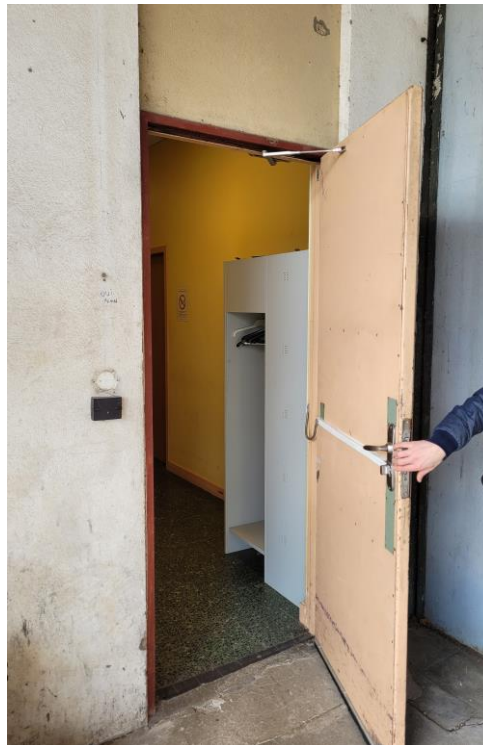
Vue de la porte existante équipée en contrôle d'accès par lecteur de badges
