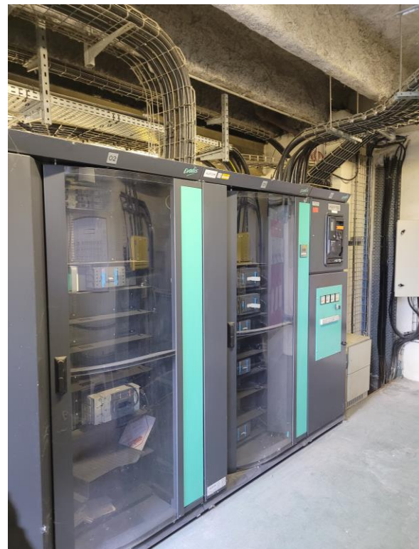
Vue du transformateur HT/BT T07 Nord du bâtiment Dirac de 800 kVA, avec son TGBT de répartition Basse Tension associé
