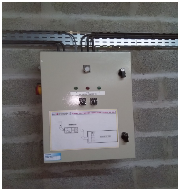
Figure 20: Armoire électrique pour la CTA d'extraction
