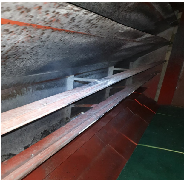
Figure 9: Face avant du piège à balles derrière les rideaux anti-retours
