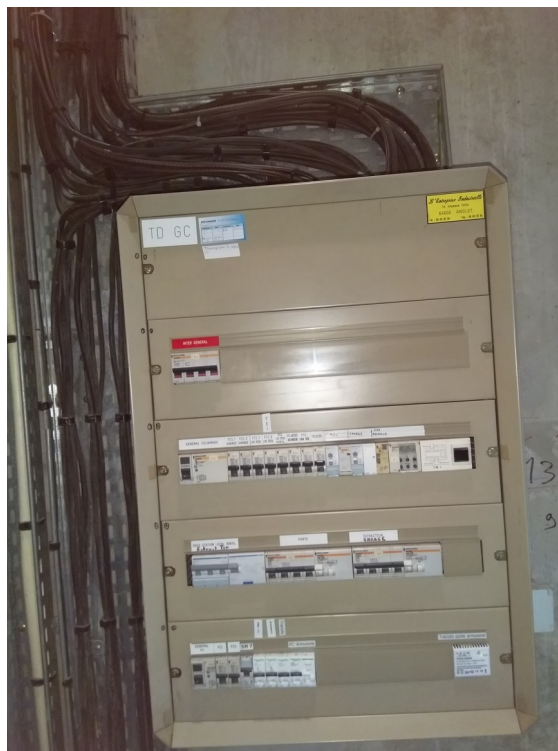
Figure 19: Armoire électrique pour la CTA de soufflage
