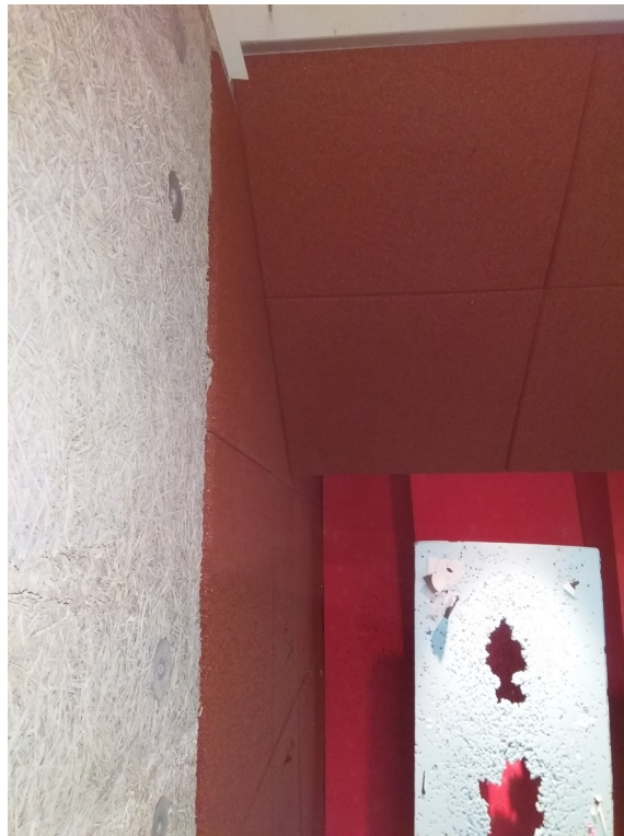
Figure 8: Finition existante de la protection mural du tunnel de tir
