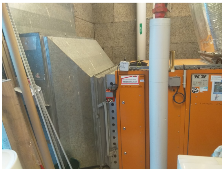
Figure 14: Centrale de soufflage - Vue sur prise d'air neuf
