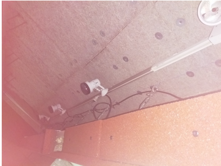
Figure 5: Éclairage de cibles derrière le déflecteur en partie haute devant le piège à balles
