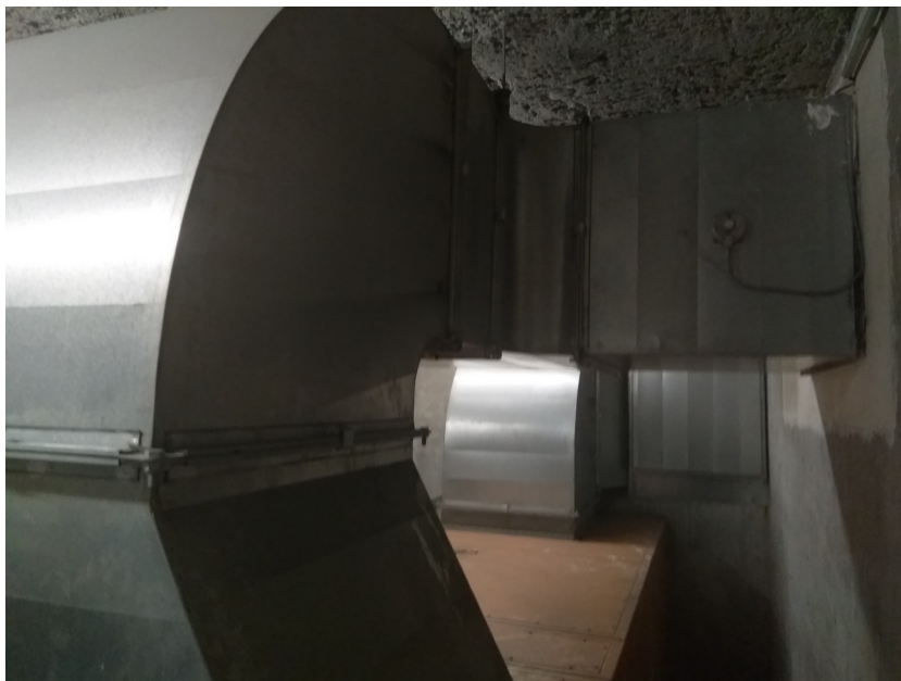
Figure 18: Réseau d'extraction derrière le piège à balles
