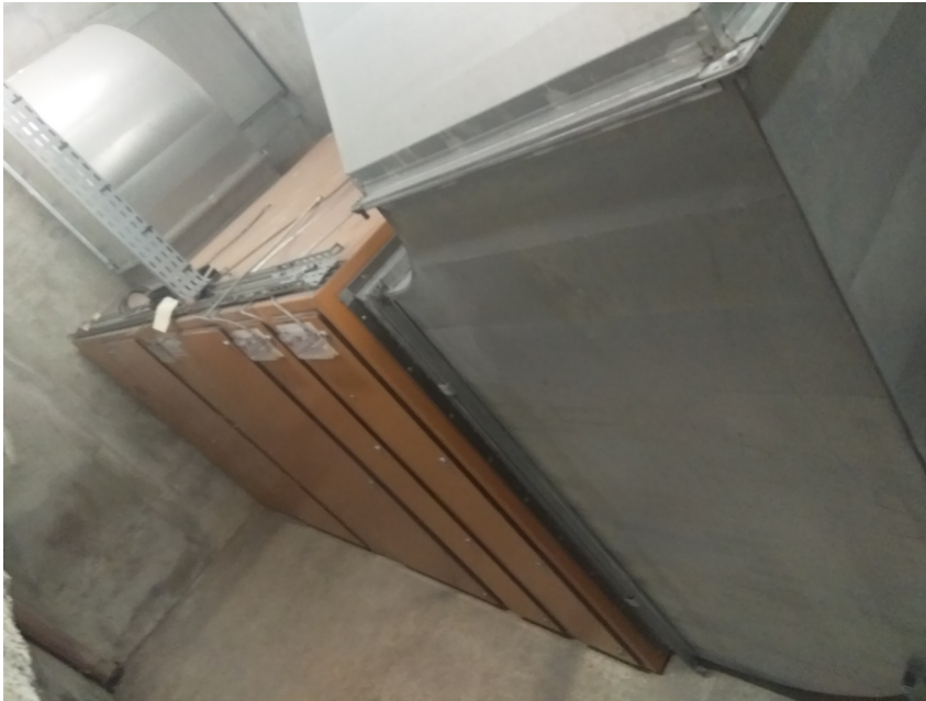
Figure 17: Centrale d'extraction de l'air vicié
