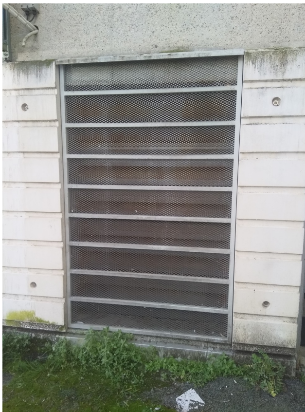
Figure 13: Grille de prise d'air neuf
