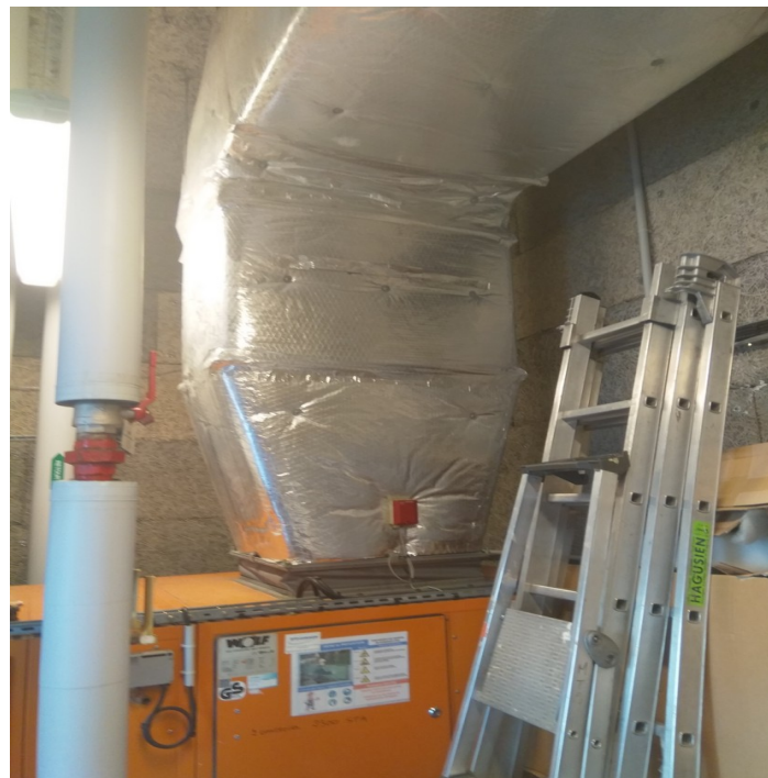
Figure 16: Départ du réseau de soufflage vers le stand de tir
