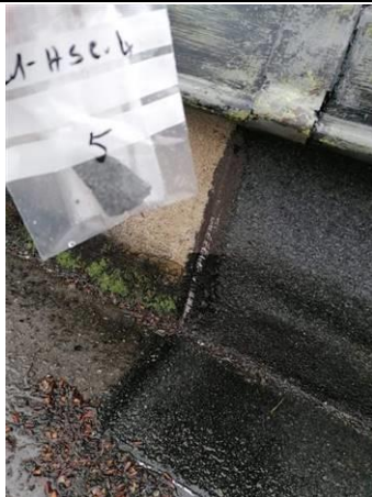
Photo n° PhA005 Localisation : Toiture-terrasse 1 Ouvrage : Relevé Description : Revêtement bitumineux noir ardoisé Localisation sur croquis : 5 Amiante : Non détecté
