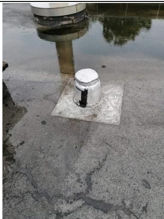
Photo n° PhA010 Localisation : Toiture-terrasse 2 Description : Conduits bouchés non vérifiables Localisation sur croquis : V. 1
