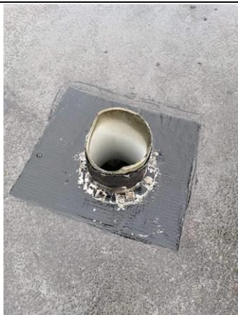
Photo n° PhA011 Localisation : Toiture-terrasse 2 Description : Conduit en Amiante ciment Localisation sur croquis : V. 2 Amiante : Présence
