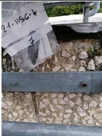
Photo n° PhA007 Localisation : Toiture-terrasse 2 Ouvrage : Relevé Description : Pax alu + revêtement bitumineux noir Localisation sur croquis : 7 Amiante : Non détecté
