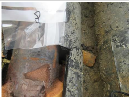
Photo n° PhA008 Localisation : Réseau primaire HC Ouvrage : Calorifugeage Description : Caoutchouc Localisation sur croquis : 8 Amiante : Non détecté
