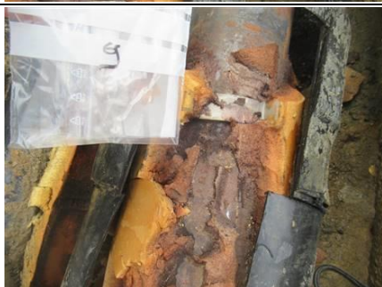
Photo n° PhA009 Localisation : Réseau primaire HC Ouvrage : Calorifugeage Description : Mousse compacte jaune Localisation sur croquis : 9 Amiante : Non détecté
