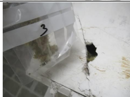
Photo n° PhA003 Localisation : Sous-Sol - Gaine de ventilation Ouvrage : Gaine de ventilation Description : Fibres beiges Localisation sur croquis : 3 Amiante : Non détecté
