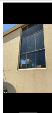
Prélèvement - P011 : Bâtiment / Extérieur / Façade 4 - Mastic- (Présence d'amiante)
