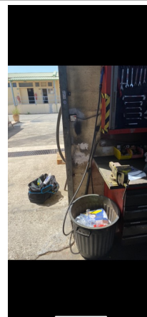
Prélèvement - P002 : Bâtiment / R+0 / Hangar - Enduit- (Présence d'amiante)
