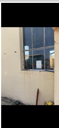
Prélèvement - P010 : Bâtiment / Extérieur / Façade 3 - Mastic- (Présence d'amiante)
