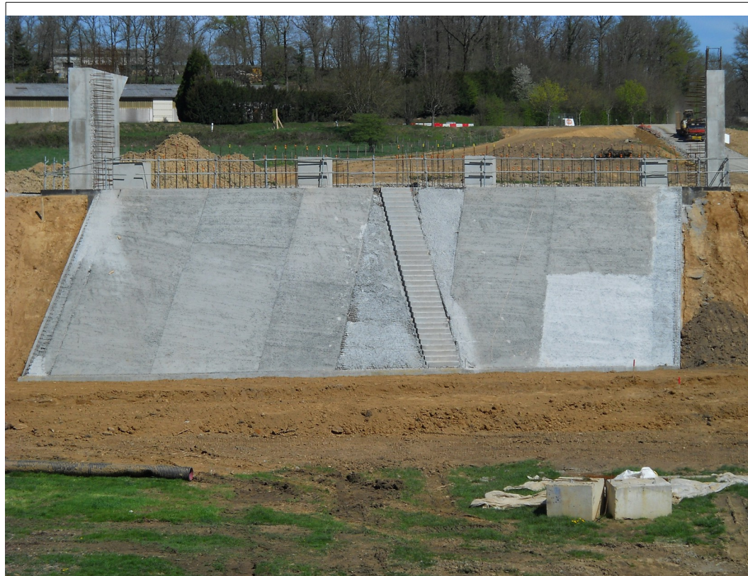
Illustration 18: Perré en construction (déviation de Chabanais - 04/2011)
