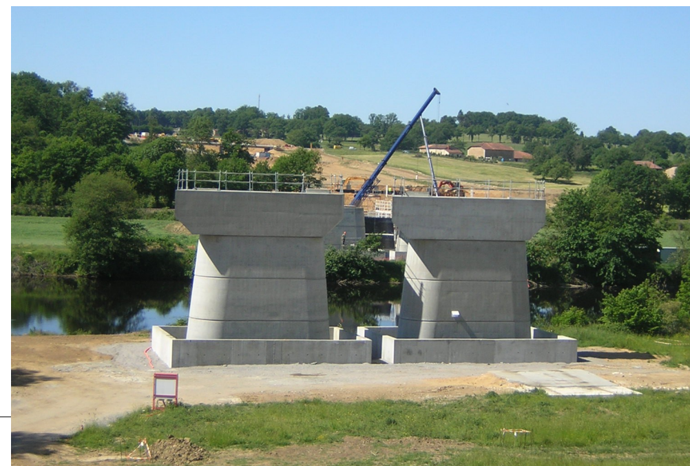
Illustration 17: Construction des piles (déviations de Chabonais - 06/2011)
