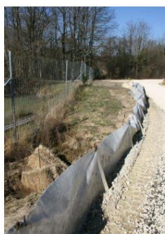
Figure 99 : Exemple de protection contre la diffusion des boues et poussières de chantier en bordure de piste
