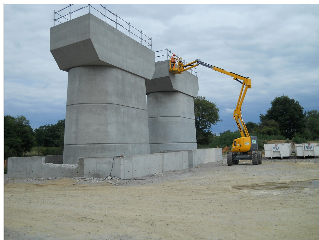
Illustration 16: Construction des piles (déviations de Chabonais - 06/2011)
