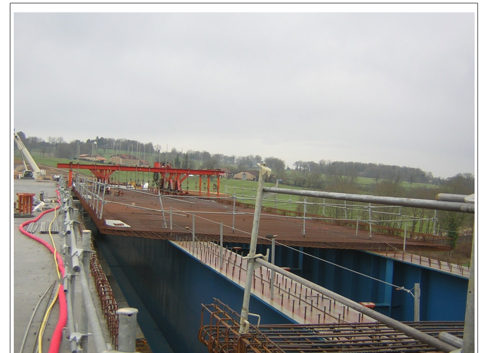
Illustration 19: Construction d'un tablier (source inconnue)
