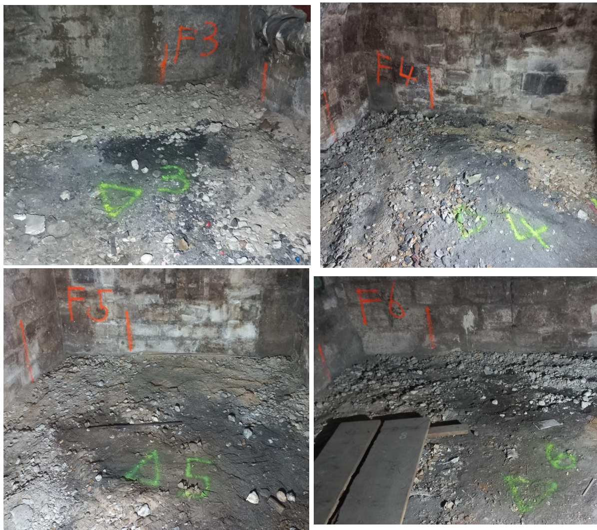
Photo 2: Implantations des sondages PD3 à PD6 au 2 ème sous-sol côté rue Sébastopol
