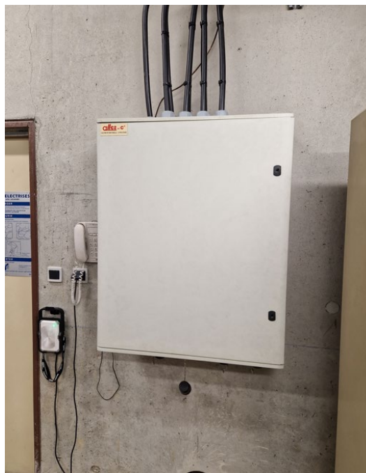
Armoire de raccordement GEM
