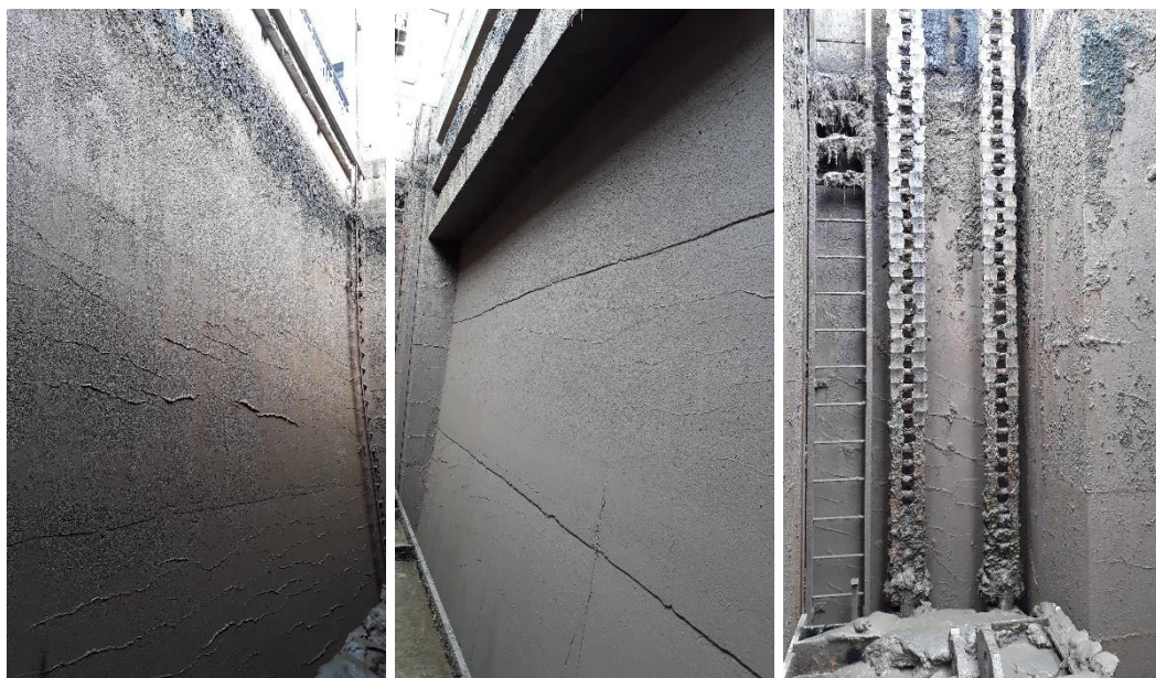
Figure 28 : fissures de surface, rive à rive, sur le masque aval (gauche), le contremasque (milieu), et dans la rainure (droite)
