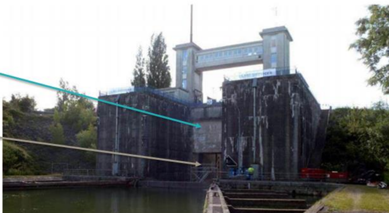
Pertuis libéré par la porte levante et position du mur masque
