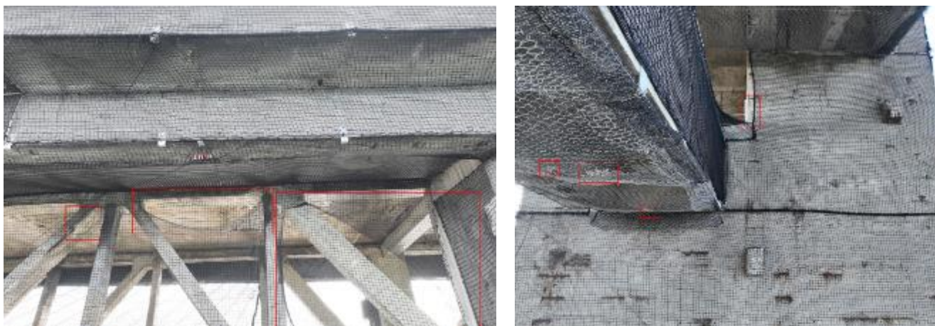
Exemples de dégradations (filets déchirés, bloc en suspend)
