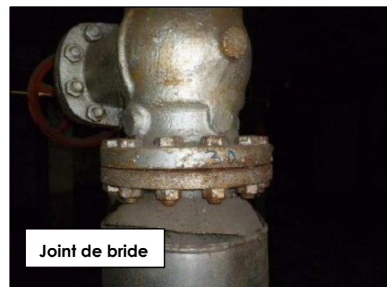
Figure 16 : Matériaux et produits contenant de l'amiante présents sur site (non exhaustif)
