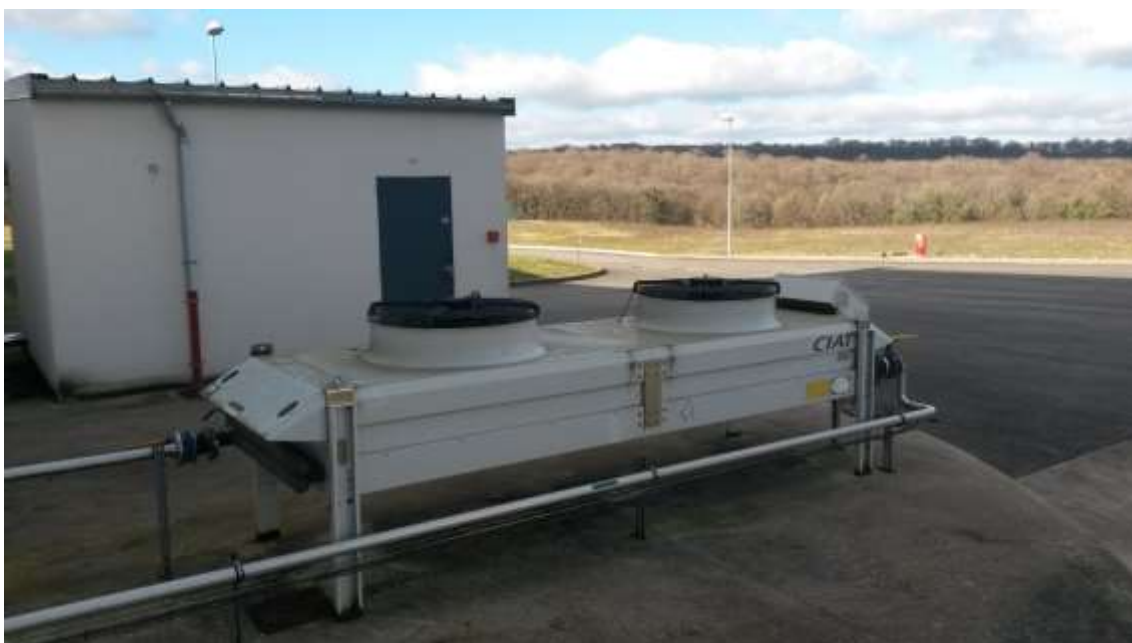
Figure 10 : photographie de l'aérotherme CIAT situé en périphérie de l'atelier 8102
