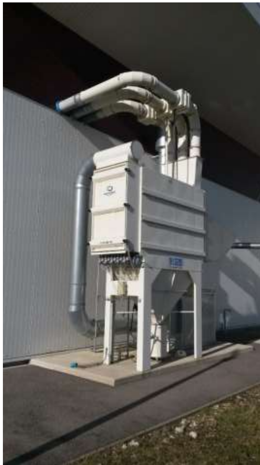
Figure 11 : photographie de la centrale d'aspiration située en périphérie de l'atelier 8102
