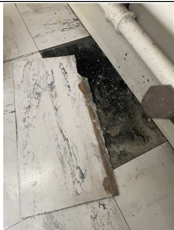
Photo n° PhA007 Localisation : 2ème étage - B23 Ouvrage : 5 - Planchers et planchers techniques - Revêtements de sols Partie d'ouvrage : Dalle de sol Description : Colle bitumineuse noire ragréage gris
