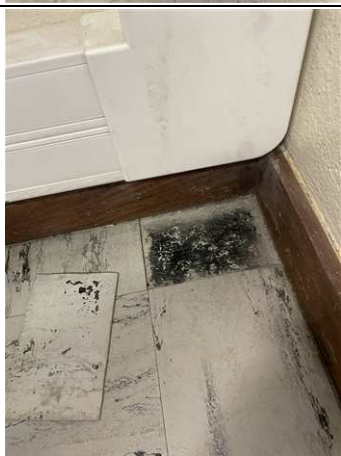
Photo n° PhA014 Localisation : 1er étage - B13; 1er étage - B14 Ouvrage : 5 - Planchers et planchers techniques - Revêtements de sols Partie d'ouvrage : Dalle de sol Description : Colle bitumineuse noire non séparable ragréage gris non séparable
