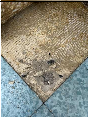
Photo n° PhA010 Localisation : 1er étage - B10 Ouvrage : 5 - Planchers et planchers techniques - Revêtements de sols Partie d'ouvrage : Ragréege Description : Colle bitumineuse noire colle polymère jaune
