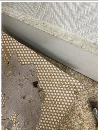
Photo n° PhA008 Localisation : 2ème étage - 216 Ouvrage : 5 - Planchers et planchers techniques - Revêtements de sols Partie d'ouvrage : Ragréege Description : Colle bitumineuse noire
