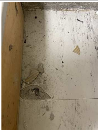
Photo n° PhA009 Localisation : 2ème étage - 214 Ouvrage : 5 - Planchers et planchers techniques - Revêtements de sols Partie d'ouvrage : Dalle de sol Description : Colle bitumineuse noire non séparable ragréege gris non séparable
