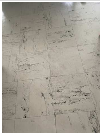
Photo n° PhA004 Localisation : 2ème étage - 215 Ouvrage : 5 - Planchers et planchers techniques - Revêtements de sols Partie d'ouvrage : Dalle de sol Description : Dalle dure cassante grise
