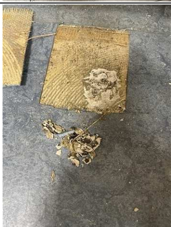
Photo n° PhA017 Localisation : Rez de chaussée - 014; Rez de chaussée - 012 Ouvrage : 5 - Planchers et planchers techniques - Revêtements de sols Partie d'ouvrage : Dalle de sol Description : Ragraéage gris colle bitumineuse noire
