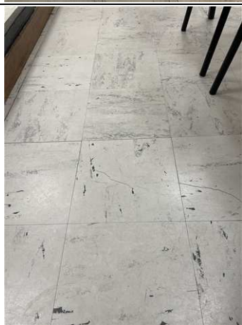
Photo n° PhA006 Localisation : 2ème étage - B23 Ouvrage : 5 - Planchers et planchers techniques - Revêtements de sols Partie d'ouvrage : Dalle de sol Description : Dalle dure cassante beige
