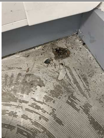
Photo n° PhA012 Localisation : 1er étage - B12 Ouvrage : 5 - Planchers et planchers techniques - Revêtements de sols Partie d'ouvrage : Ragrée Description : Colle bitumineuse noire ragréage rose
