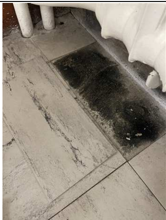
Photo n° PhA015 Localisation : 1er étage - 110 Ouvrage : 5 - Planchers et planchers techniques - Revêtements de sols Partie d'ouvrage : Dalle de sol Description : Dalle dure cassante grise
