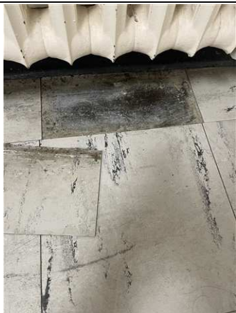
Photo n° PhA016 Localisation : 1er étage - 113 Ouvrage : 5 - Planchers et planchers techniques - Revêtements de sols Partie d'ouvrage : Dalle de sol Description : Dalle dure cassante beige
