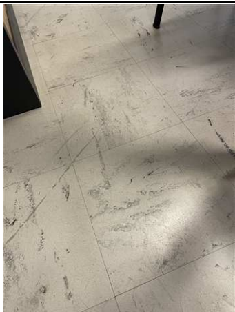
Photo n° PhA013 Localisation : 1er étage - B13; 1er étage - B14 Ouvrage : 5 - Planchers et planchers techniques - Revêtements de sols Partie d'ouvrage : Dalle de sol Description : Dalle dure cassante grise
