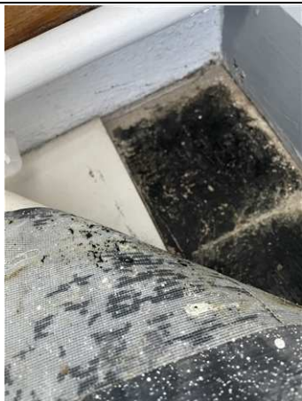
Photo n° PhA011 Localisation : 1er étage - B11 Ouvrage : 5 - Planchers et planchers techniques - Revêtements de sols Partie d'ouvrage : Dalle de sol Description : Dalle dure cassante grise
