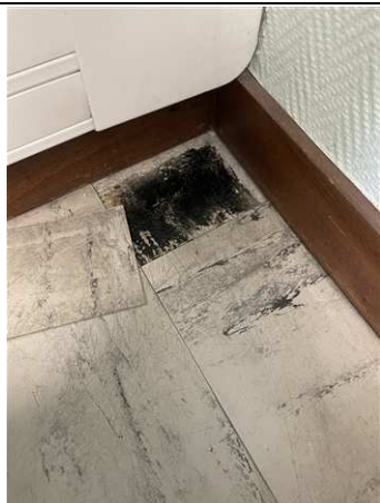
Photo n° PhA005 Localisation : 2ème étage - 215 Ouvrage : 5 - Planchers et planchers techniques - Revêtements de sols Partie d'ouvrage : Dalle de sol Description : Colle bitumineuse noire non séparable ragréage gris non séparable
