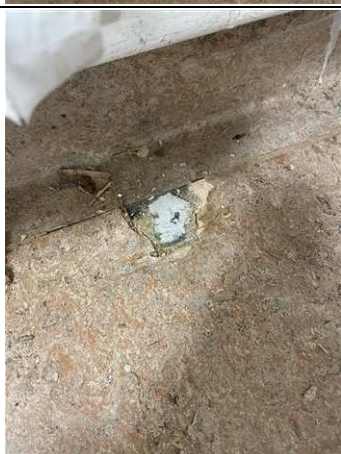
Photo n° PhA019 Localisation : Rez de chaussée - 013 Ouvrage : 5 - Planchers et planchers techniques - Revêtements de sols Partie d'ouvrage : Dalle de sol Description : Ragraéage gris colle bitumineuse noire
